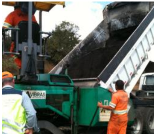
Aplicação da mistura reciclada
