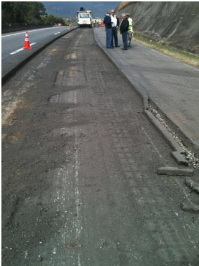
Fresagem do pavimento antigo (processo a frio)
