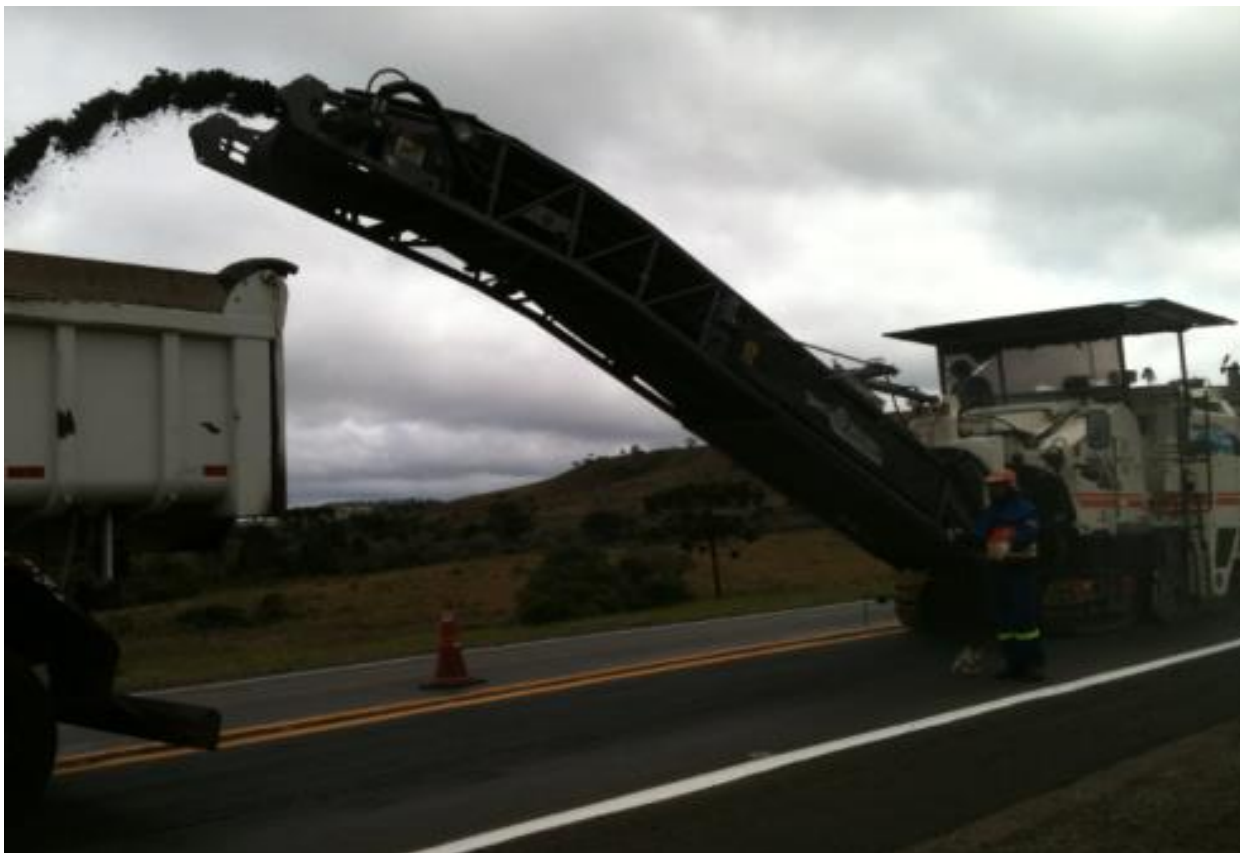
Fresagem do revestimento deteriorado
