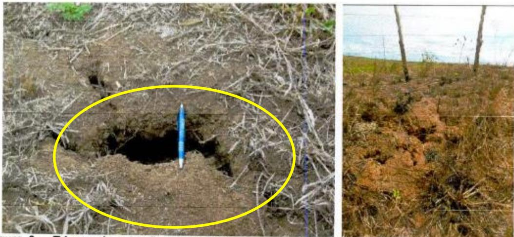
**Figura 8 – Trincas de retração no período seco em local de solos expansivos, quando ocorre evaporação de água do solo, afetando fortemente a rodovia**
