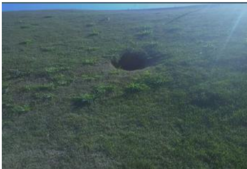
Figura 12- Ponto de Erosão devido à falta de caixa de passagem no talude de alça de retorno do trevo de acesso ao Município de Rondonópolis no km 203+000 da BR-364/MT
