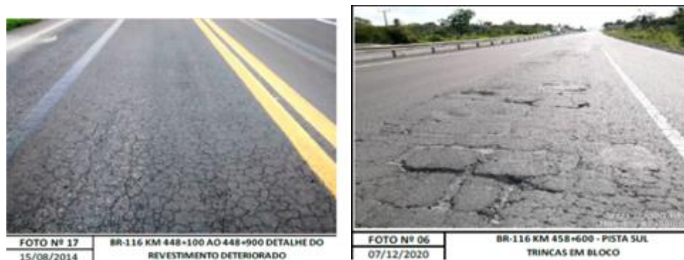
Figura 1 – Trinca FC3 ou couro de crocodilo.
