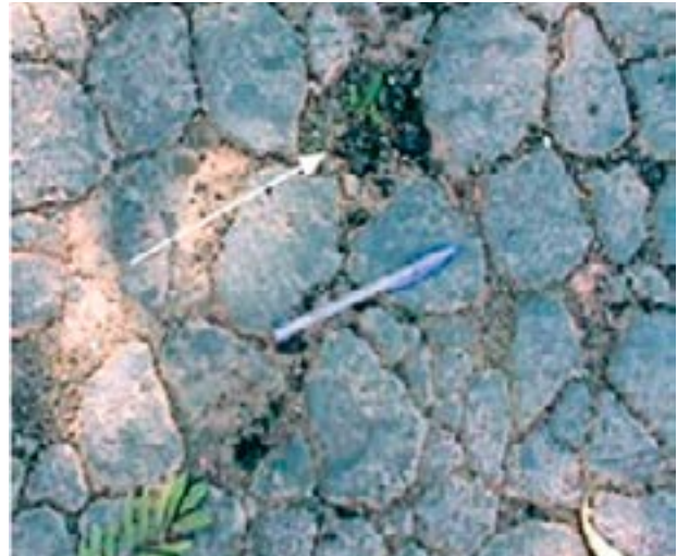
Figura 14- Trincas tipo Couro de Jacaré
