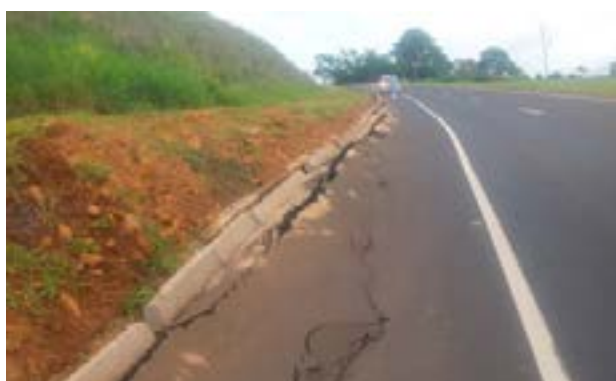
Figura 46- Talude comprometido, causando recalque no acostamento
