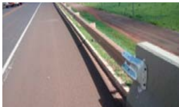
Figura 21 - Defesa Metálica
