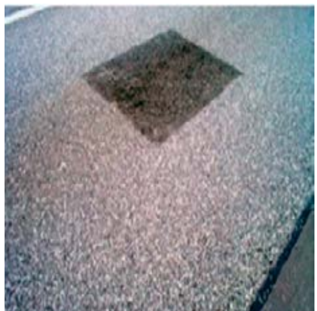
Figura 12- Remendo bem executado
