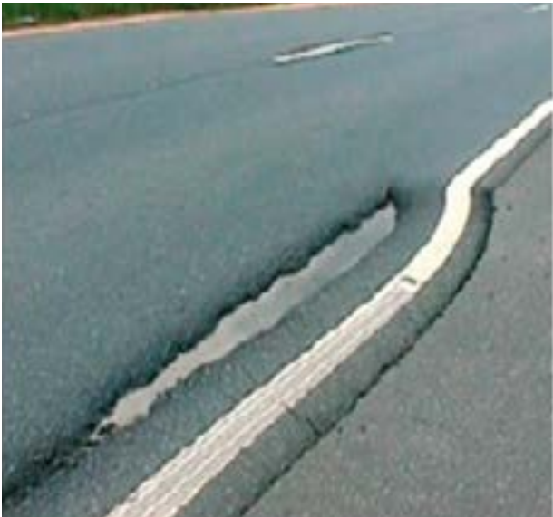
Figura 9 - Escorregamento de Massa Asfáltica
