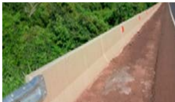
Figura 22- Barreira de Concreto
