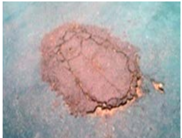
Figura 11 - Remendo mal executado
