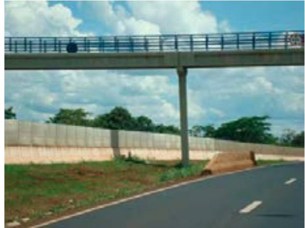
Figura 26- Tela Anti-ofuscante sob Passarela
