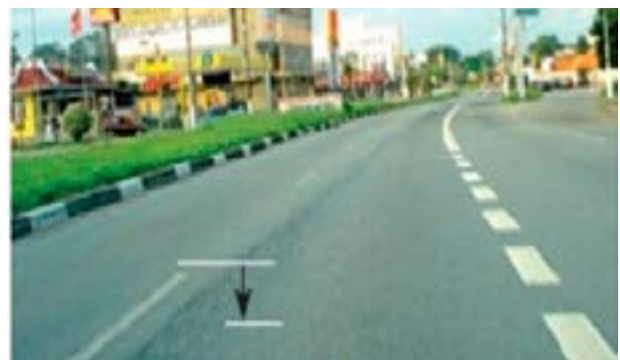
Figura 5 - Desnível entre faixas contínuas
