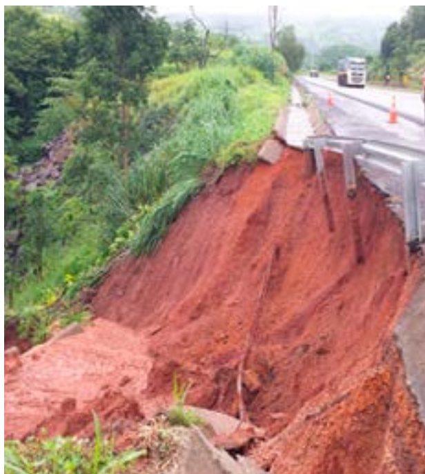
Figura 45- Talude comprometido, causando risco aos usuários
