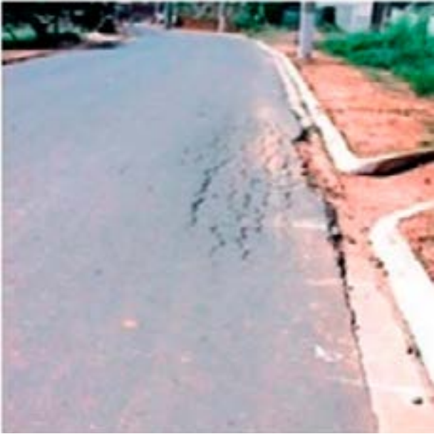
Figura 8 - Depressão no Pavimento
