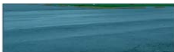
Figura 3 - Flecha em Trilha de Roda
