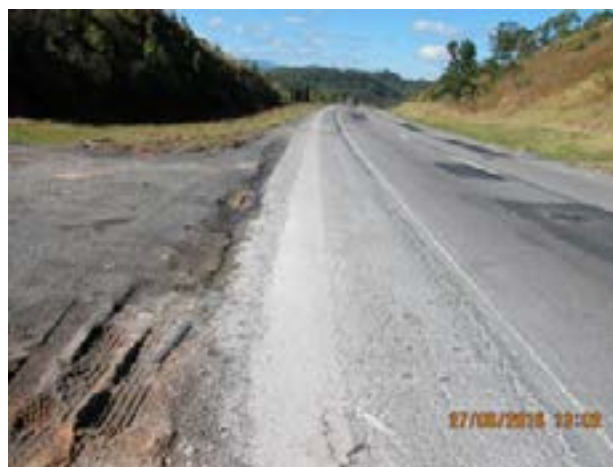
Figura 20 – Áreas excessivamente remendadas
