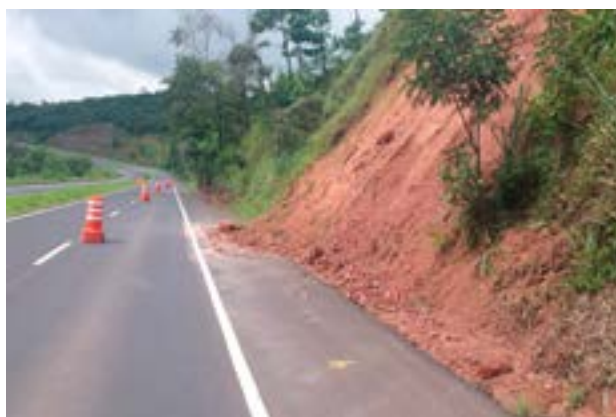
Figura 48- Presença de material resultante de deslizamento a menos de quatro metros das faixas de rolamento
