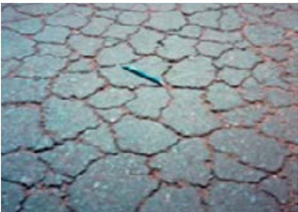
Figura 13- Trincas tipo Couro de Jacaré
