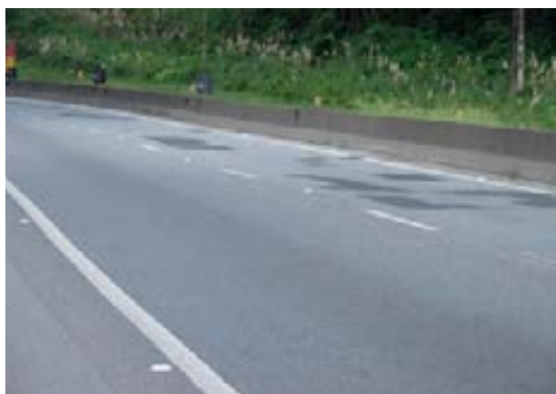
Figura 19 – Áreas excessivamente remendadas
