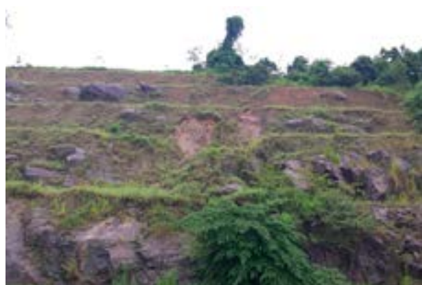
Figura 47- Talude com alto grau de processo erosivo, com risco de desprendimento de rochas
