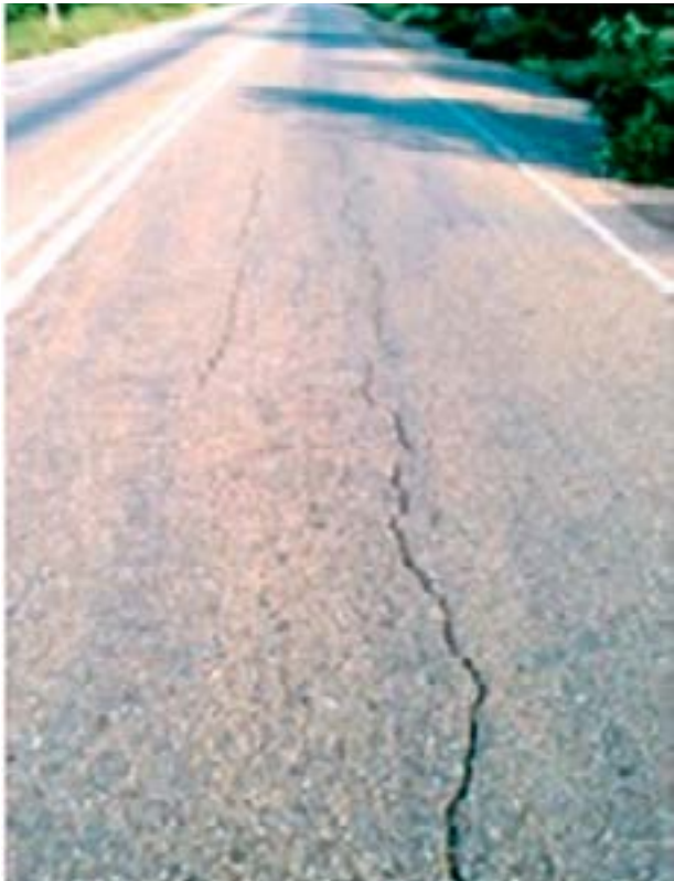
Figura 4 - Trinca Longitudinal
