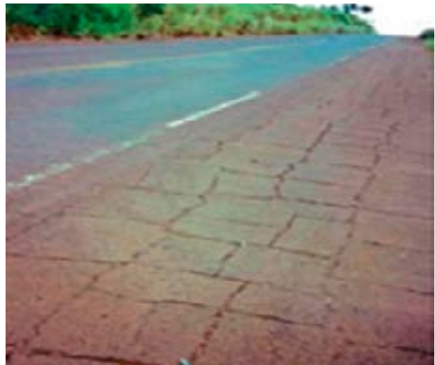
Figura 15- Trincas em Bloco
