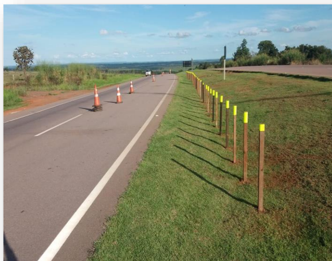
Foto 02 – Implantação de Balizadores e Delineadores Km 775+760 ao 775+810
