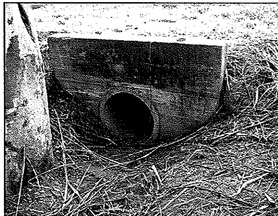
Km 10,300 – Emboque do bueiro
