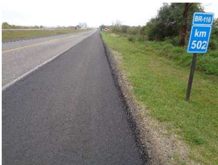
Figura 03 – Recomposição de acostamentos BR-116 km 502+000
