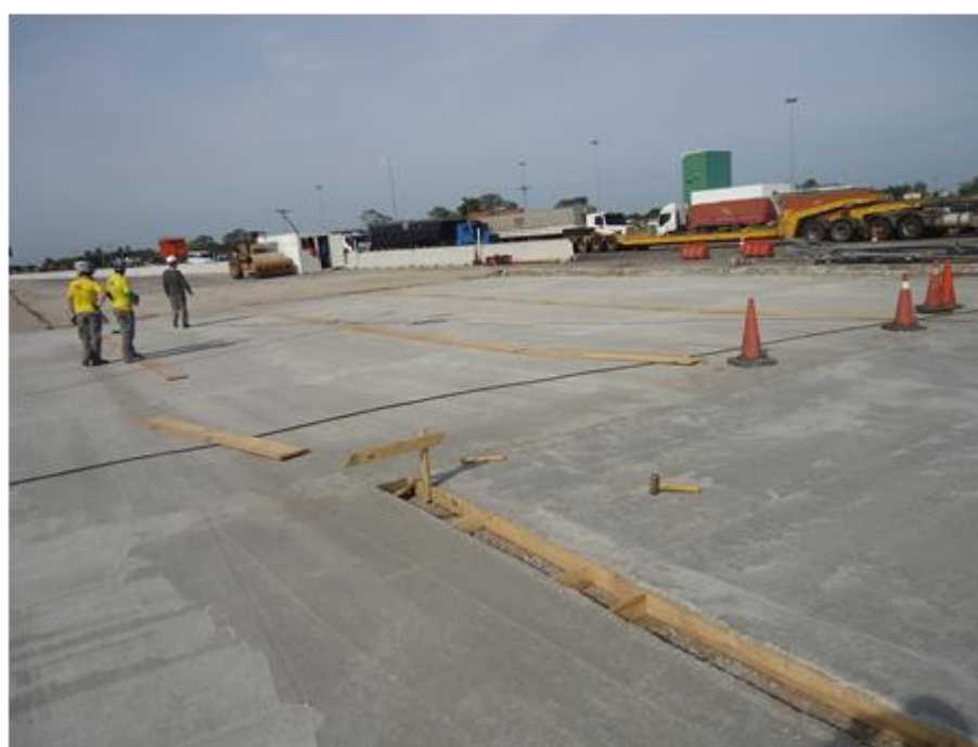
Figura 08 – Ampliação da Praça de Pedágio Capão Seco
