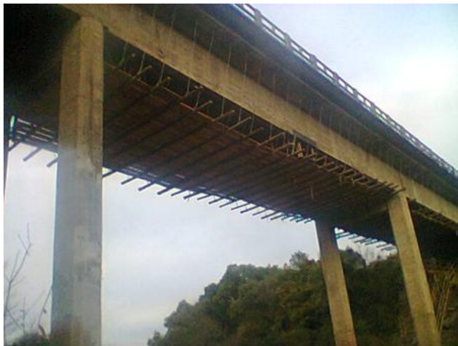
Figura 05 – Obras de Arte Especiais
