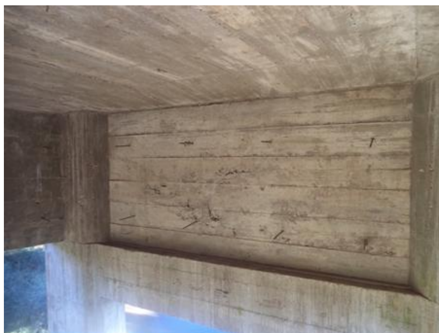
Figura 06 – Obras de Arte Especiais
