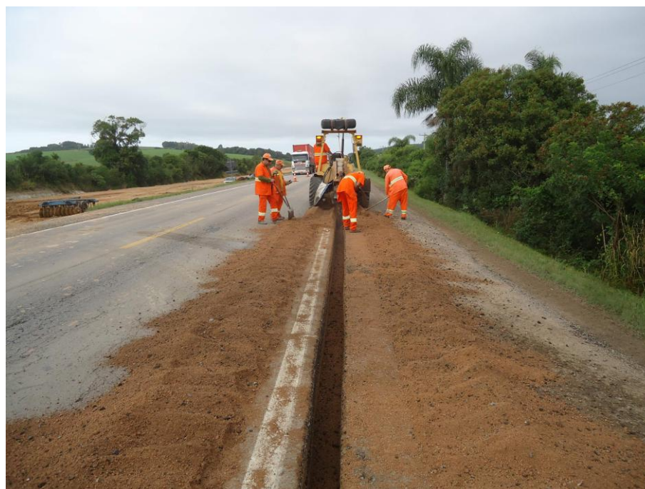
Figura 04 – Drenos de Pavimento
