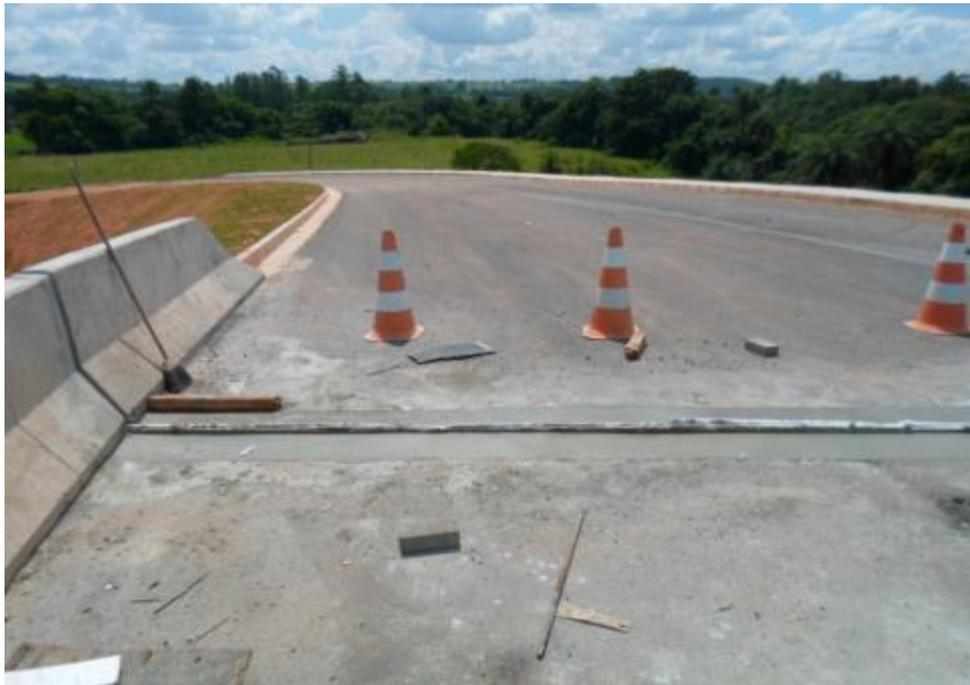
*Figura 05 – Execução de junta jeene*
