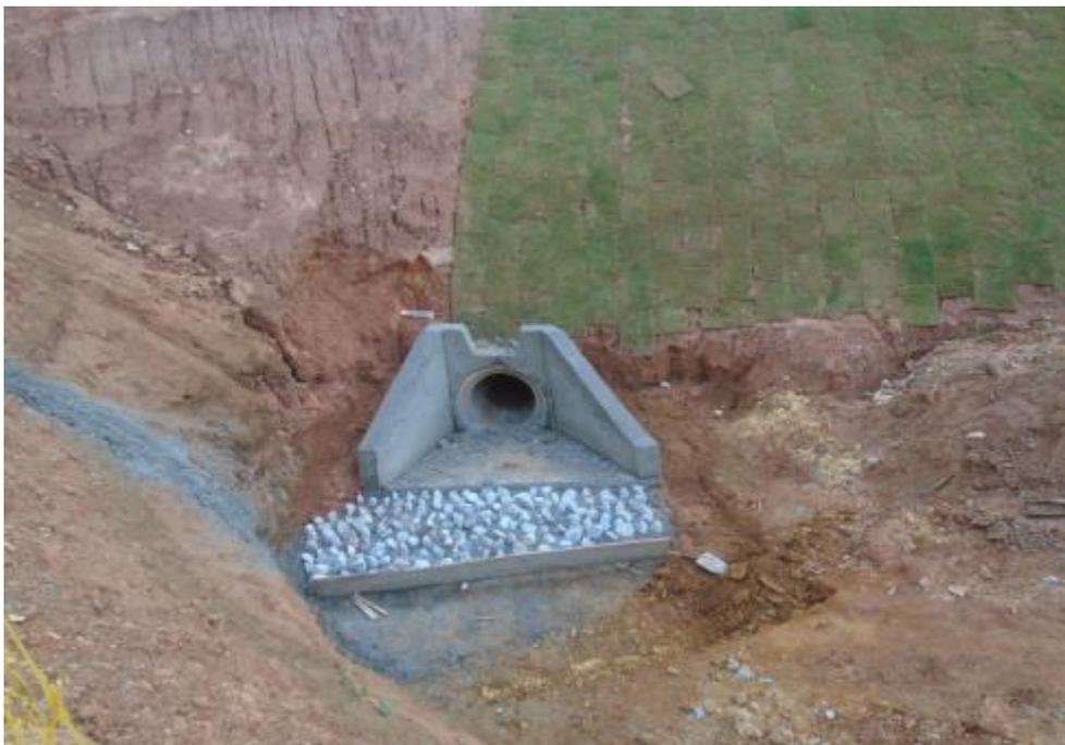
*Figura 04 – Boca de bueiro com dissipador de energia*
