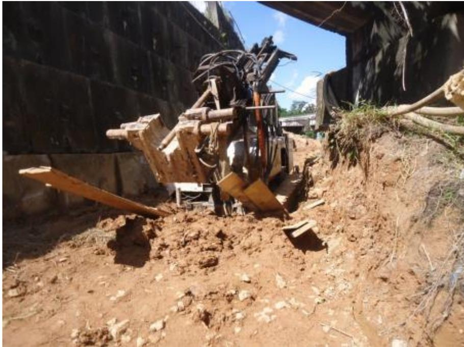
*Figura 03 – Execução das estacas*
