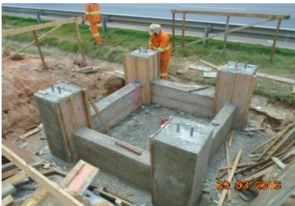
*Figura 02 – Retirada de formas dos pilares pista sul*
