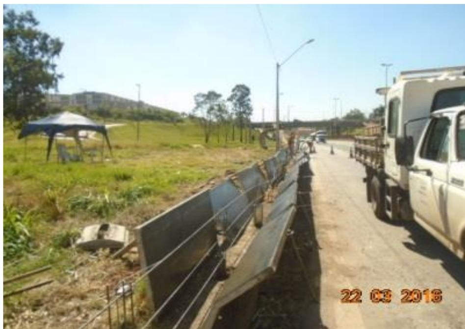
*Figura 05 – Montagem de forma para concretagem de barreira new jersey*
