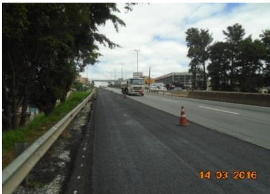
*Figura 06 – Aplicação de microrevestimento*
