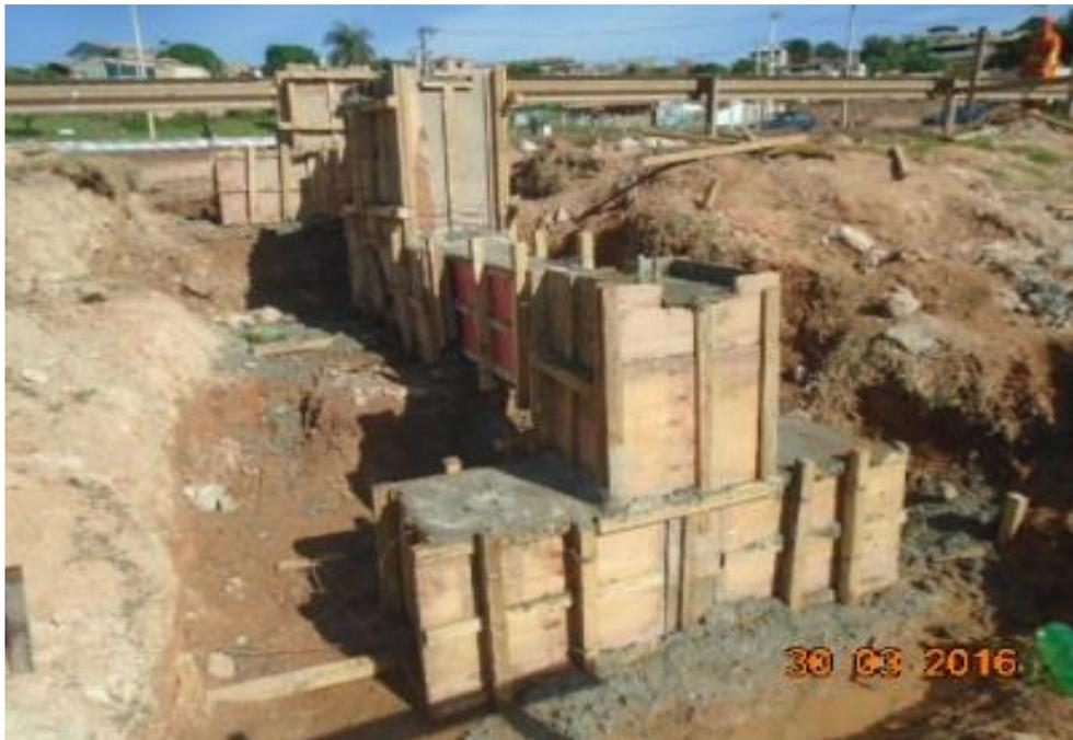
*Figura 05 – Concretagem de pilares pista norte*
