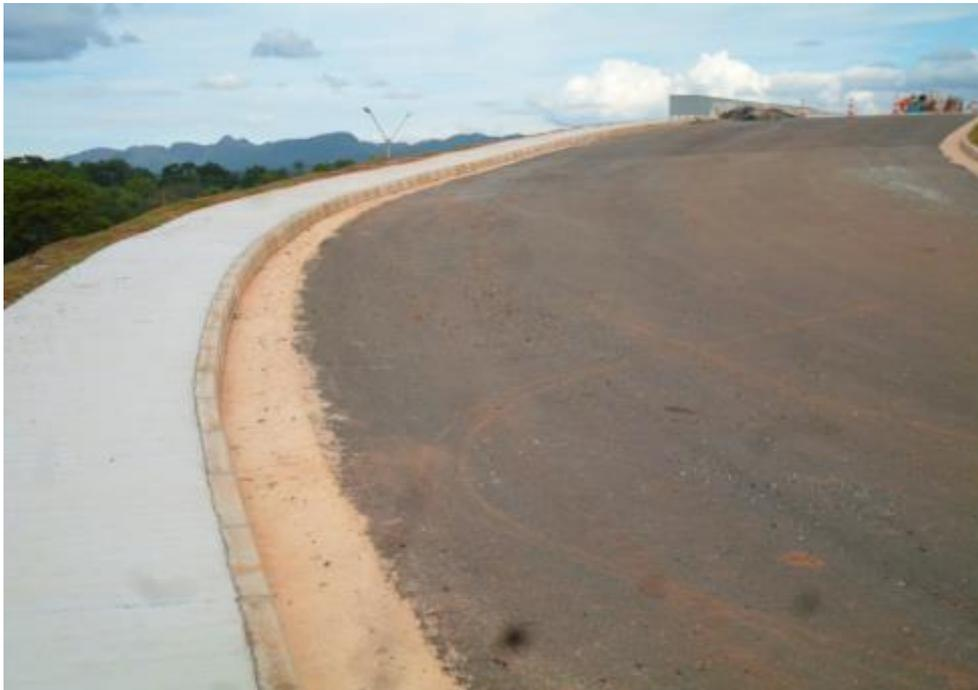
*Figura 03 – Execução de passeio de concreto*
