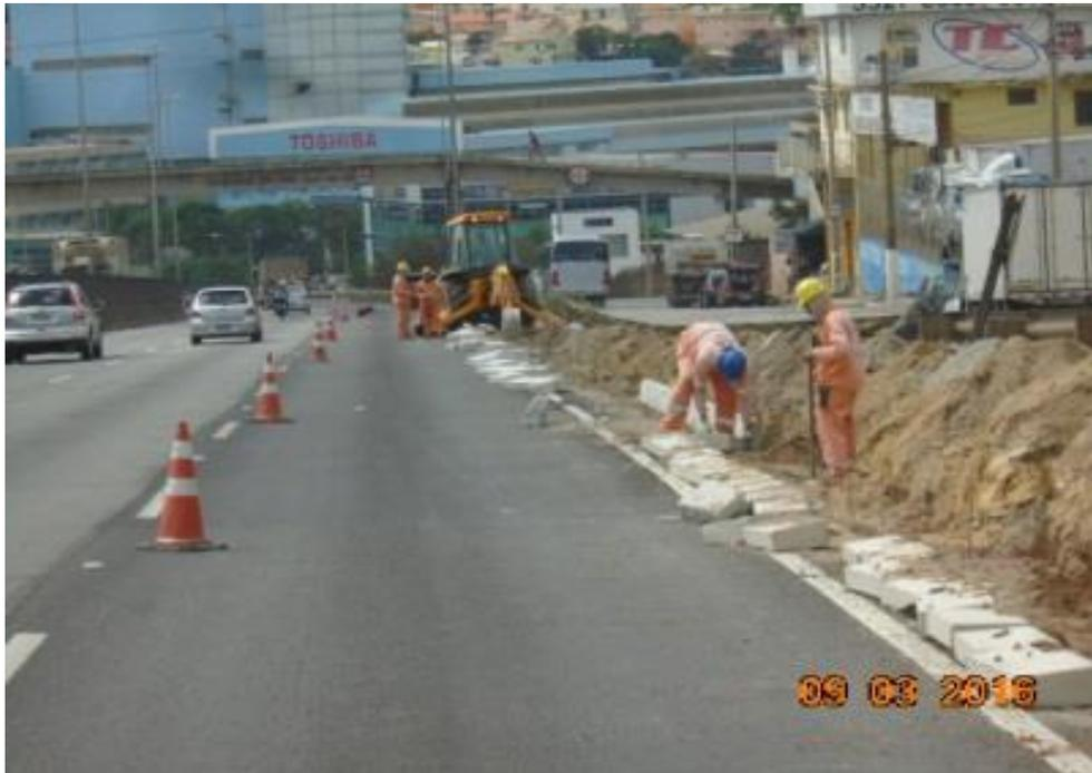
*Figura 01 – Escavação e assentamento de Meio-fio pré-moldado*
