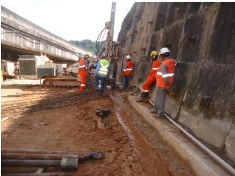
*Figura 04 – Execução das estacas*
