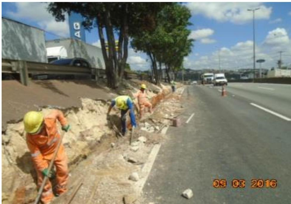
*Figura 02 – Escavação para execução de muro de arrimo*
