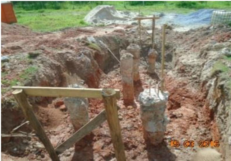
*Figura 03 – Arrasamentos de estacas strauss*
