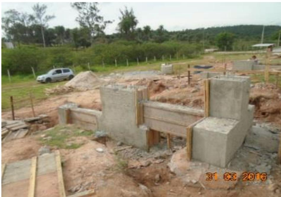
*Figura 06 – Retirada de formas dos pilares pista norte*
