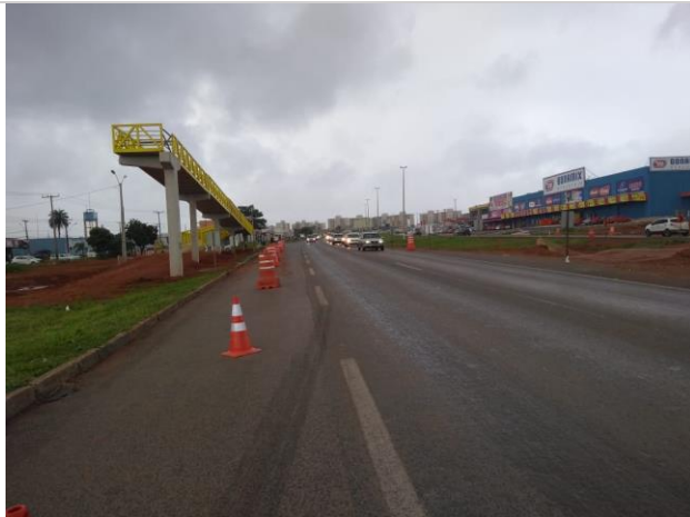
Foto 03: Rampa lado Sul montada
