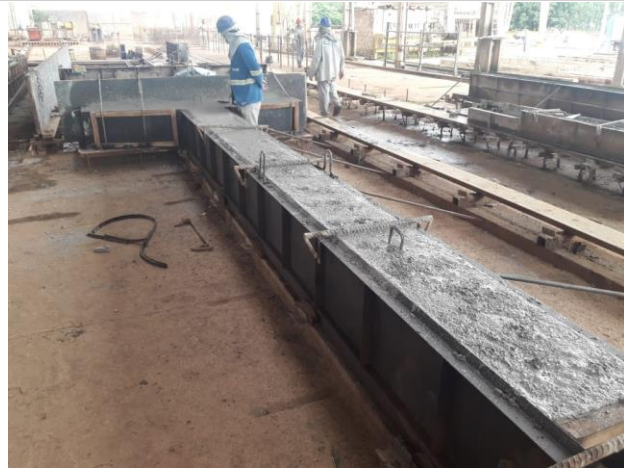
Foto 01: Fabricação dos pilares
