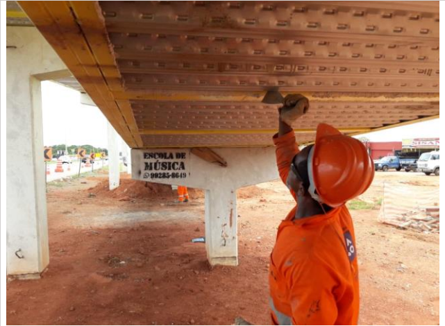
Foto 02: Arremate rampa lado Sul
