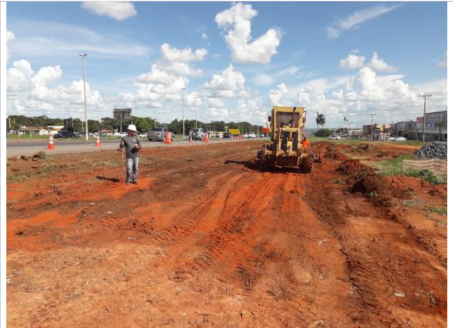
Foto 04: Terraplanagem da baía de ônibus
