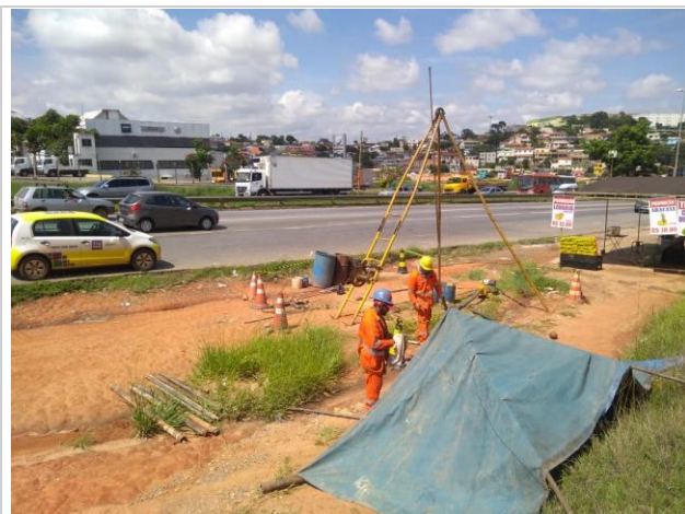
Foto 01: Execução da sondagem
