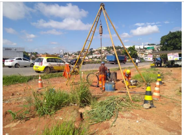
Foto 02: Execução da sondagem
