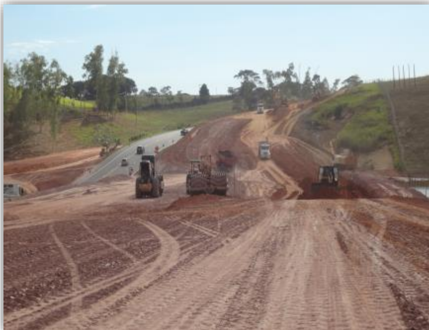
Figura 01 – Aterro na pista norte – km 92,800
