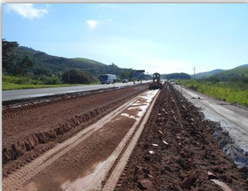
Figura 04 – Homogeneização da terceira camada de solo cal
