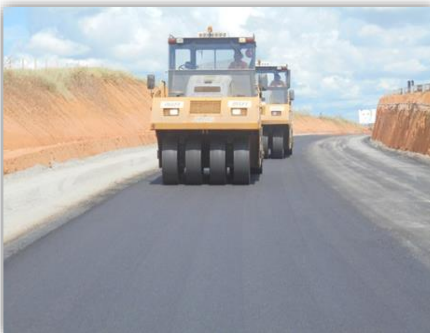
Figura 02 – Compactação de Binder
