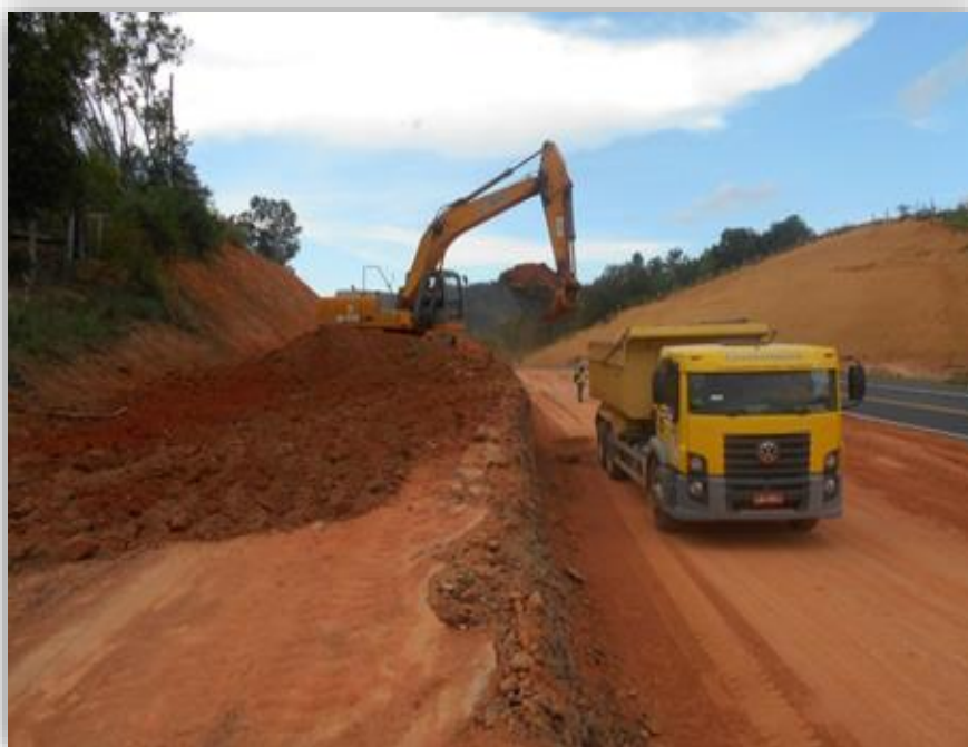
Figura 01 – Corte, terraplenagem e correção de traçado
