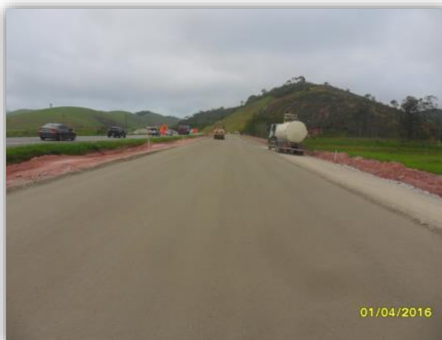
Figura 02 – Liberação da camada de BGS
