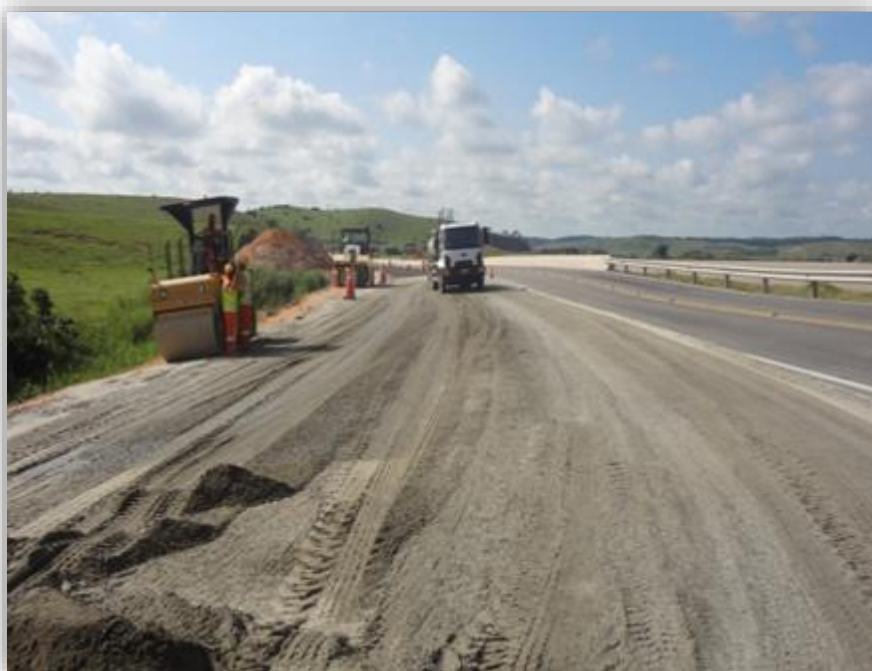
Figura 03 – Execução da base do ramo 100 – km 122,100
