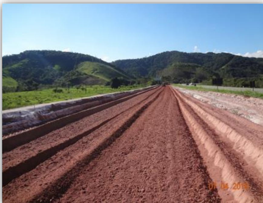
Figura 01 – Tratamento da segunda camada de solo- cal
