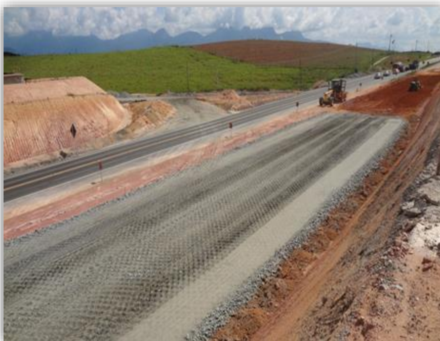
Figura 02 – Execução do sub-base – km 101,100
