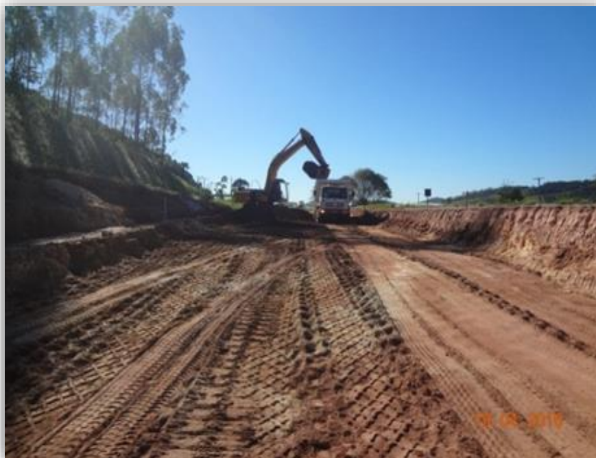
Figura 03 – Rebaixo de subleito
