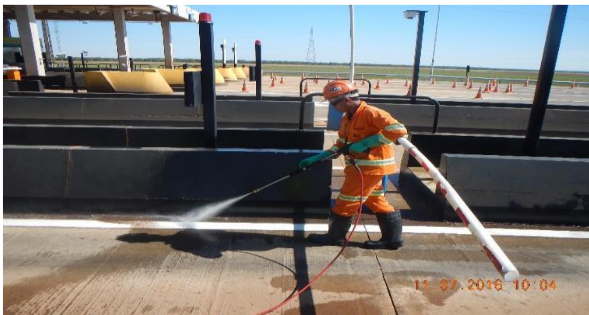
Figura 5 – Limpeza na praça de pedágio 09 - Km 767+200 Norte.
