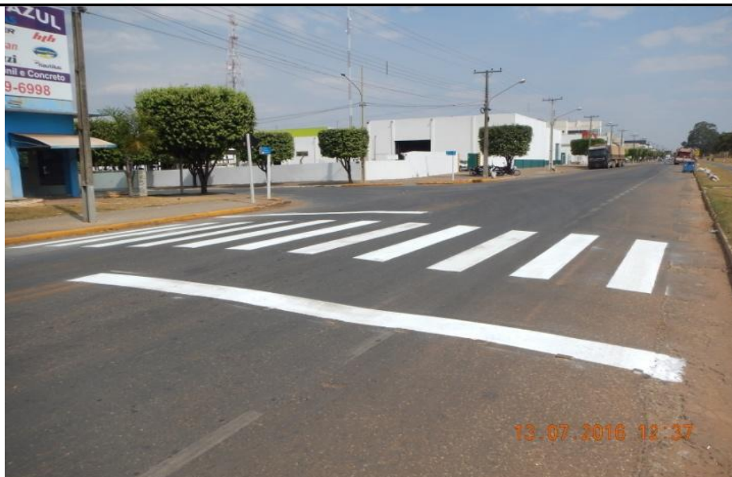
Figura 8 – Revitalização de sinalização horizontal - Faixa de pedestre em nível-Km 690+050 Norte.
