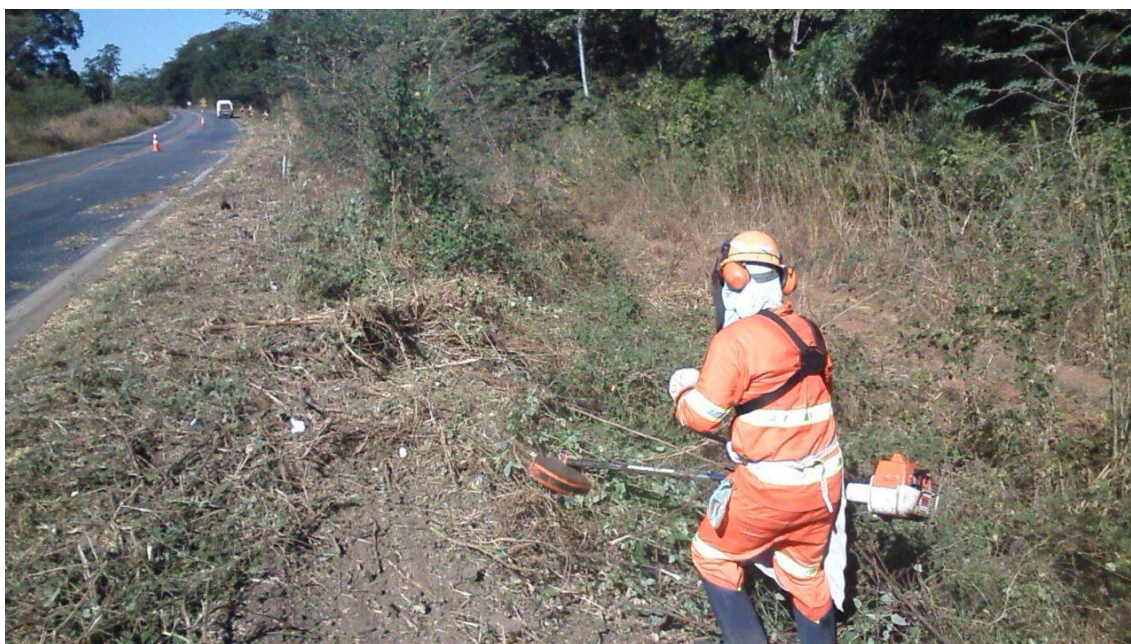
Figura 4 – Roçada manual e mecanizada na faixa de domínio- Km 524+600 Sul
