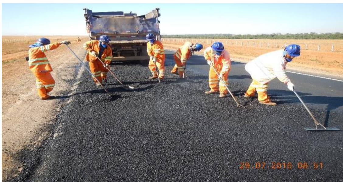
Figura 9 – Recomposição da camada de CBUQ - Km 637+200 Norte.
