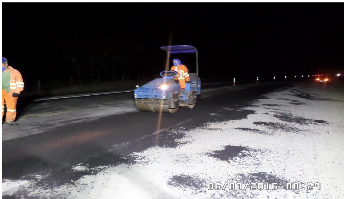
Figura 2 – Compactação de área recuperada com CBUQ – Km 507+300 ao 507+600 Centro
