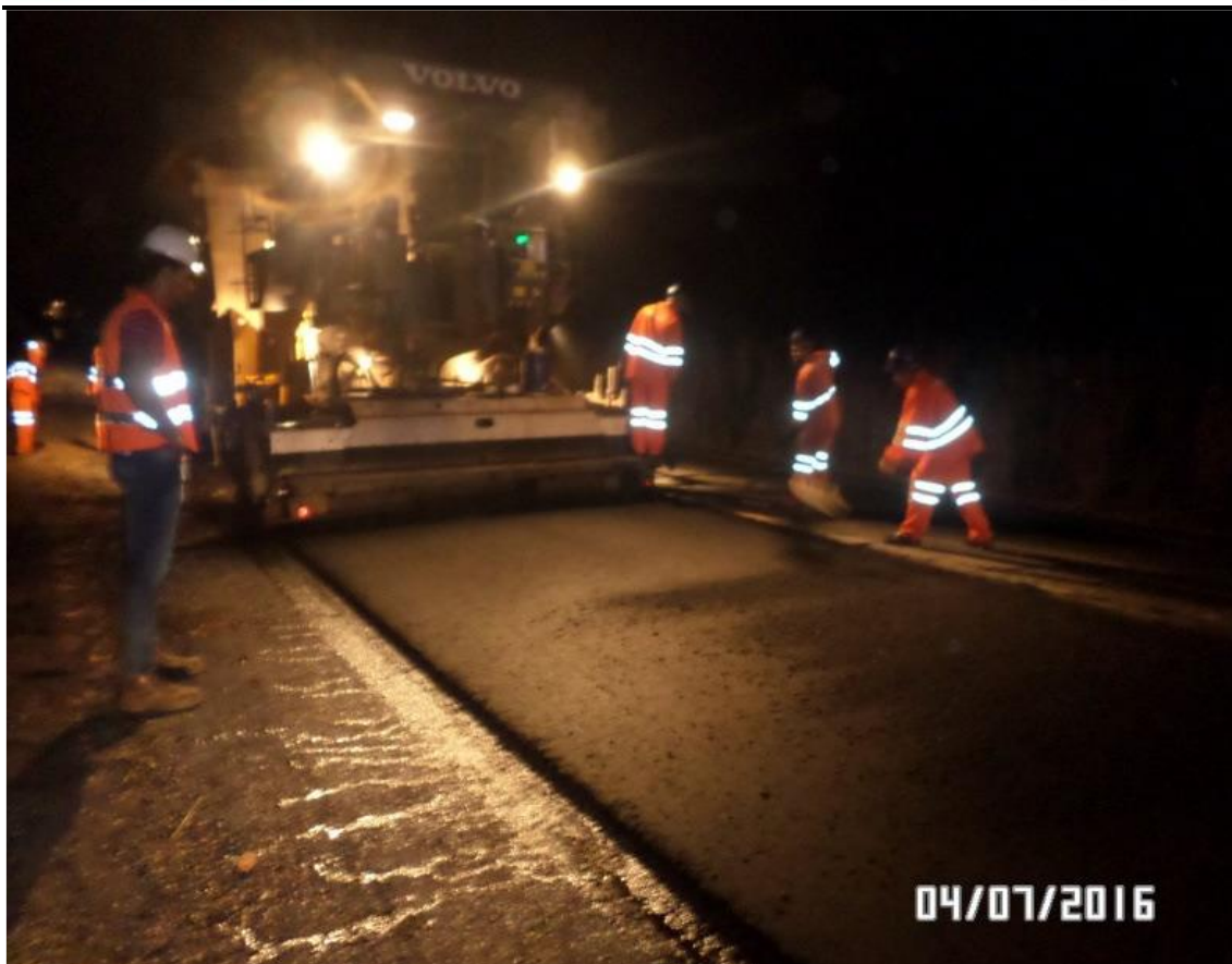
Figura 6 – Aplicação de emulsão (RR-2C) e recomposição de CBUQ na área fresada - Km 444 + 770 Sul.
