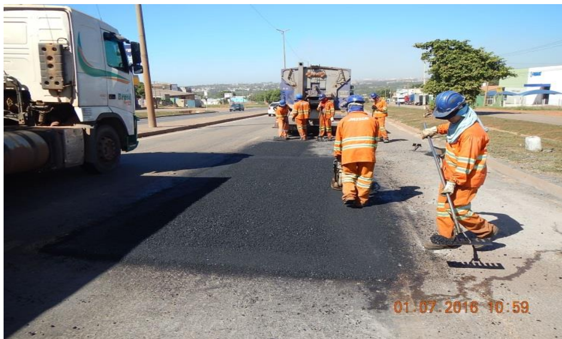
Figura 1 – Compactação de Massa (Reparo Localizado) – Km 123+000 ao km 123+500 Sul
