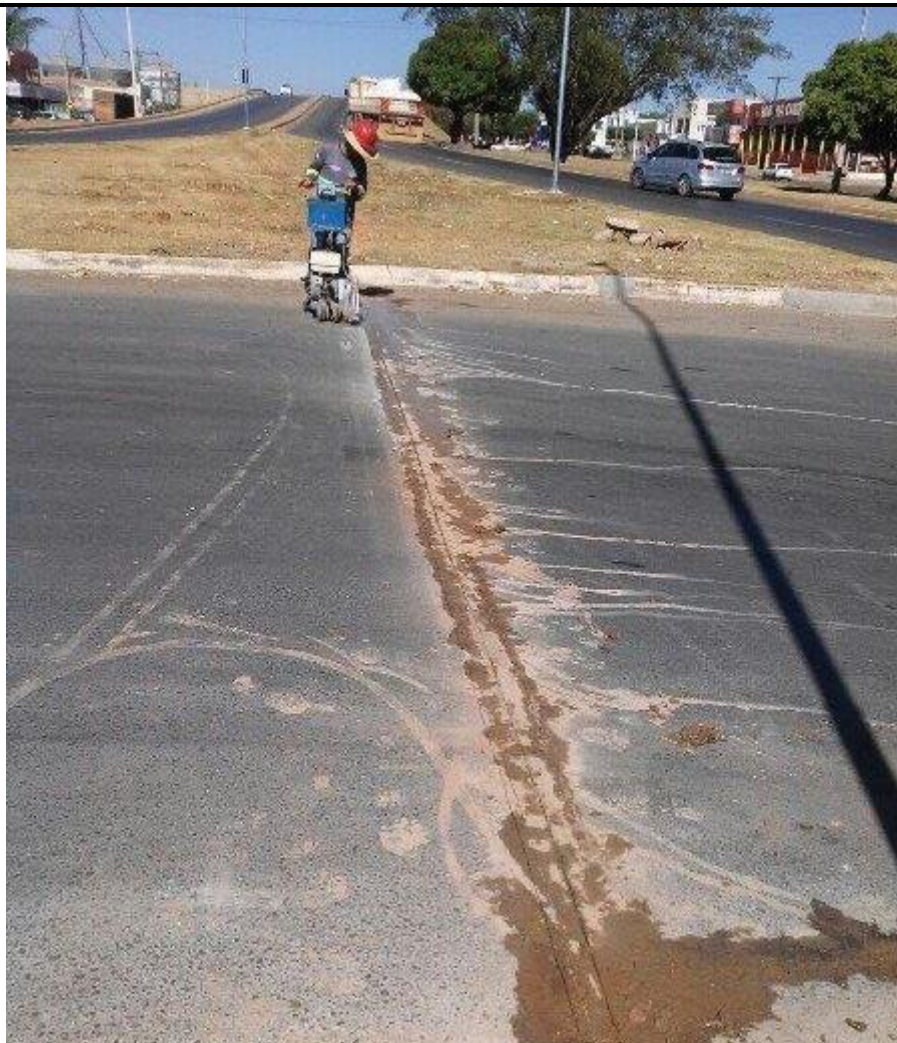
Figura 10 – Instalação de tubulação elétrica no município de Sorriso – Km 753 +000
