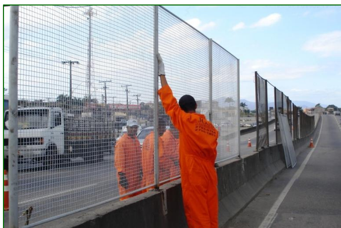
MELHORIA NA RODOVIA – INSTALAÇÃO DE TELAS
