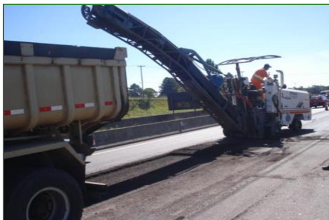
OBRA DE MELHORIA – FRESAGEM ASFÁLTICA
