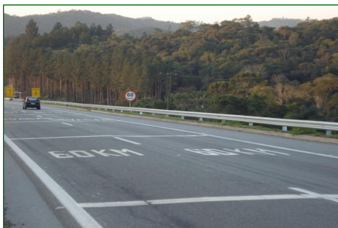
MELHORIA NA RODOVIA – INSTALAÇÃO DE DEFENSA METÁLICA
