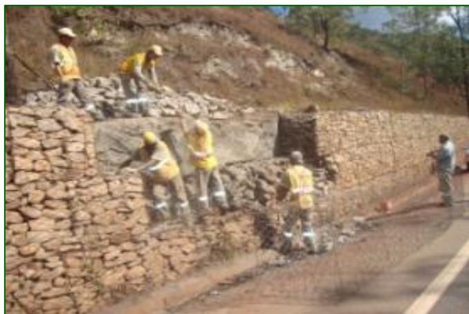
MELHORIA NA RODOVIA – CONTENÇÃO DE TALUDE
