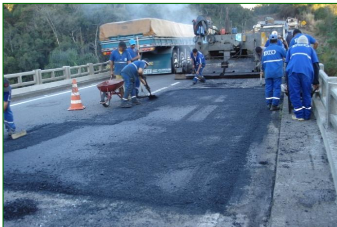
MELHORIA NA RODOVIA – RECUPERAÇÃO DO ASFALTO
