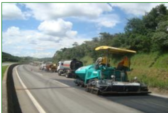
MELHORIA NA RODOVIA – RECAPEAMENTO ASFÁLTICO
