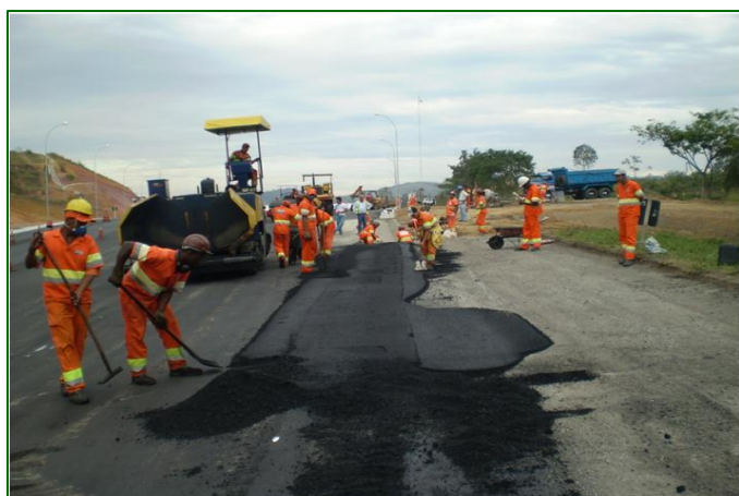
MELHORIA NA RODOVIA – RECUPERAÇÃO DE PAVIMENTO
