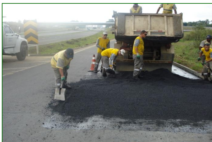
MELHORIA NA RODOVIA – RECUPERAÇÃO DO ASFALTO
