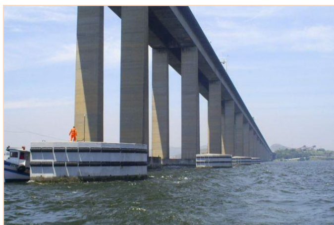
MELHORIA NA PONTE – RECUPERAÇÃO DE DOLFINOS SEMI-CIRCULARES
