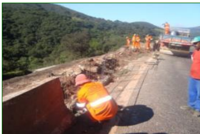
MELHORIA NA RODOVIA – CONSTRUÇÃO DE BARREIRA
