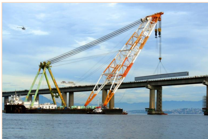
IÇAMENTO DE ESTRUTURA METÁLICA PARA BASE OPERACIONAL
