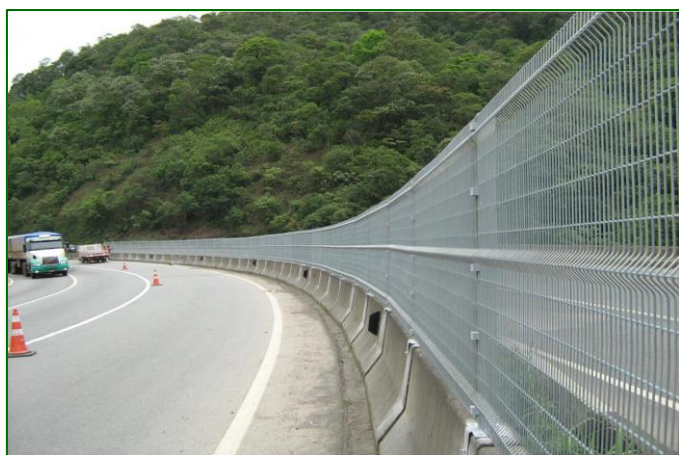
MELHORIA DA RODOVIA – INSTALAÇÃO DE TELA ANTI-OFUSCAMENTO
