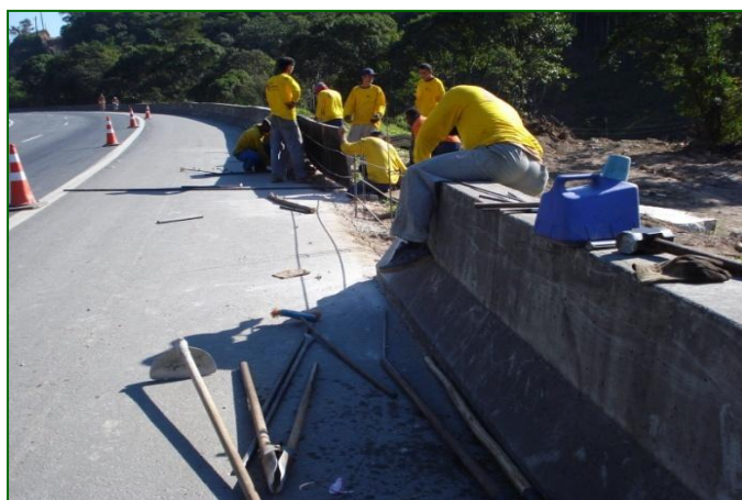
MELHORIA NA RODOVIA – INSTALAÇÃO DE BARREIRA RÍGIDA
