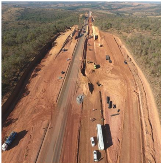
Implantação de Retorno Tipo Ferradura no km 233 - Campo Alegre/GO
