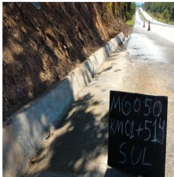
Recuperação de Canaleta KM 01+458 ao 01+514 Sul BR050 MG
