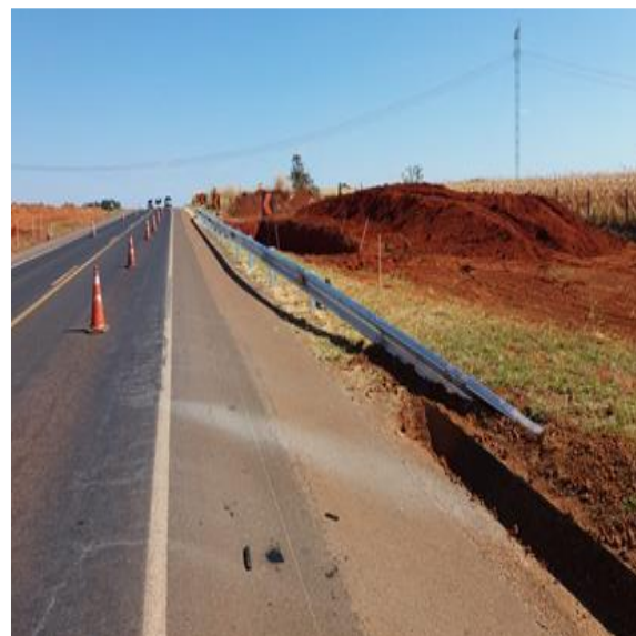
Implantação de Defesa Metálica KM 255+440 Sul GO
