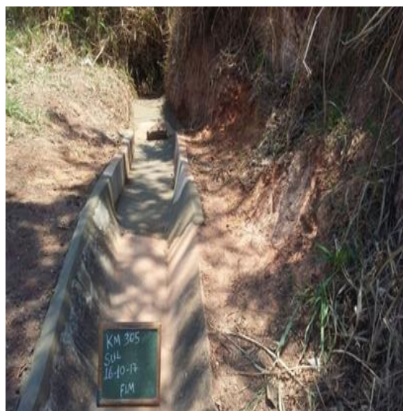
Recuperação de Descida D'água KM 305 Sul GO
