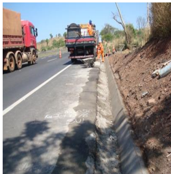
Reconstrução de Canaleta KM 02+046 ao 02+098 Sul MG
