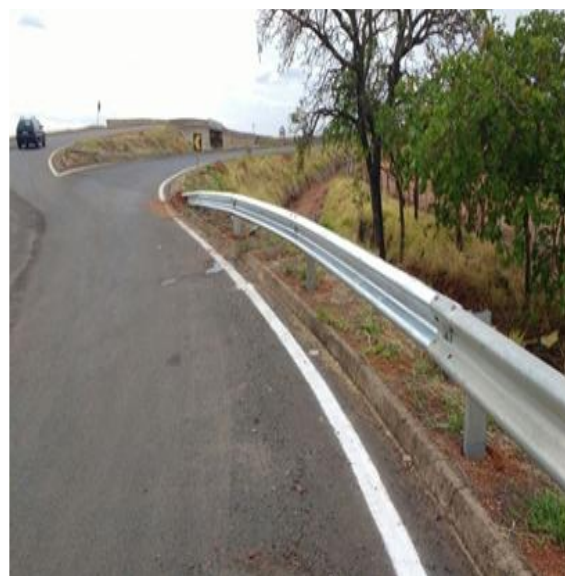
Manutenção de Defesa Metálica KM 22 MG – Alça de Acesso
