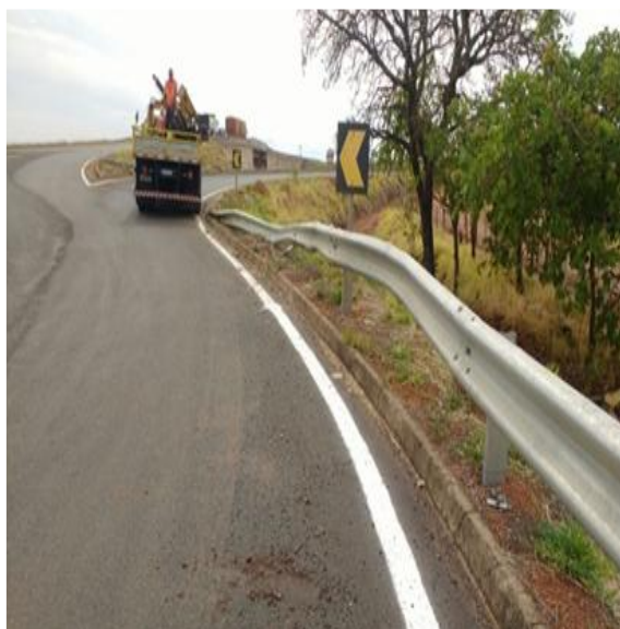
Manutenção de Defesa Metálica KM 22 MG – Alça de Acesso
