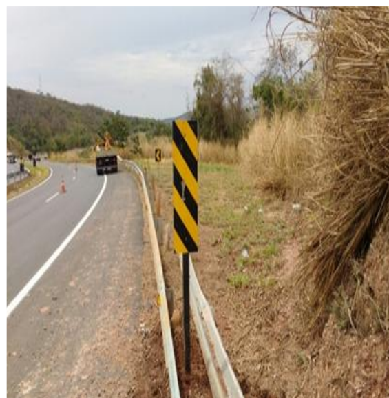
Reposição de Placa KM 17 Norte MG
