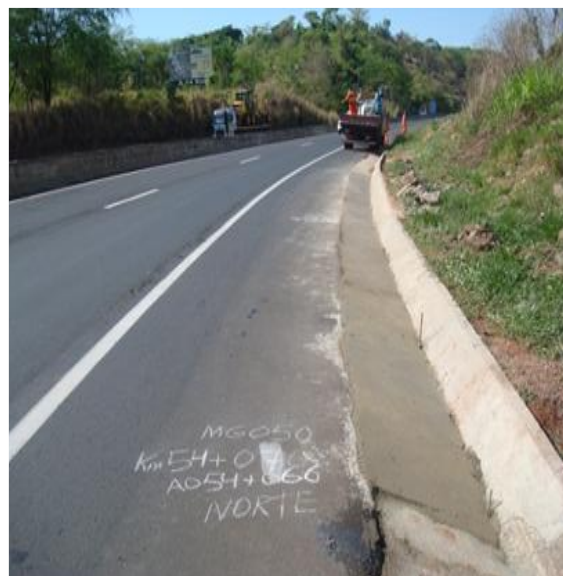
Recuperação de Canaletas KM 54+085 ao 54+052 Norte MG
