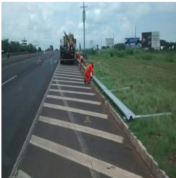
Implantação de Defesa Metálica KM 174+300 Sul - MG
