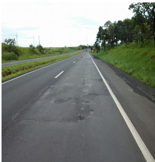
Recuperação Funcional de Pavimento com Fresagem Descontinua –Km 125.500 Faixa 2 Pista Norte - BR 050 – MG
