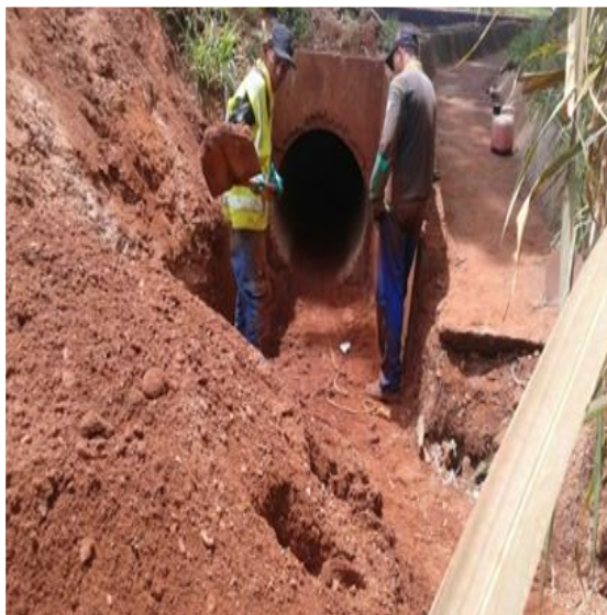
Limpeza de Bueiro KM 51 Norte – MG (TRECHO DNIT)
