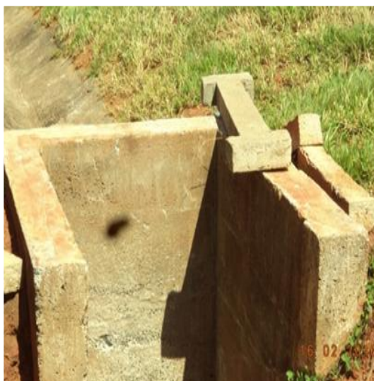
Instalação de Tapa de Bueiro KM 10 Sul Contorno MG
