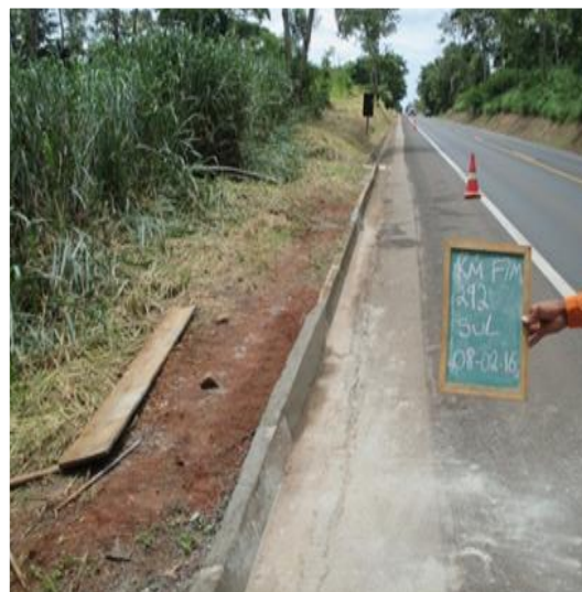
Recuperação de Meio Fio KM 192 Sul – GO
