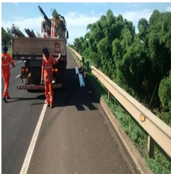
Manutenção de Defesa KM 130+900 Sul – MG
