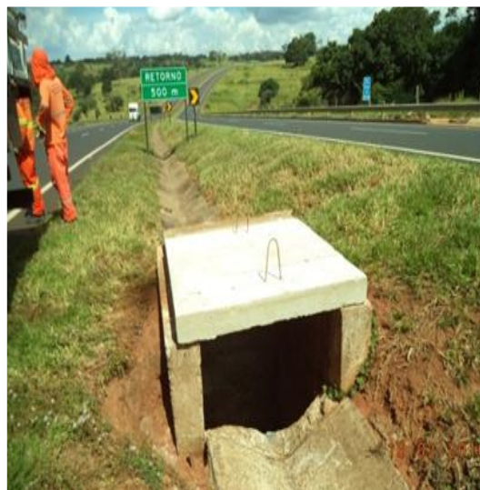
Instalação de Tapa de Bueiro KM 10 Sul Contorno MG
