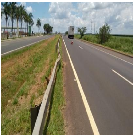
Manutenção de Defesa Metálica KM 118+060 Sul MG
