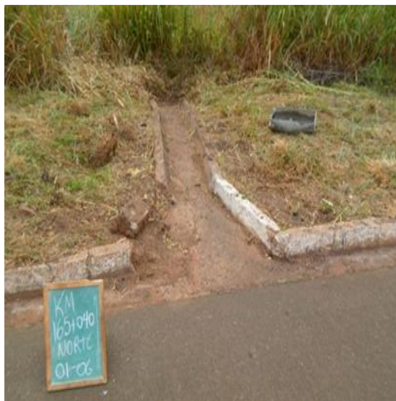
Recuperação de Descida D'água KM 165+040 Norte – MG
