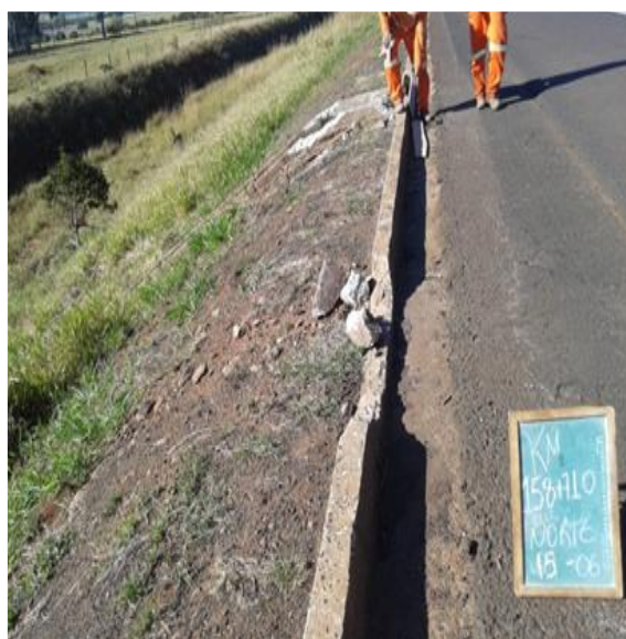
Recuperação de Meio Fio KM 158+170 Norte – MG
