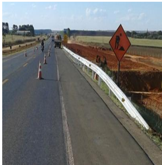
Implantação de Defesa Metálica KM 111+300 Norte – GO
