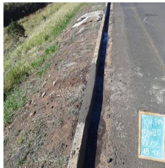
Recuperação de Meio Fio KM 158+170 Norte – MG
