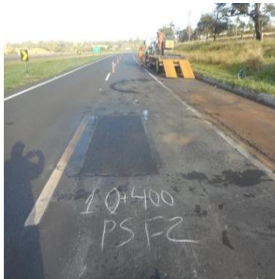
Reparo localizado KM 10+400 Sul – Contorno - MG
