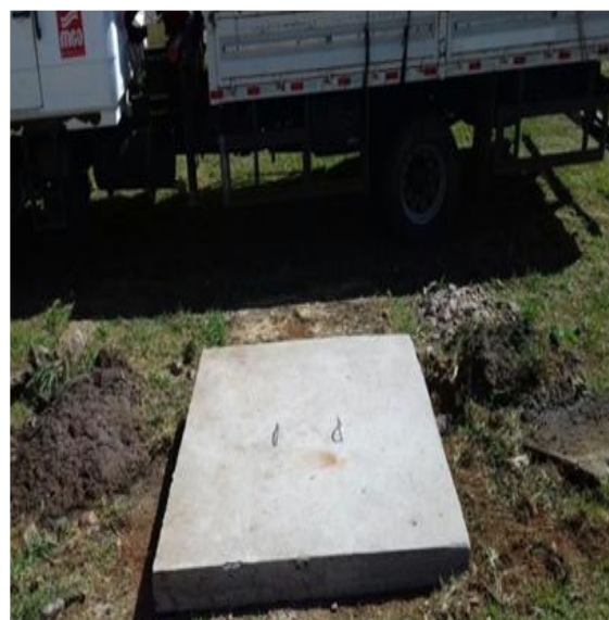
Instalação de Tampa em Bueiro KM 97+400 Norte - GO
