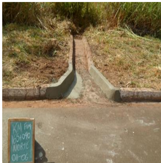
Recuperação de Descida D'água KM 165+040 Norte – MG
