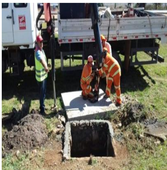
Instalação de Tampa em Bueiro KM 97+400 Norte - GO
