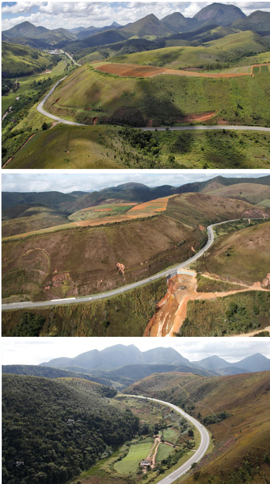
Figura 35 – Seção meia encosta com talude de jusante alto sem escalonamento (pista 1) e morro com área de plantio no topo (fonte de contribuição de água subterrânea): (a) divisor das bacias (ponto alto do greide); (b) bacia do rio do Capim ou Pião; e (c) bacia de afluente do córrego Quebra-Coco.
