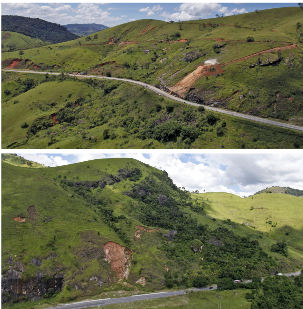
Figura 28 - Rupturas rotacionais por perda de coesão em derrames coluvionares homogêneos compostos por solo argilo siltooso marrom avermelhado e poroso (km 28+015 e km 28+195). Nota-se formação de voçorocas no talude de jusante avançando em direção à plataforma rodoviária. Evolução de processos erosivos que atingem a profundidade do lençol freático formando voçorocas nos taludes de jusante que avançam em direção à plataforma rodoviária. Diversos mecanismos de ruptura deflagrados em uma mesma encosta (km 30+305).
