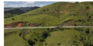
Figura 58 – Ruptura rotacional por perda de coesão em depósitos colúvionares homogêneos compostos por solo argilo silteoso macio, arenoso e bastante homogêneo (km 27+930 ao km 28+500). Nota-se formação de voçorocas nos taludes de jusante orientadas em direção à planície rodoviária.
