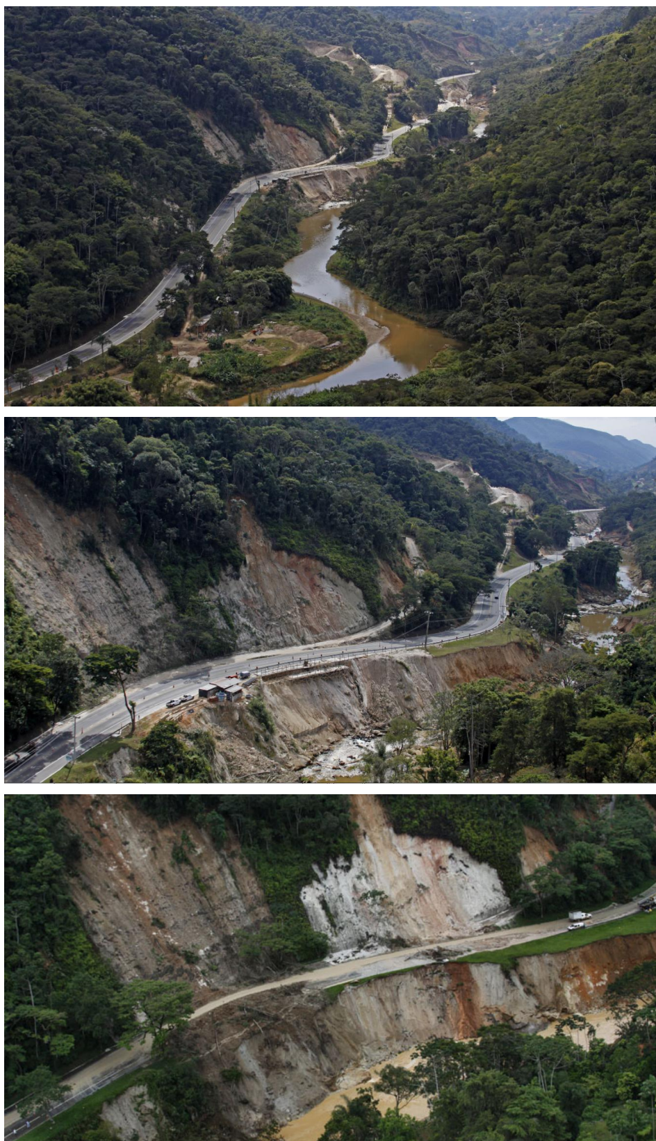
Figura 41 – Diversas rupturas nos taludes de montante e jusante no segmento Andradas (chuvas de 2011).
