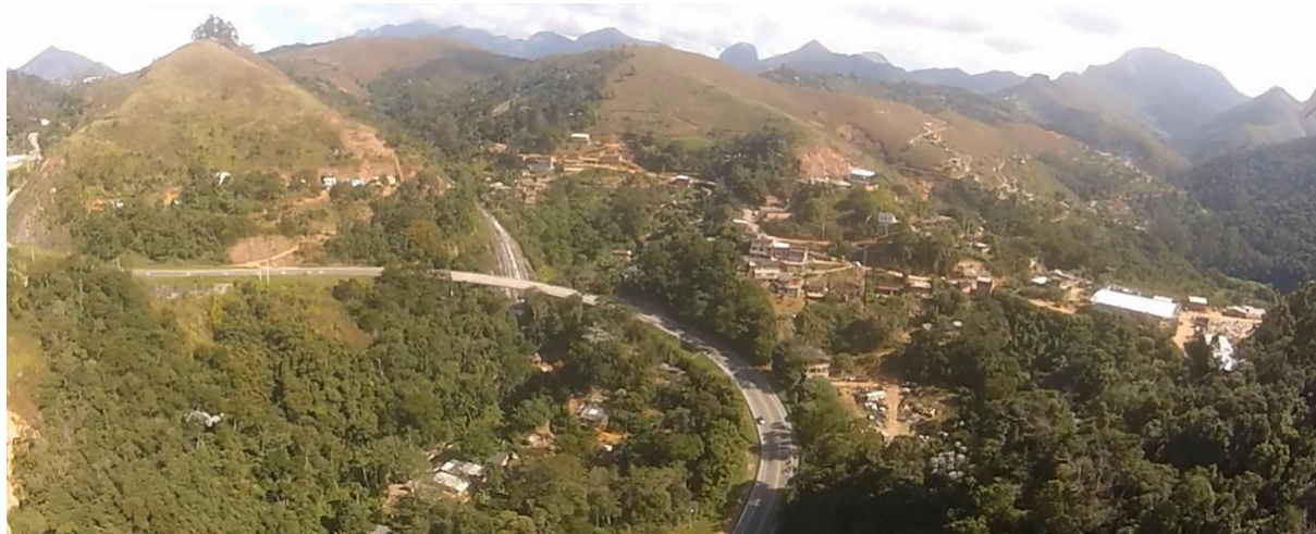
Figura 47 – Topografia do segmento geológico-geotécnico Fischer 01. Trecho em que o rio Fischer passa à esquerda da rodovia. O vale é mais profundo com declividade acentuada. Os taludes de jusante da pista 2 são altos e sua base é afetada pela força da água do rio Fischer.
