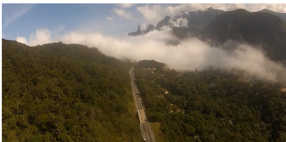
Figura 52 – Morfologia do relevo do segmento geológico-geotécnico Comari. Verifica-se a montante do morro Comari vale aplainado com potencial de infiltração de água na direção da rodovia ente os quilômetros km 87 e km 88. Segmento caracterizado por seção meia encosta com talude de jusante para o lado direito (pista 1). Os taludes de montante pertencem à contra encosta dos contrafortes da Serra do Mar ou dos Órgãos. Os taludes são muito influenciados pela presença de água subterrânea.
