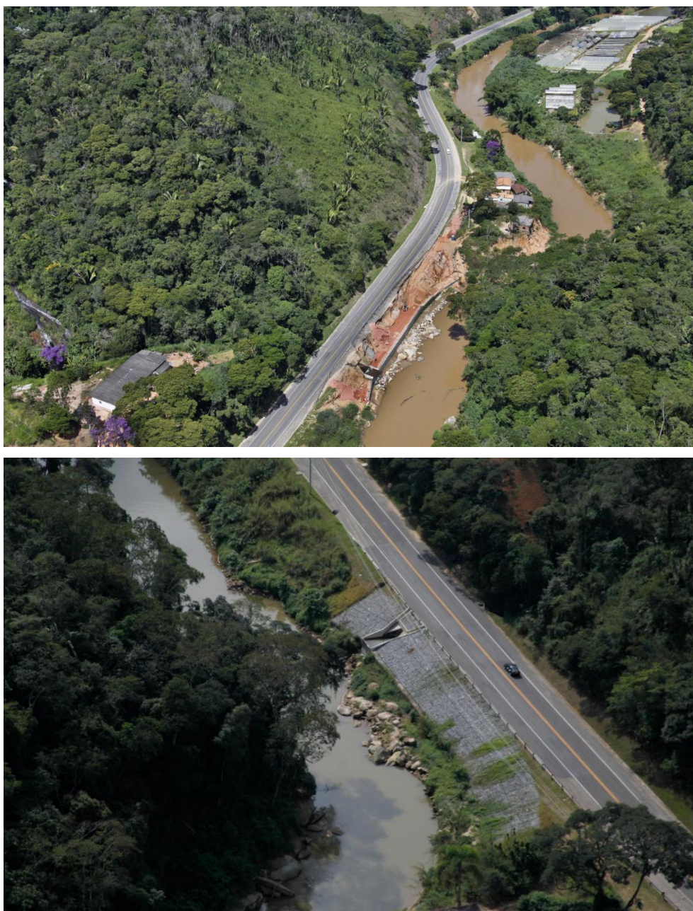
Figura 116 – Taludes de jusante situados na margem da curvatura externa do rio são mais afetados pela erosão fluvial. No segmento uma solução adotada com sucesso refere-se à execução de gabião e enrocamento na base do talude com reaterro reforçado com faceamento em colchão reno. Com o tempo a vegetação se estabelece e oculta o sistema de contenção.
