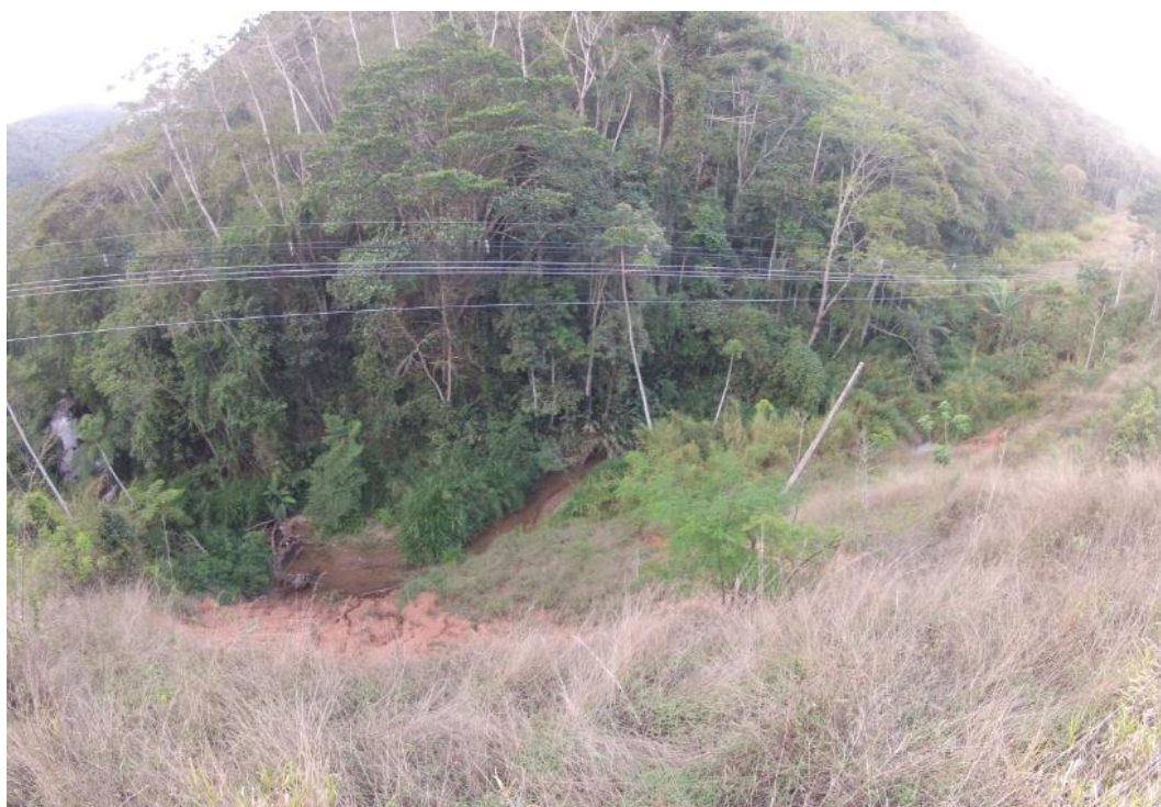
Figura 106 – Ruptura em talude de jusante resultante de erosão fluvial resultante da força da água atuante na curvatura externa do córrego da Correnteza (km 53+605, pista 1).
