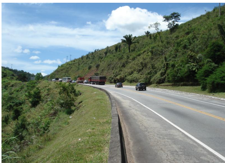
Figura 102 – Observam-se sinais de movimentação (paliçadas no pé do talude de montante, trincas e abatimento no pavimento) na seção meia encosta da bacia do afluente do córrego Quebra-Coco. Verificam-se também pontos de surgência d'água e bombeamento de água subterrânea no pavimento.
