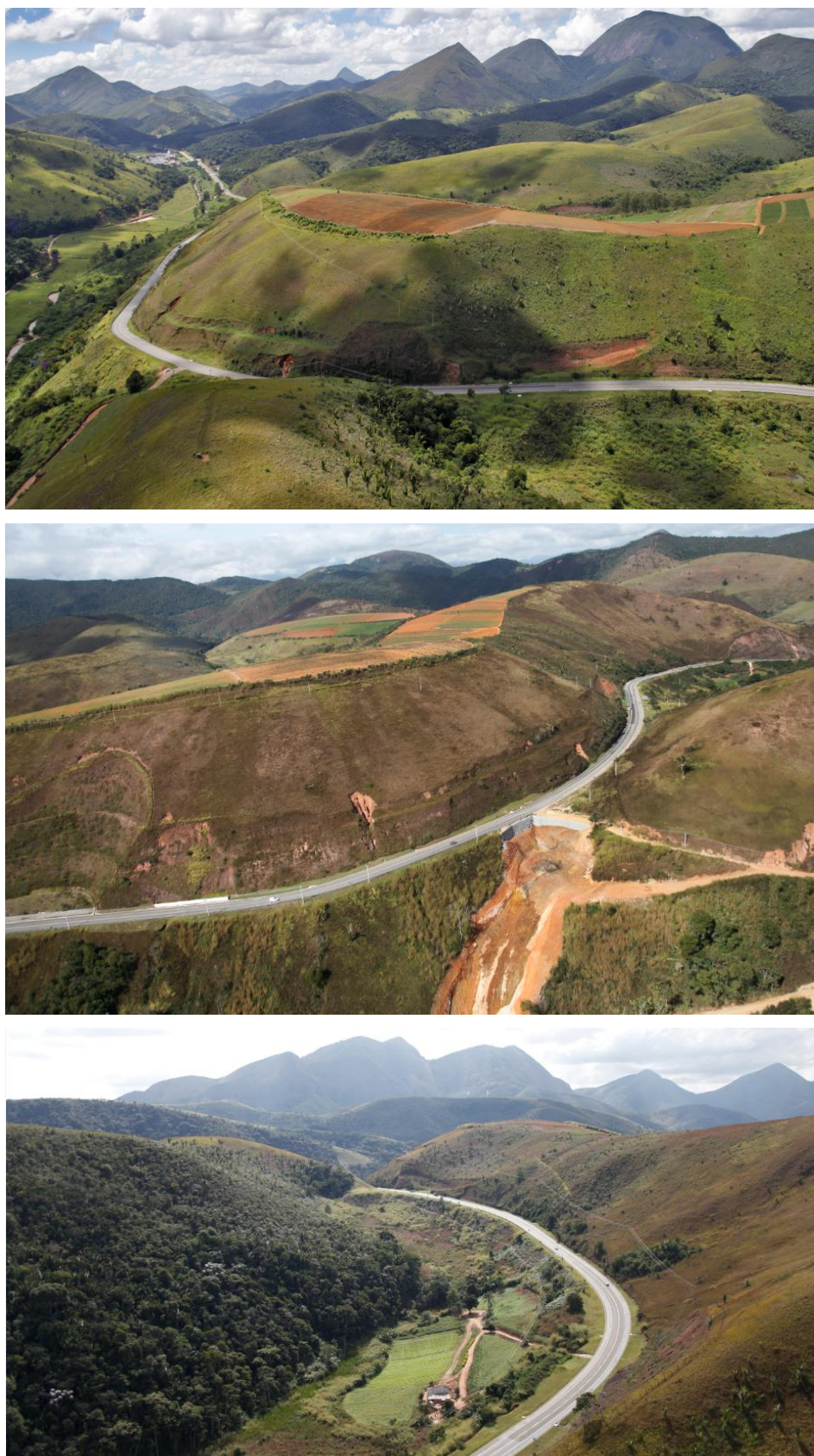
Figura 92 – Seção meia encosta com talude de jusante alto sem escalonamento (pista 1) e morro com área de plantio no topo (fonte de contribuição de água subterrânea): (a) divisor das bacias (ponto alto do greide); (b) bacia do rio do Capim ou Pião; e (c) bacia de afluente do córrego Quebra-Coco.
