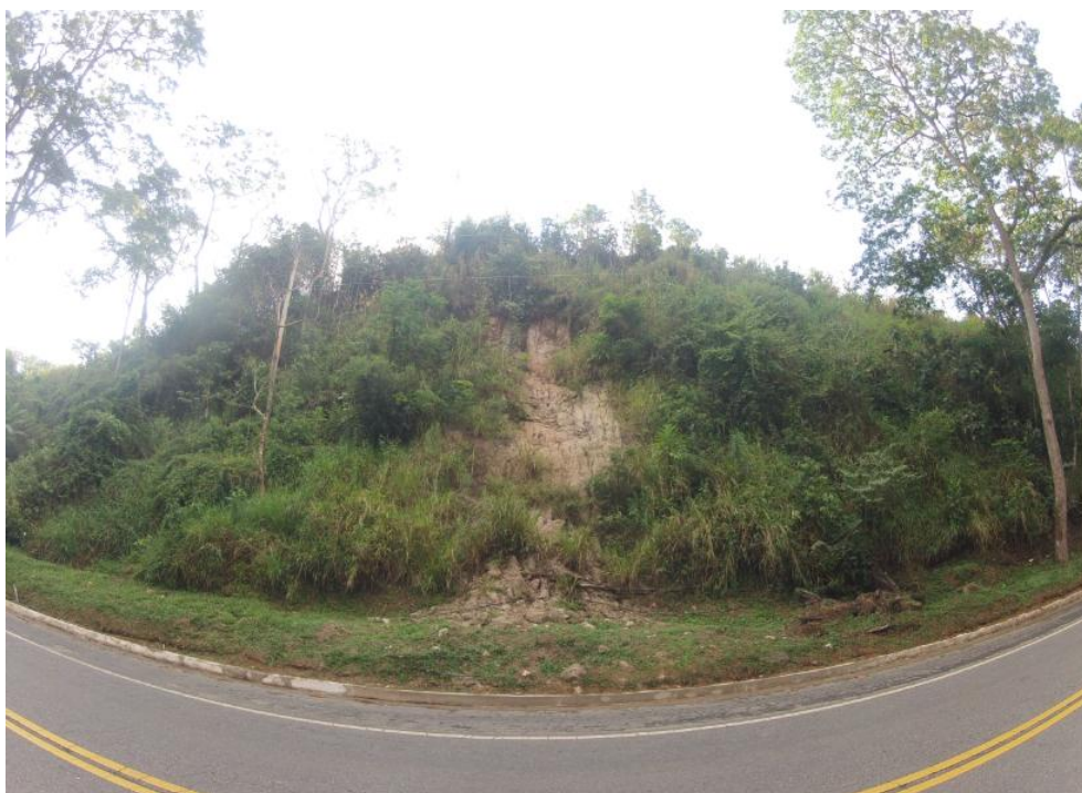
Figura 125 – Escorregamento do tipo translacional em alteração e saprólito (km 60+446, pista 1).
