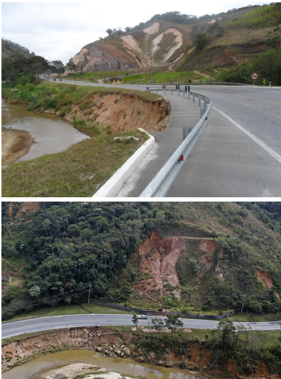
Figura 129 – Curvatura externa do rio Paquequer mobilizando ruptura remontante no talude de jusante iniciada pelo solapamento ocasionado por erosão fluvial (foto 1 - Thalweg, 2011; foto 2 - CRT).
