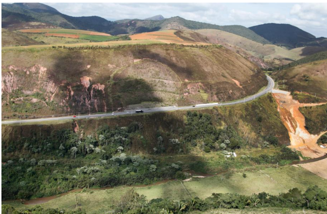
Figura 94 – No trecho de seção meia encosta verificam-se diversas tipologias de ruptura e processos erosivos nos taludes de montante e jusante.
