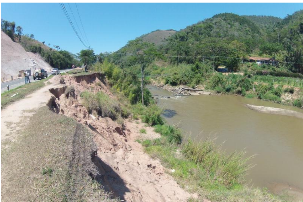
Figura 114 – Rupturas nos taludes de jusante resultante da associação do efeito do rebaixamento rápido com erosões fluviais do rio Preto.
