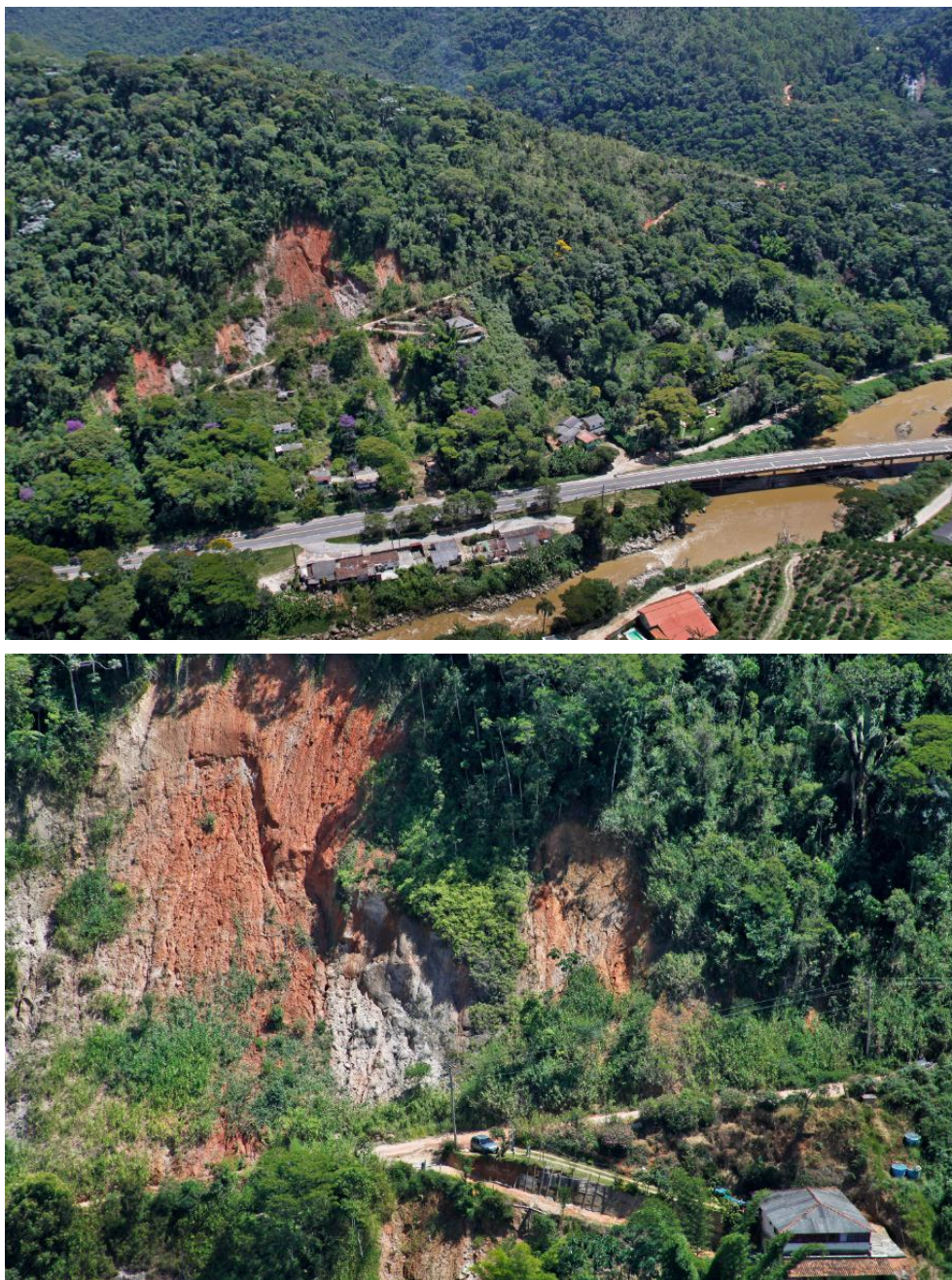
Figura 122 – Escorregamento translacional resultante de escavação na base do talude associada à presença de matérias com diferente propriedades mecânica e hidráulicas submetidos a pressões de água na interface do material mais permeável com menos permeável (km 57+080, pista 1, fora da faixa de domínio).
