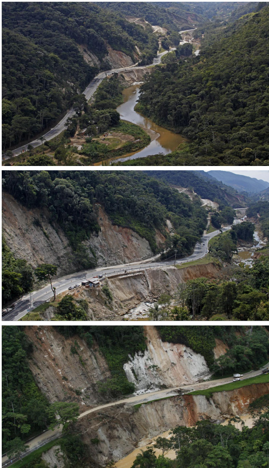
Figura 130 – Diversas rupturas nos taludes de montante e jusante no segmento Andradás (chuvas de 2011).
