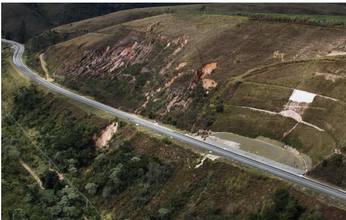
Figura 96 – Vista lateral dos taludes de montante e jusante com destaque para os processos erosivos e rupturas mobilizadas (bacia do rio do Capim o Pião).
