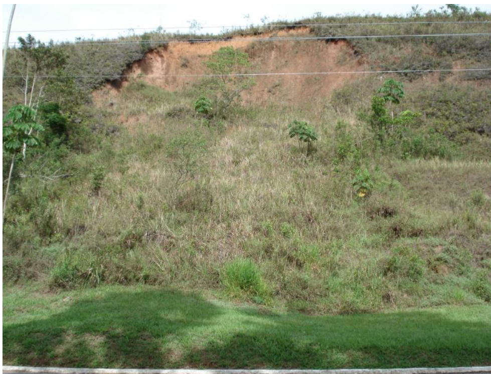
Figura 124 – Cicatriz de ruptura rotacional pouco profunda em talude de corte em solo (km 60+240, pista 1).
