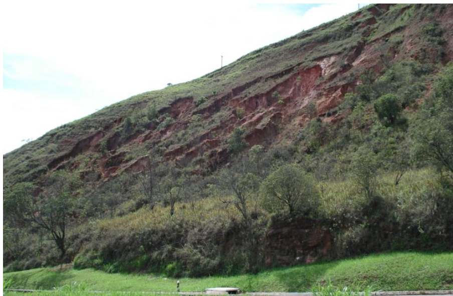
Figura 101 – Erosões e ravinamentos em talude de montante com base composta por alteração e rocha alterada fraturada com surgência d'água (km 49+310).
