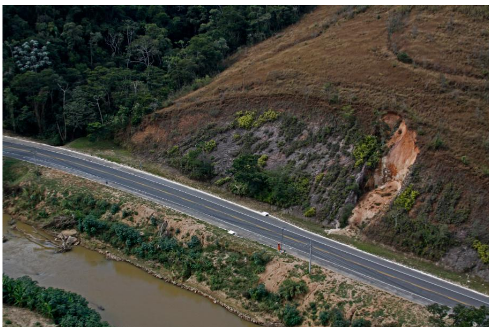
Figura 113 – Por vezes, dependendo do perfil geológico pode ocorrer deslizamento múltiplo retrogressivo translacional rotacional. Esta tipologia de talude no segmento forma uma superfície de ruptura mais profunda.
