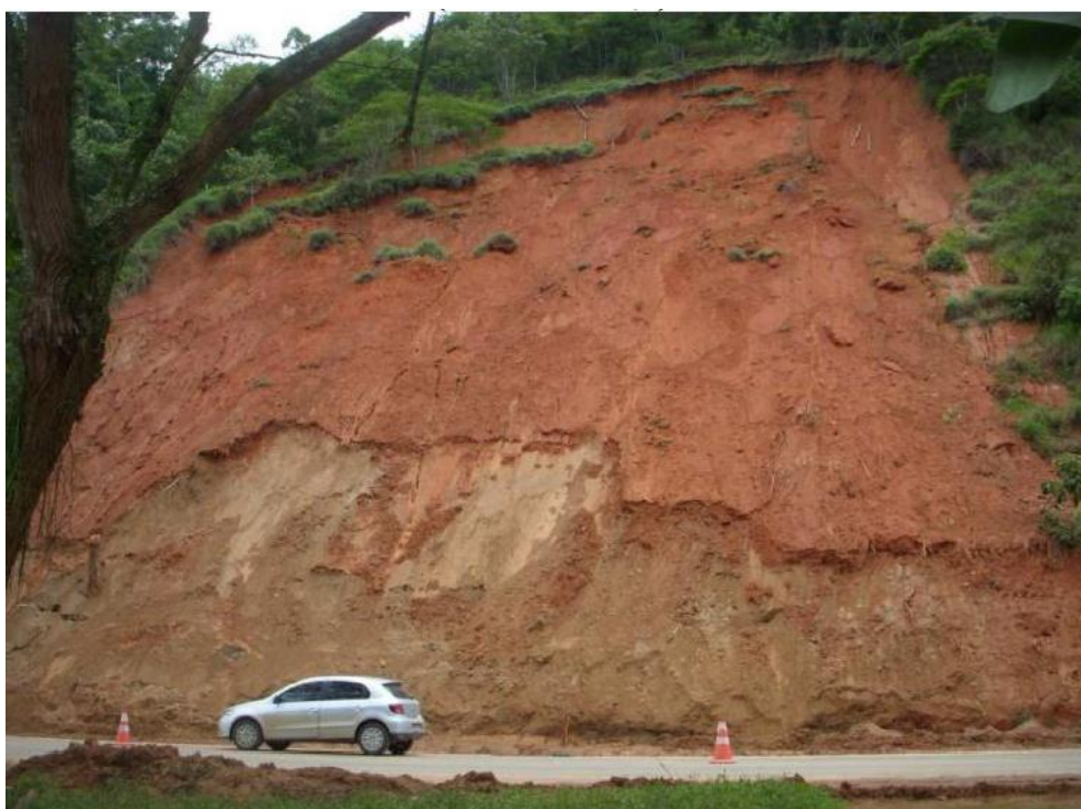
Figura 111 – Escorregamento translacional resultante das pressões de água associadas ao perfil geotécnico e à descontinuidade hidráulica-mecânica dos materiais (capa de argila sobre solo residual jovem).
