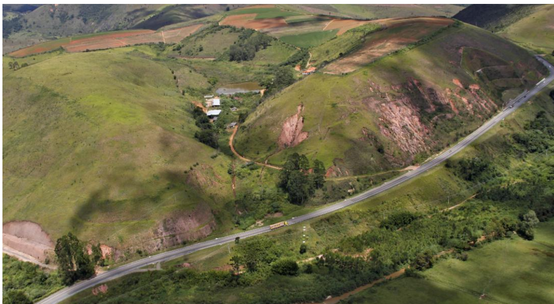
Figura 93 – Talude de corte composto por silte argiloso susceptível a erosões com afloramento de material em alteração na base. Plantio agrícola no topo de morro e armazenamento de água na contra encosta contribuem com a infiltração de água nos taludes de montante e jusante da rodovia.
