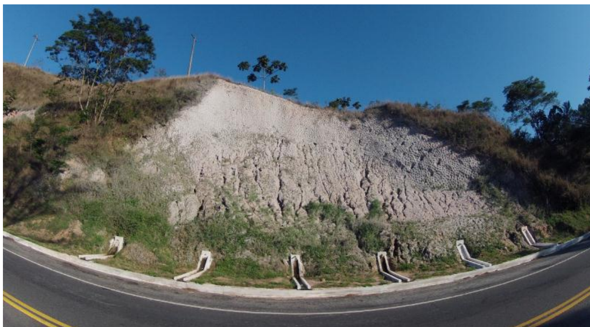
Figura 105 – Colapso em talude de corte resultante da combinação entre descontinuidade hidráulica-mecânica e pressões de água. Os drenos instalados drenam a água subterrânea, entretanto, a superfície exposta (solo residual jovem) apresenta dificuldade para a vegetação se estabelecer, sofrendo, portanto, ravinamentos contínuos (km 51+800, pista 2).
