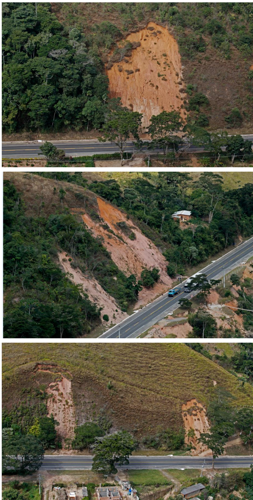
Figura 112 – Rupturas translacionais são pouco profundas, mas devido a altura do talude mobiliza volume significativo de solo.
