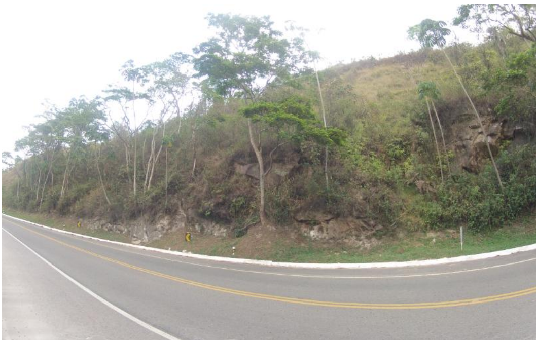
Figura 121 – Escorregamento múltiplo retrogressivo translacional rotacional em manto de alteração sob afloramento de rocha fraturada na base do talude (km 57+460, pista 1).
