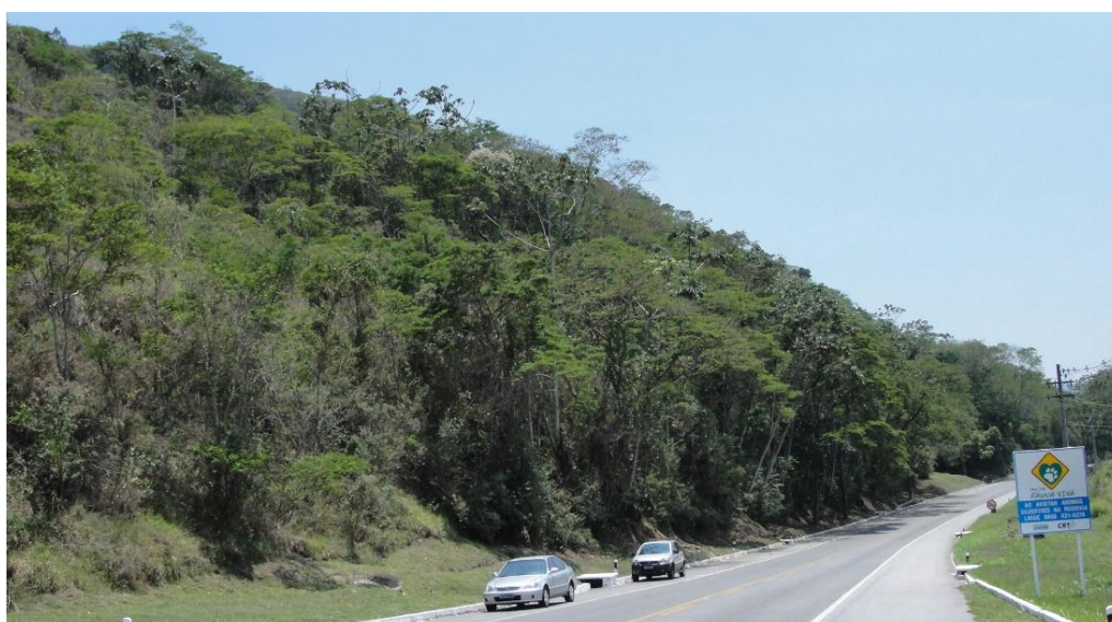
Figura 119 – Movimentação lenta de rastejo nas línguas de tálus-colúvio (km 57+355 e km 58+480, pista 1).
