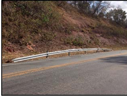
Data: 25/10/2015, km 184,3 Implantação de defesa metálica
