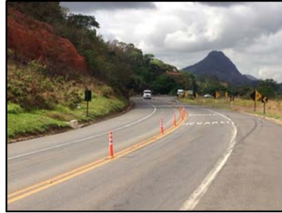
Data: 26/10/2015, km 202 Implantação e manutenção dos balizadores refletivos
