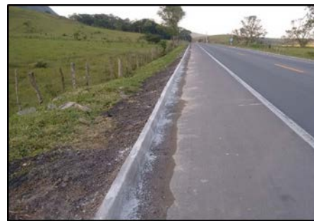
Data: 01/10/2015, km 331 Reconstrução de meio-fio
