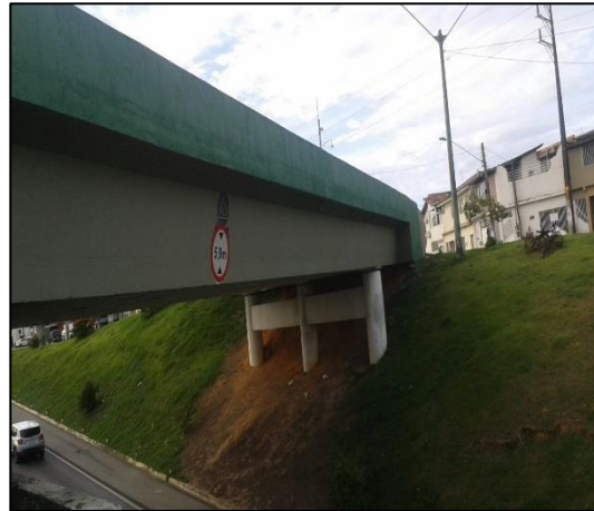
Recuperação, lavagem e pintura da estrutura de concreto do viaduto - km 067 +770.
