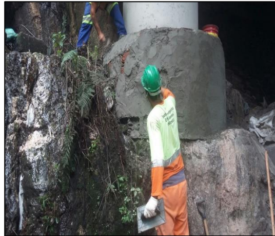
Recuperação, lavagem e pintura da estrutura de concreto do viaduto - km 270 +120.
