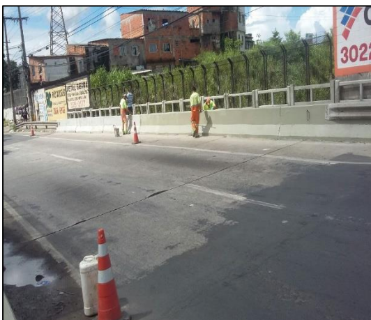
Recuperação, lavagem e pintura da estrutura de concreto do viaduto - km 270 +120 S.
