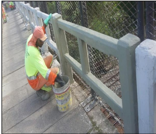
Recuperação, lavagem e pintura da estrutura de concreto do viaduto - km 270 +120 N.
