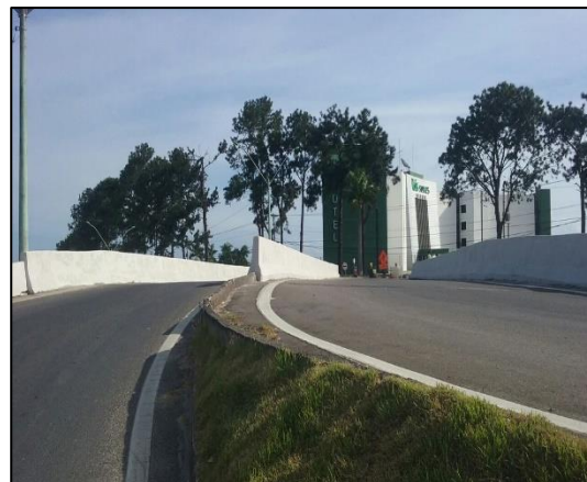
Recuperação, lavagem e pintura da estrutura de concreto do viaduto - km 067 +770.
