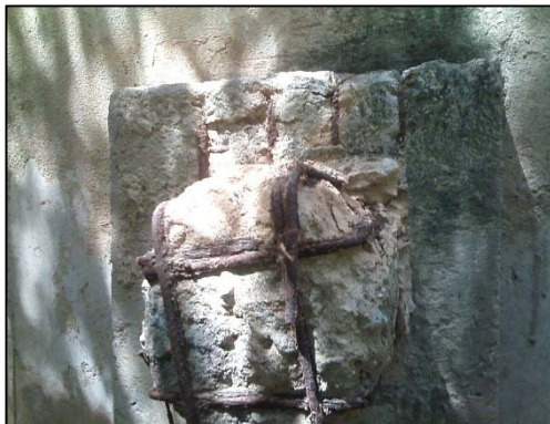
Limpeza de superfície do concreto e aço danificado
