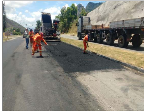
km 265 - Reparos localizados com aplicação de CBUQ
