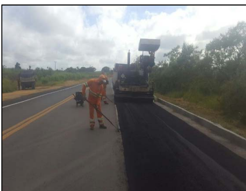
km 184 ao 197 - Preenchimento de Acostamento
