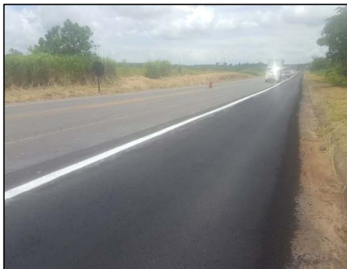
km 180 ao 197 - Preenchimento de Acostamento
