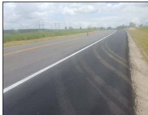
km 180 ao 197 - Preenchimento de Acostamento
