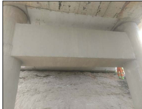
Tratamento da superfície com pintura acrílica
