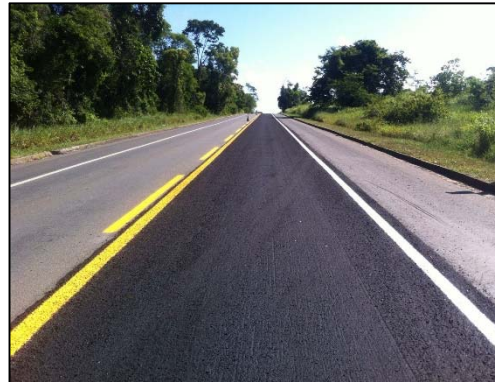
km 118 ao 125 - Microrevestimento
