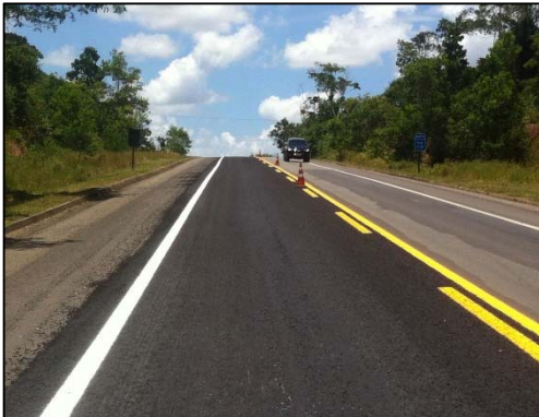
km 118 ao 125 - Microrevestimento
