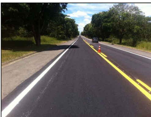
km 333 ao 334,8 - Microrevestimento
