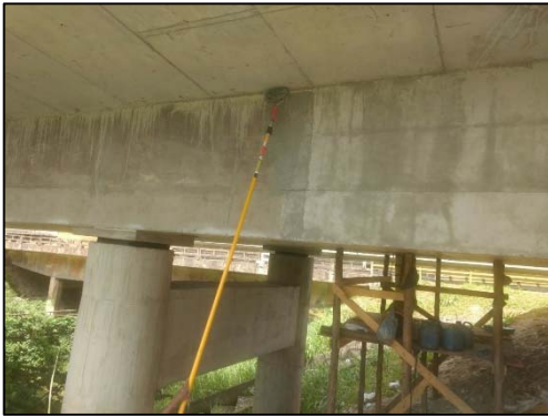
Tratamento da superfície de concreto da viga longitudinal com pintura acrílica
