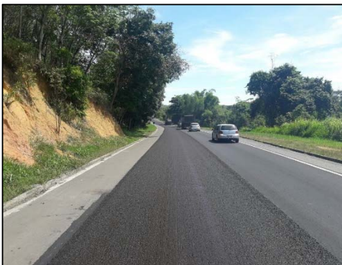
km 312 ao 313 - Microrevestimento
