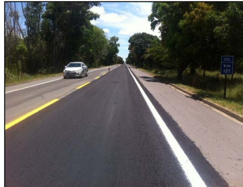
km 333 ao 334,8 - Microrevestimento
