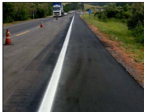
km 325 - Preenchimento de Acostamento
