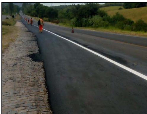
km 325 - Preenchimento de Acostamento
