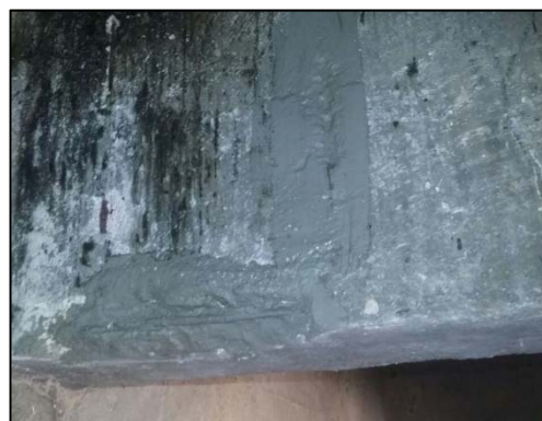
Recomposição da seção com argamassa polimérica
