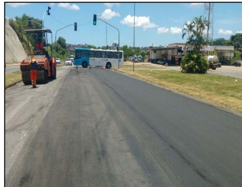
km 265 - Reparos localizados com aplicação de CBUQ
