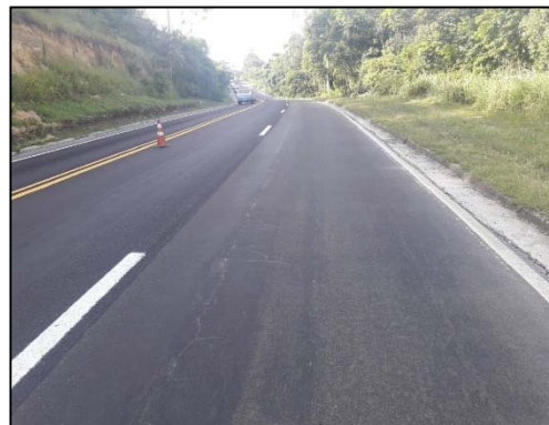
km 312 ao 313 - Microrevestimento
