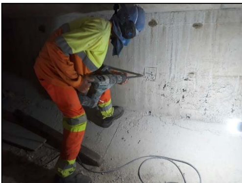
Apicoamento para eliminar a superfície lisa
