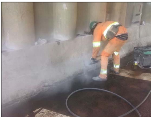
Jateamento com água para tratamento de fissuras
