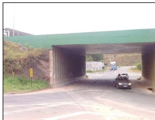
Tratamento da superfície com pintura acrílica
