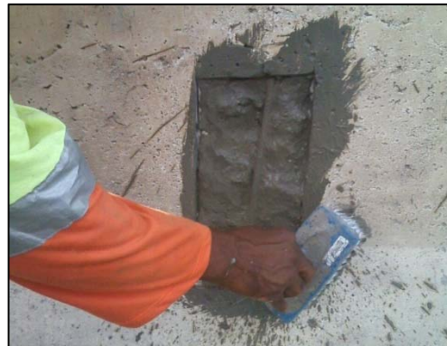
Recomposição da seção com argamassa polimérica
