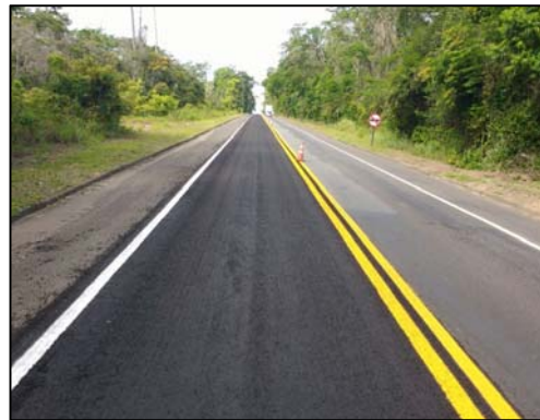
km 104 ao 106 - Microrevestimento
