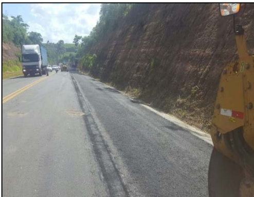
km 184 ao 197 - Preenchimento de Acostamento
