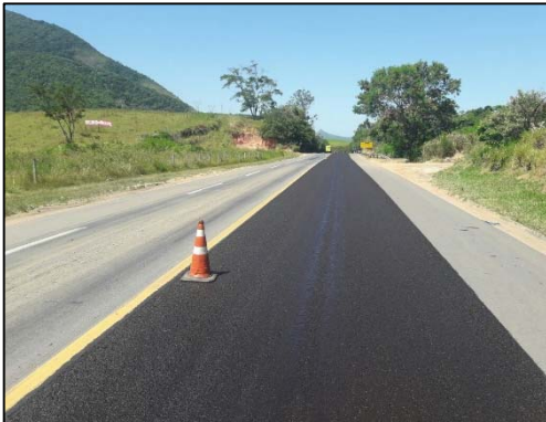
km 333 ao 334,8 - Microrevestimento
