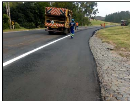
km 325 - Preenchimento de Acostamento
