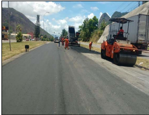
km 265 - Reparos localizados com aplicação de CBUQ
