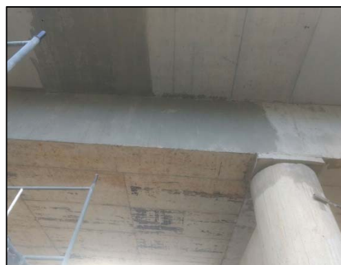
Tratamento da superfície com pintura acrílica
