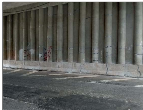
Aplicação de argamassa para tratamento das fissuras
