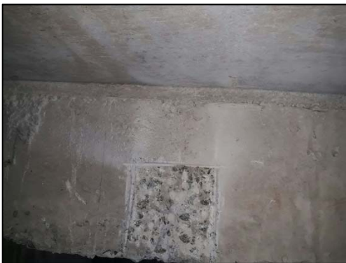
Preparo da superfície para tratamento do concreto disgregado
