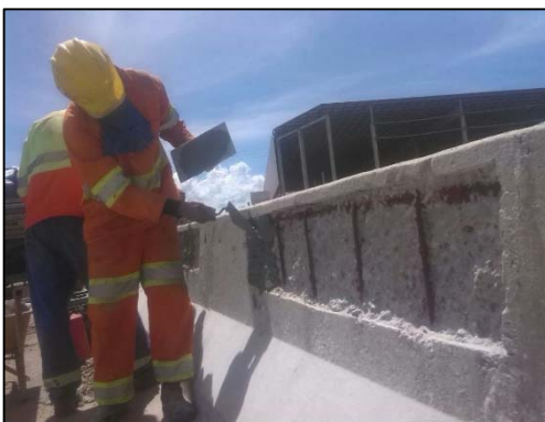
Recomposição da seção com argamassa polimérica
