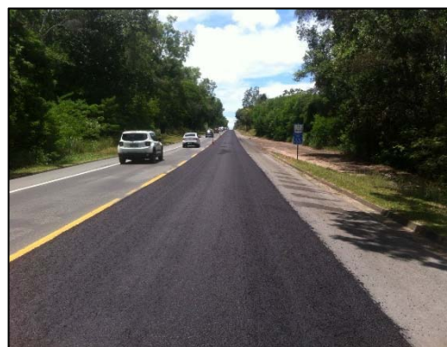
km 333 ao 334,8 - Microrevestimento
