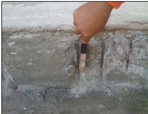
Apicoamento manual para recuperar superfície danificada
