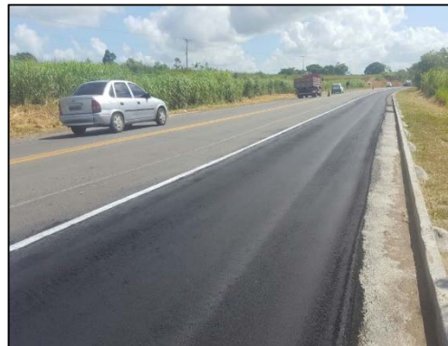
km 184 ao 197 - Preenchimento de Acostamento
