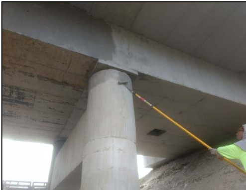
Tratamento da superfície com pintura acrílica
