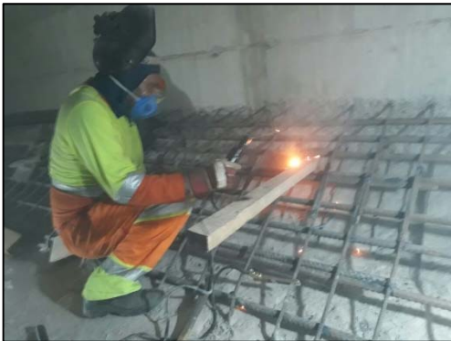
Montagem da armadura
