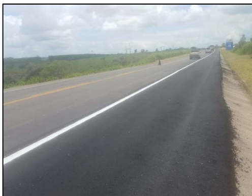
km 180 ao 197 - Preenchimento de Acostamento
