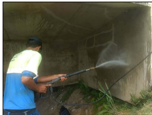
Jateamento com água para tratamento de fissuras
