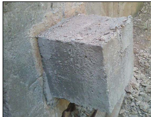
Recomposição da seção com argamassa polimérica
