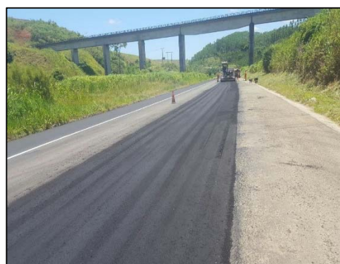
km 145 ao 150 - Reparos localizados com aplicação de CBUQ
