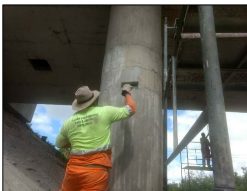
Tratamento da superfície com pintura acrílica
