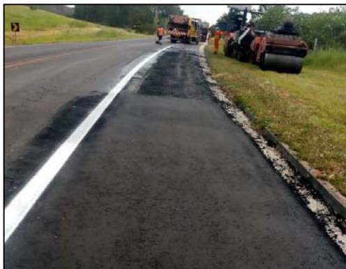
km 325 - Preenchimento de Acostamento
