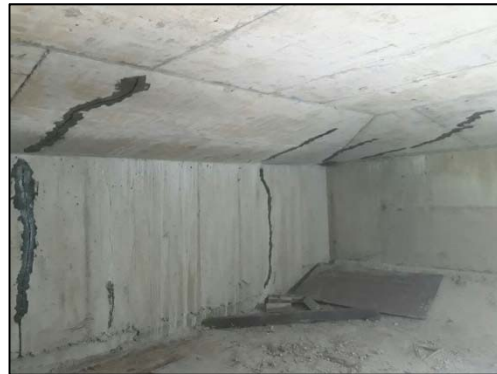
Aplicação de argamassa para tratamento das fissuras
