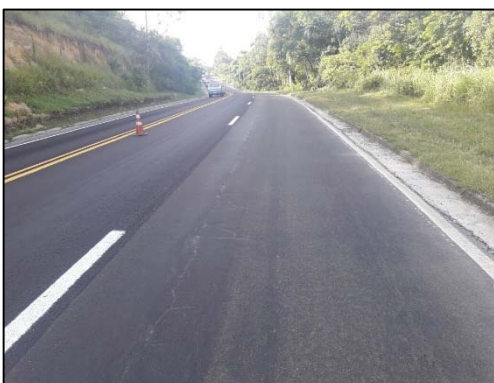
km 312 ao 313 - Microrevestimento
