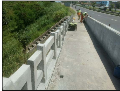
Tratamento da superfície de concreto de guarda corpo e barreira rígida com pintura acrílica
