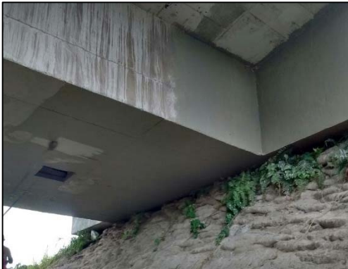
Tratamento da superfície com pintura acrílica
