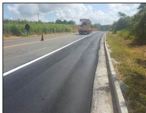
km 184 ao 197 - Preenchimento de Acostamento
