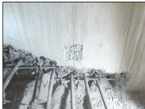
Aplicação de argamassa para tratamento das fissuras
