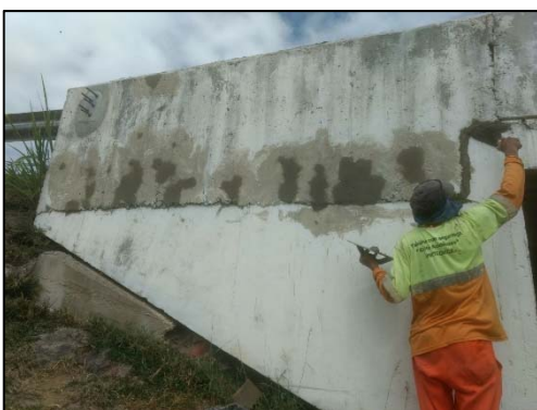
Aplicação de argamassa para tratamento das fissuras
