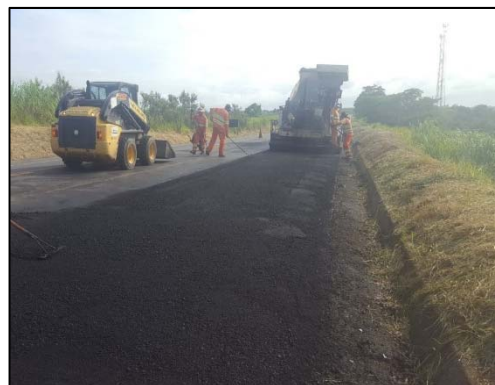
km 180 ao 197 - Preenchimento de Acostamento
