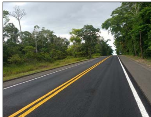
km 104 ao 106 - Microrevestimento
