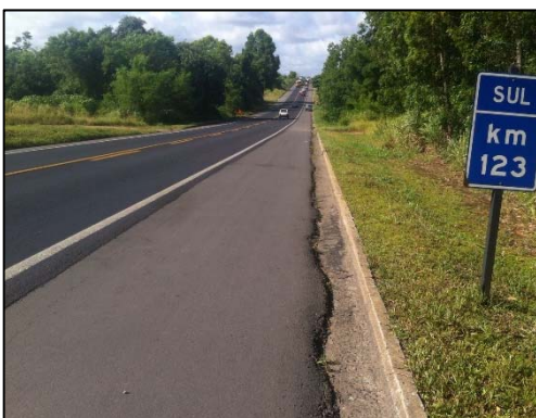
km 118 ao 125 - Microrevestimento
