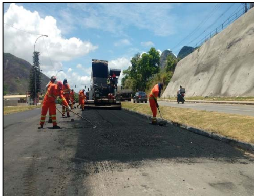
km 265 - Reparos localizados com aplicação de CBUQ
