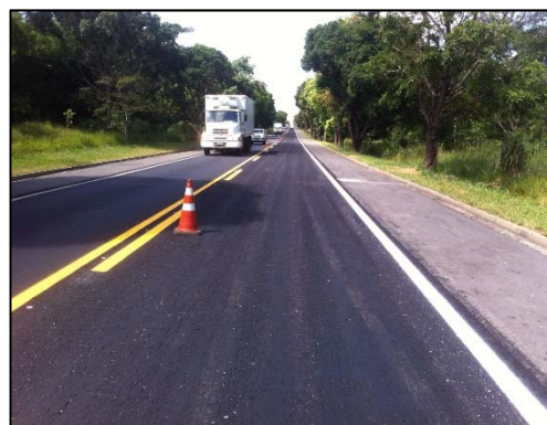
km 118 ao 125 - Microrevestimento
