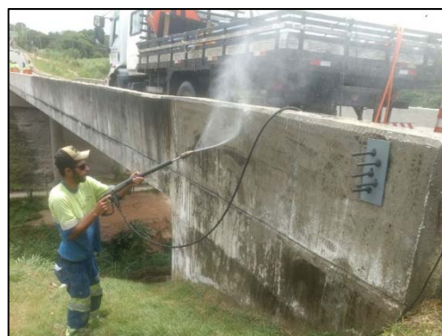
Jateamento com água para tratamento de fissuras
