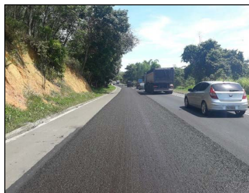
km 312 ao 313 - Microrevestimento
