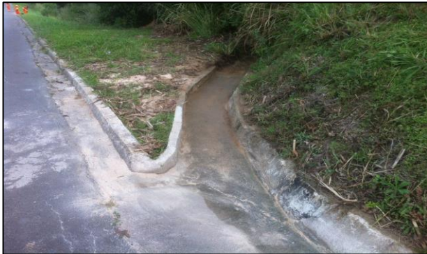
Limpeza superficial de drenagem - Km 21 ao 21,5 - 17/05/2018
