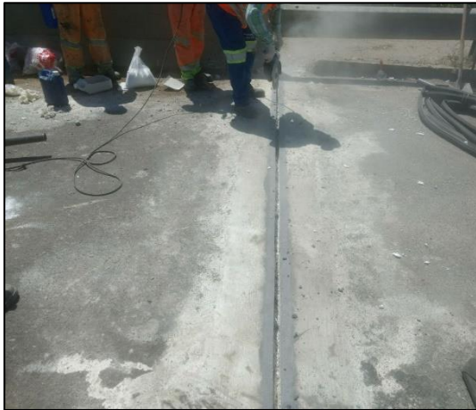
km 68,3 MN - Recuperação das Juntas de Dilatação
