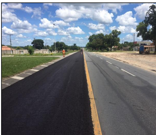
Km 92 - Microrevestimento e Limpeza
