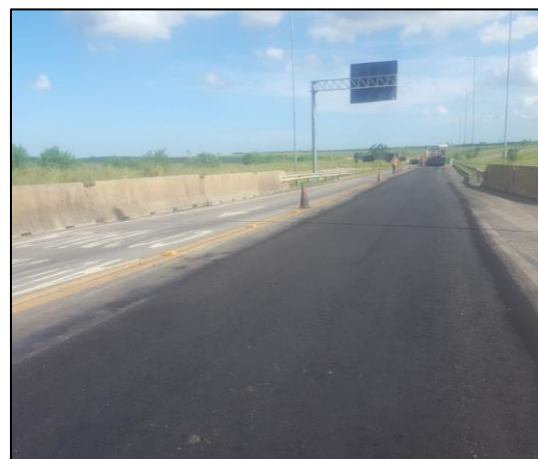
km 01 ao 02 - Preenchimento de Acostamento
