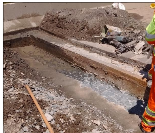
km 299,7 - Escavação para a execução de laje de aproximação
