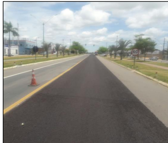
Km 65 ao 68 - Microrevestimento e Limpeza
