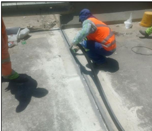
km 68,3 MN - Recuperação das Juntas de Dilatação
