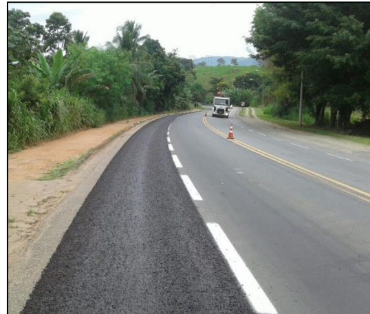
Km 230 ao 233 - Preenchimento de Acostamento
