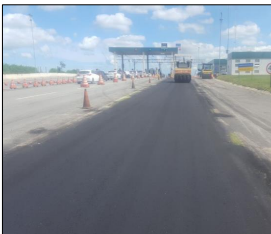
km 01 ao 02 Preenchimento de Acostamento
