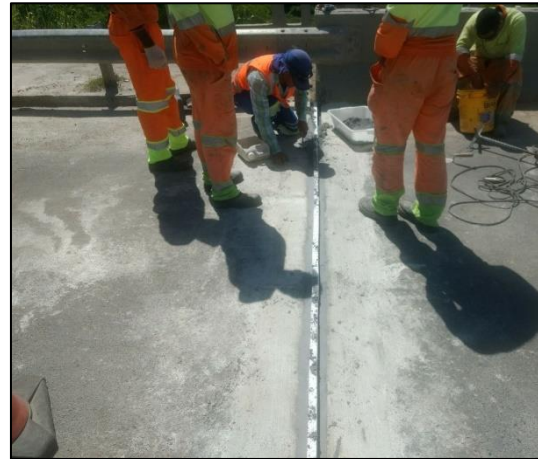
km 68,3 MN - Recuperação das Juntas de Dilatação
