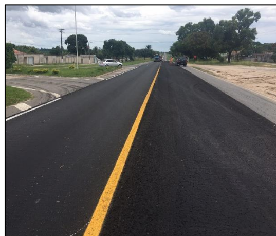
Km 92 - Microrevestimento e Limpeza
