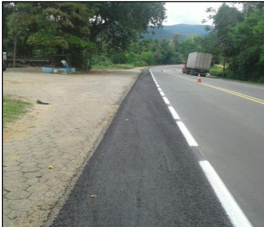
Km 230 ao 233 - Preenchimento de Acostamento
