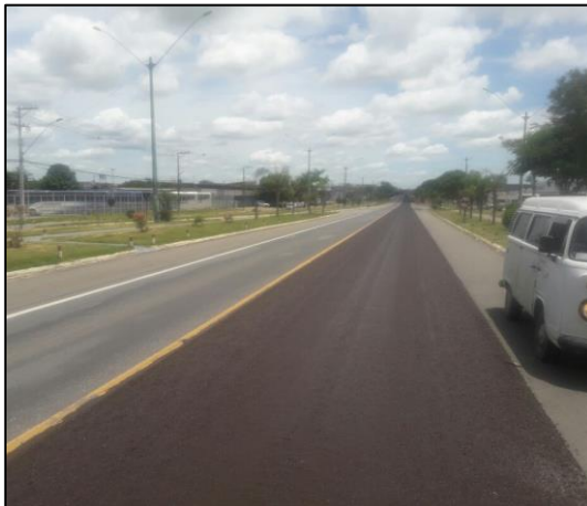
Km 65 ao 68 - Microrevestimento e Limpeza
