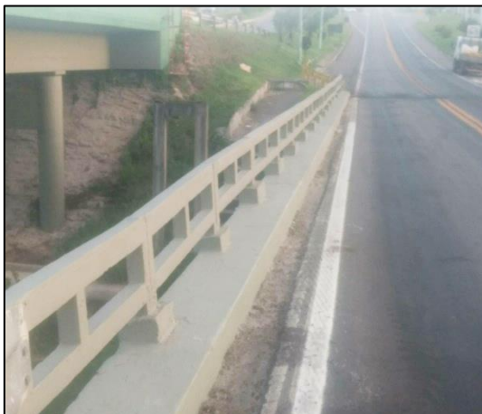
km 068,038 Central - Tratamento da superfície com pintura acrílica
