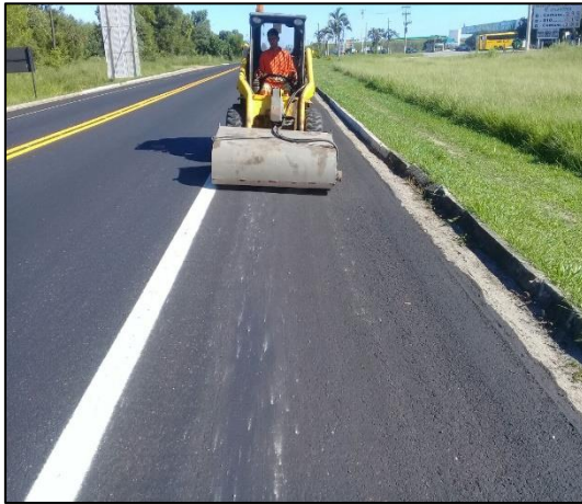
Km 49 ao 51 - Microrevestimento e Limpeza
