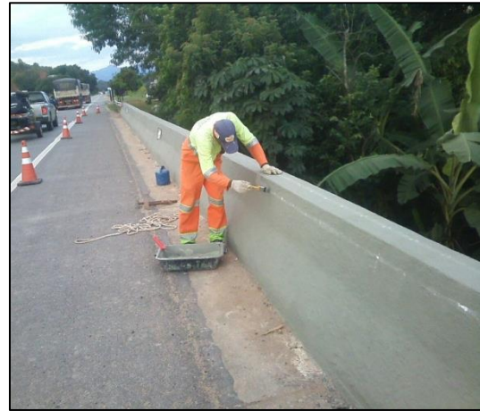
km 150,9 -- Tratamento da superfície da barreira rígida com pintura
