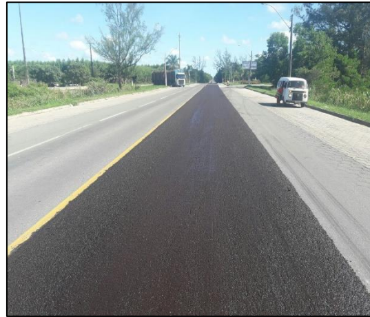
Km 49 ao 51 - Microrevestimento e Limpeza
