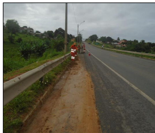
Km 31 –LIMPEZA DE DRENAGEM SUPERFICIAL MANUAL
