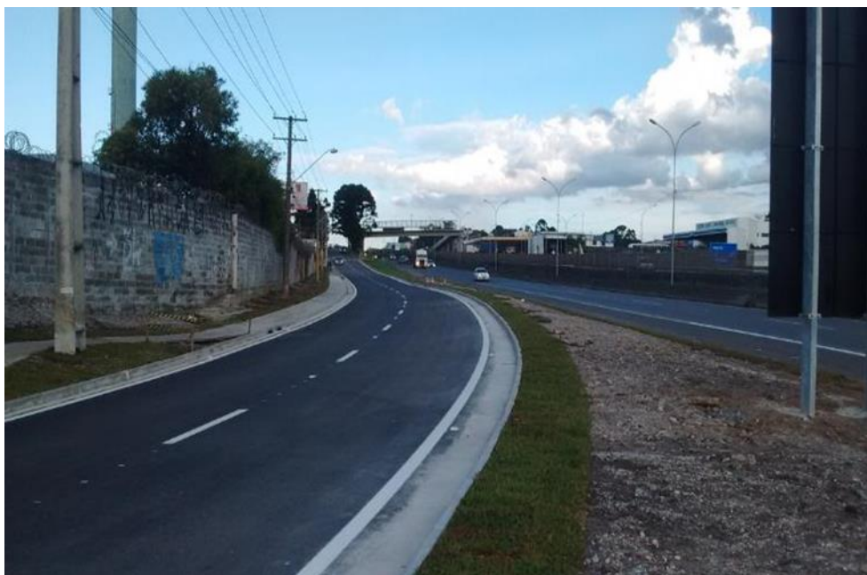
Figura 14 – Pavimento – Km 16+200 ao Km 17+500 Pista Sul
