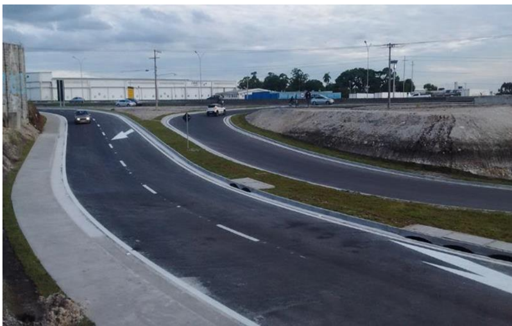
Figura 16 – Pavimento e Sinalização – Km 16+200 ao Km 17+500 Pista Sul
