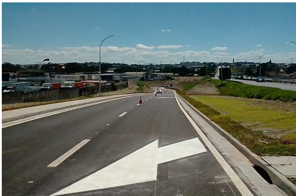
Figura 13 – Sinalização – Km 16+200 ao Km 17+500 Pista Norte
