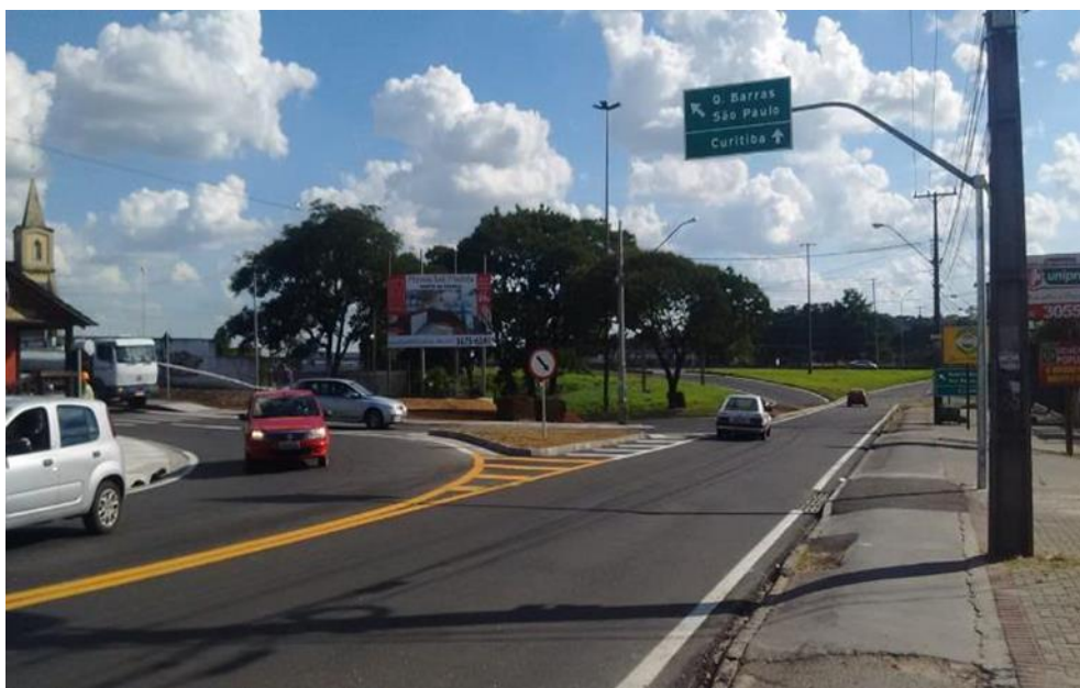
Figura 7 - Sinalização – Disp. Km 17+530
