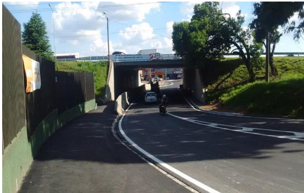
Figura 5 – Pavimento – Disp. Km 17+530.
