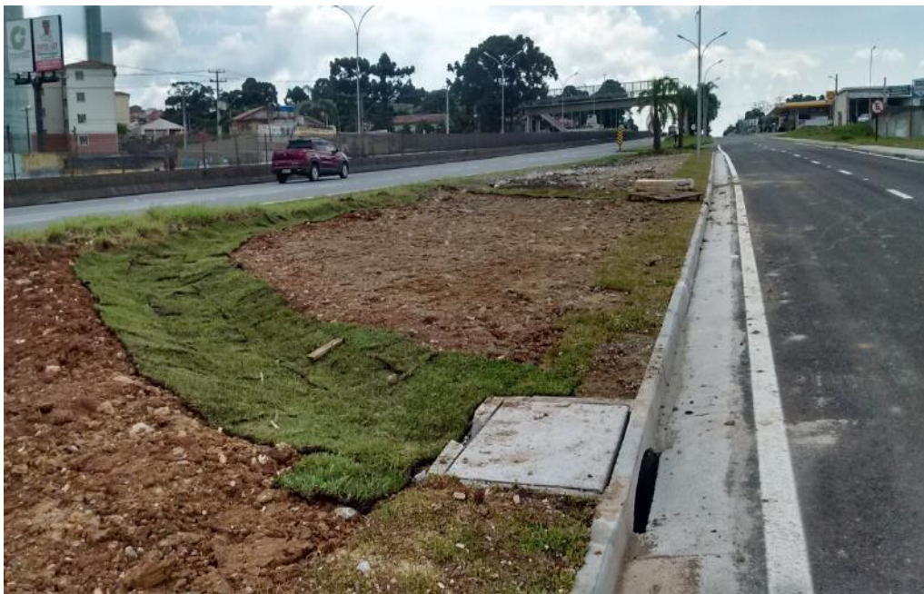
Figura 12 – Drenagem – Km 16+200 ao Km 17+500 Pista Norte
