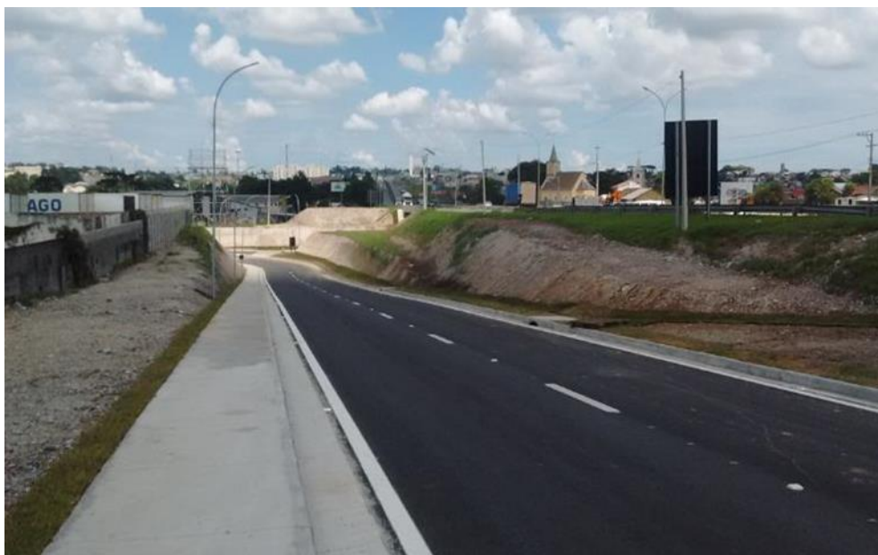
Figura 10 – Drenagem – Disp. Km 17+530
