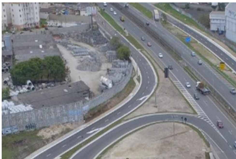
Figura 15 – Sinalização – Km 16+200 ao Km 17+500 Pista Sul
