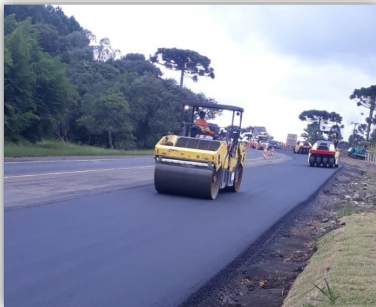
Figura 03 – Execução de Terceiras Faixas – km 127,790 ao 128,665
