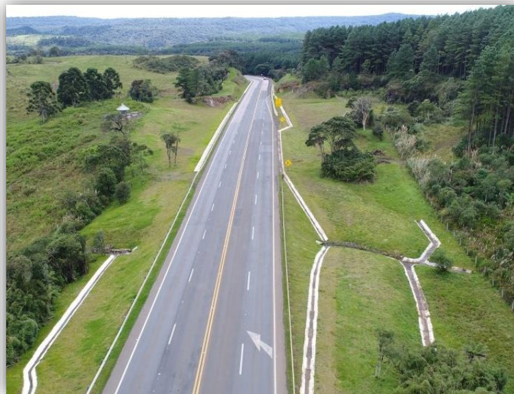
Figura 01 – Execução de Terceiras Faixas – km 115,265 ao 117,720
