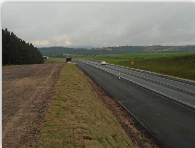
Figura 05 – Execução de Terceiras Faixas – km 211,434 ao 213,505
