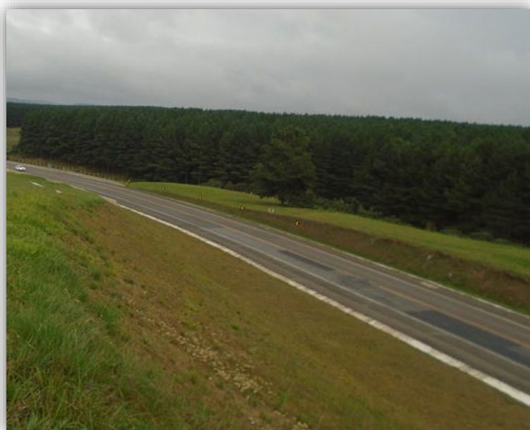
Figura 06 – Execução de Terceiras Faixas – km 212,035 ao 214,185
