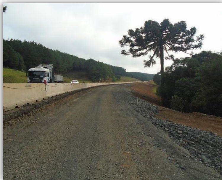
Figura 07 – Execução de Terceiras Faixas – km 248,025 ao 250,642
