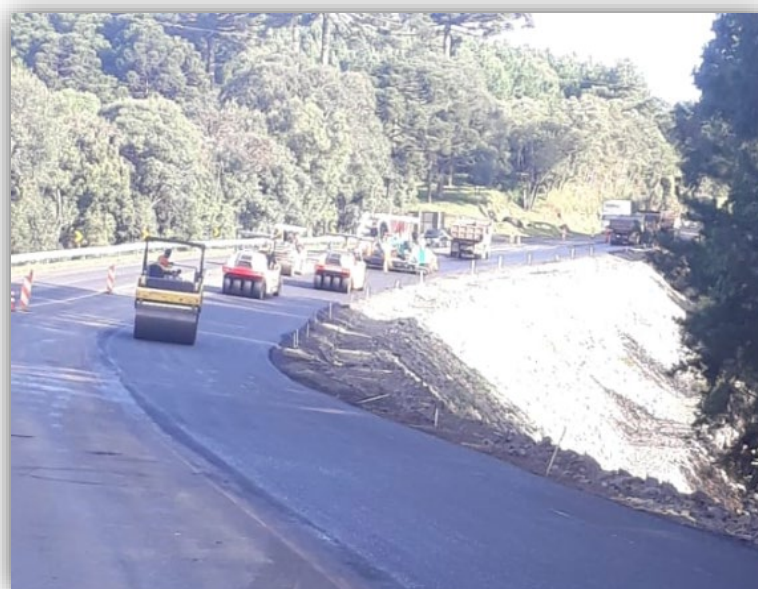
Figura 02 – Execução de Terceiras Faixas – km 124,795 ao 125,810
