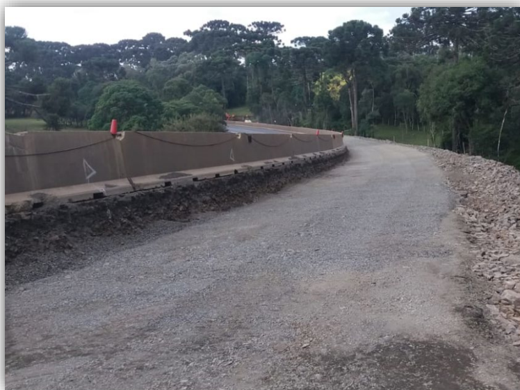
Figura 04 – Execução de Terceiras Faixas – km 156,075 ao 158,245
