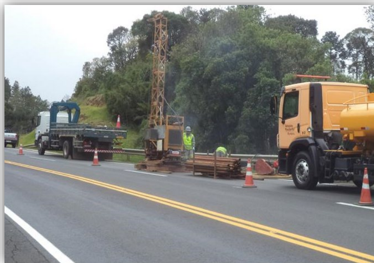
Figura 01 – Execução de Terceiras Faixas – km 115,265 ao 117,720
