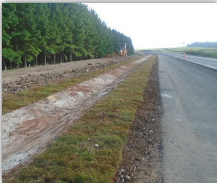
Figura 05 – Execução de Terceiras Faixas – km 211,434 ao 213,505
