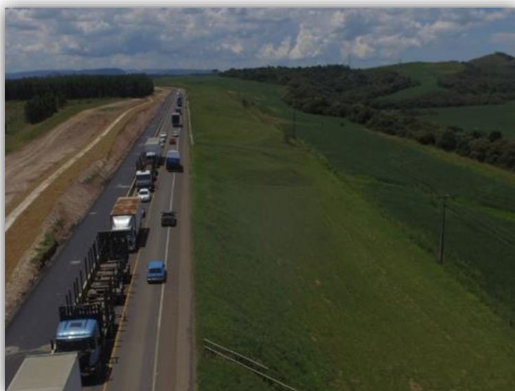
Figura 06 – Execução de Terceiras Faixas – km 212,035 ao 214,185
