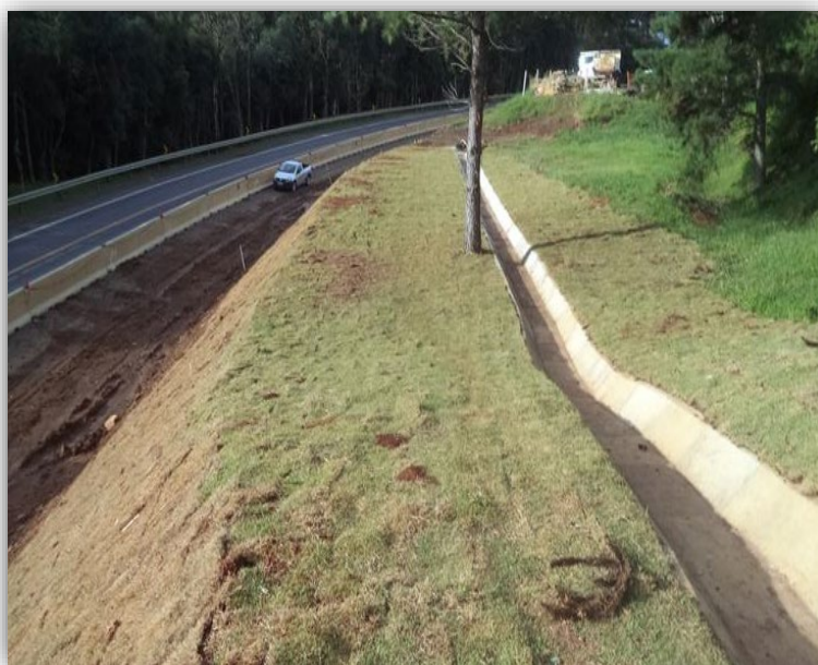
Figura 04 – Execução de Terceiras Faixas – km 156,075 ao 158,245
