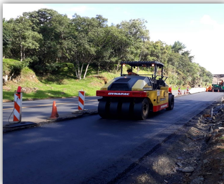
Figura 02 – Execução de Terceiras Faixas – km 124,795 ao 125,810
