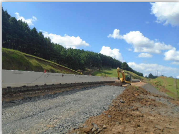
Figura 07 – Execução de Terceiras Faixas – km 248,025 ao 250,642
