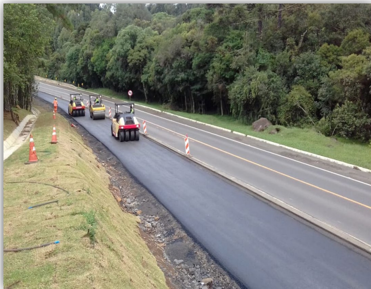
Figura 03 – Execução de Terceiras Faixas – km 127,790 ao 128,665
