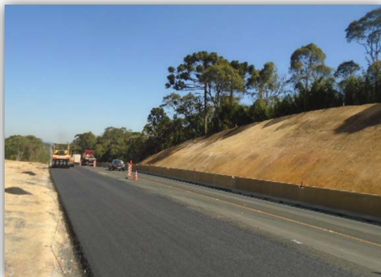
Figura 03 – Execução de Terceiras Faixas – km 015,105 ao 016,140
