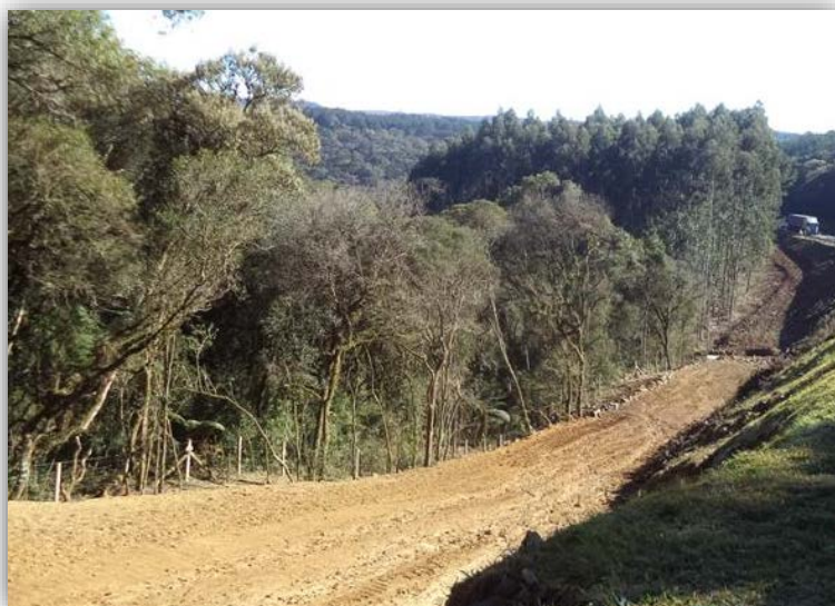
Figura 05 – Execução de Terceiras Faixas – km 124,795 ao 125,810
