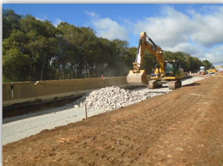
Figura 02 – Execução de Terceiras Faixas – km 014,775 ao 015,880
