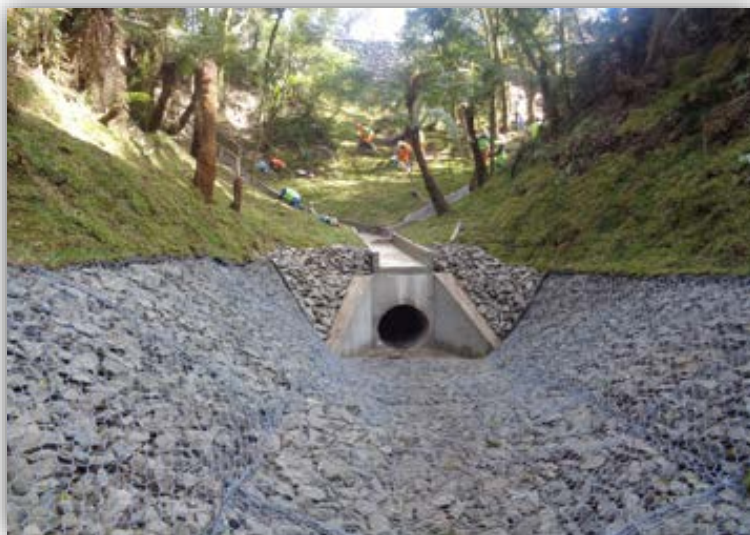
Figura 01 – Serra do Espigão – km 103,710 ao 103,755 (N) - Concluído
