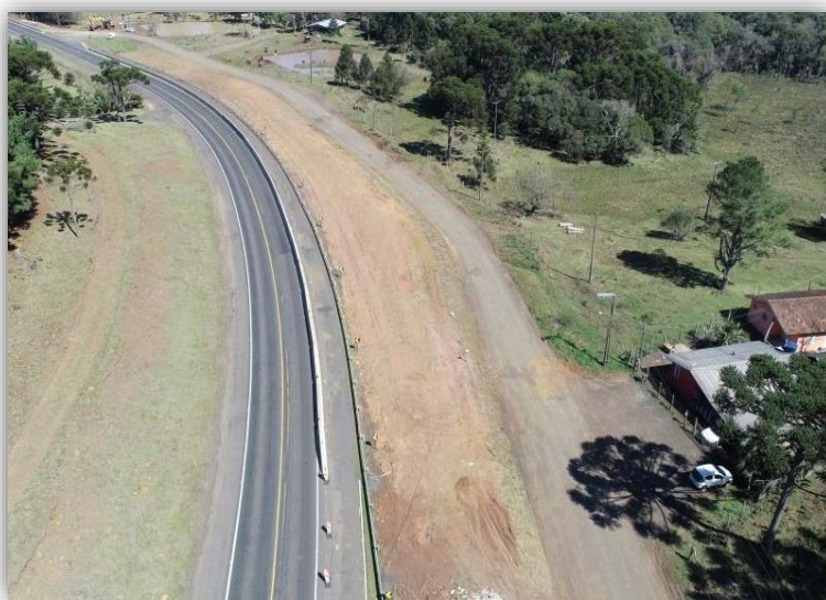
Figura 06 – Execução de Terceiras Faixas – km 127,790 ao 128,665
