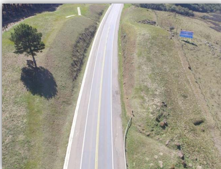
Figura 10 – Execução de Terceiras Faixas – km 248,025 ao 250,642
