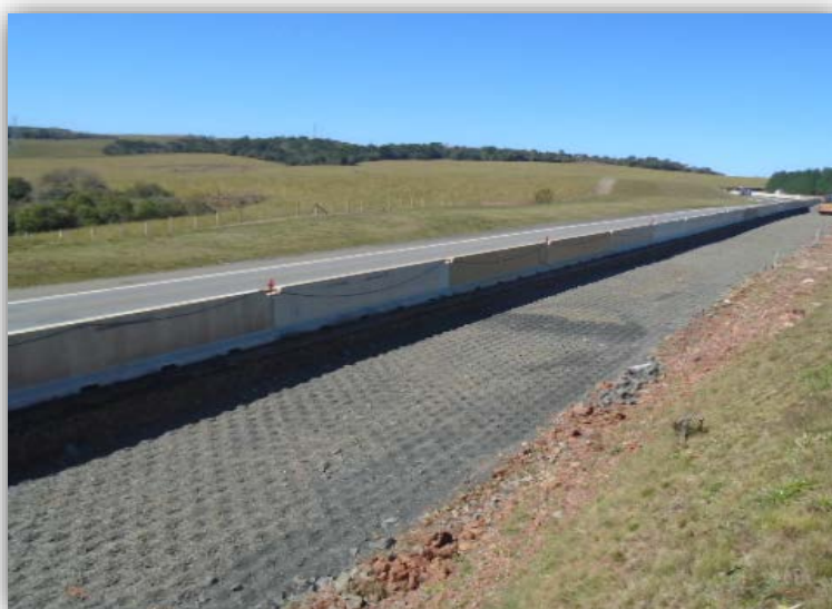
Figura 08 – Execução de Terceiras Faixas – km 211,434 ao 213,505
