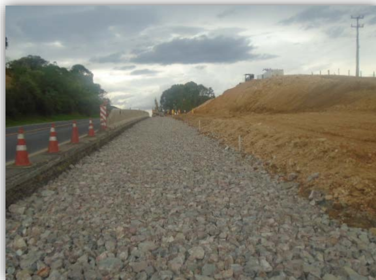
Figura 04 – Execução de Terceiras Faixas – km 015,105 ao 016,140
