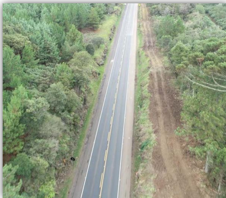
Figura 07 – Execução de Terceiras Faixas – km 127,790 ao 128,665
