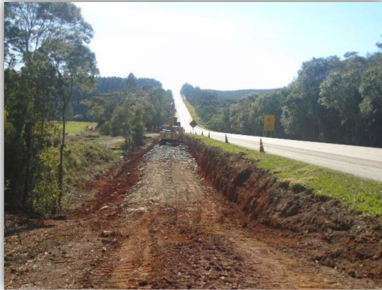
Figura 03 – Execução de Terceiras Faixas – km 014,775 ao 015,880
