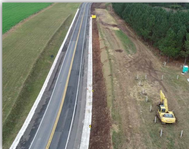
Figura 08 – Execução de Terceiras Faixas – km 211,434 ao 213,505
