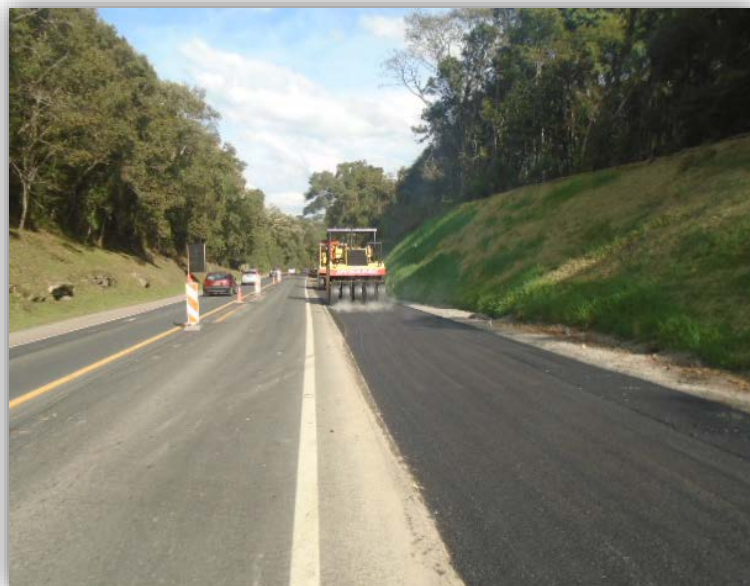
Figura 01 – Execução de Terceiras Faixas – km 009,646 ao 010,295
