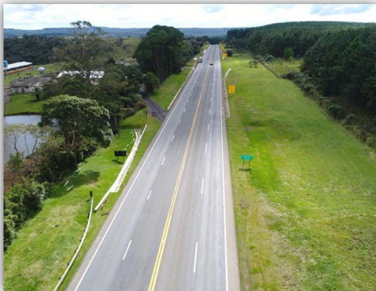
Figura 05 – Execução de Terceiras Faixas – km 115,265 ao 117,720
