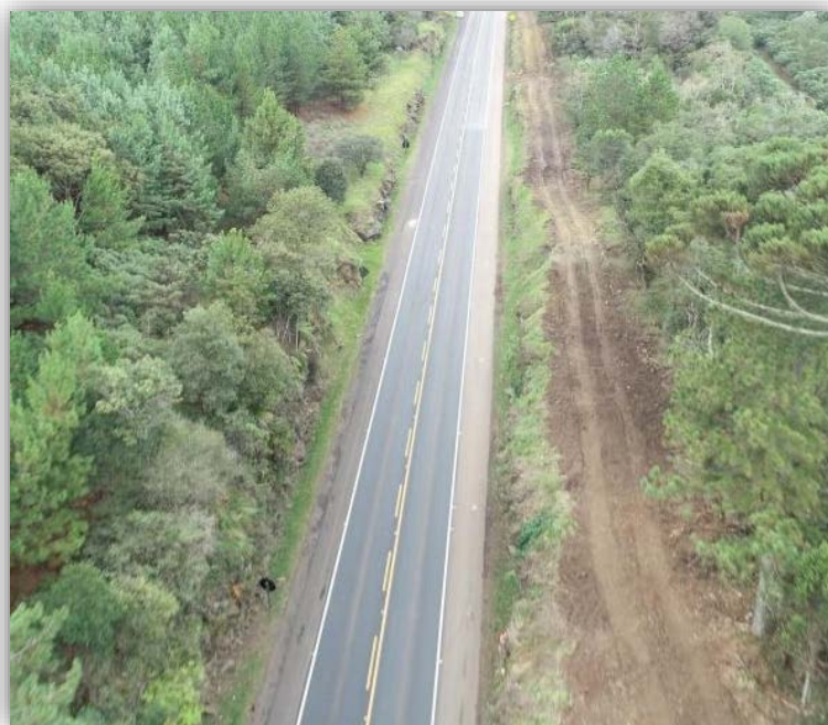
Figura 06 – Execução de Terceiras Faixas – km 124,795 ao 125,810
