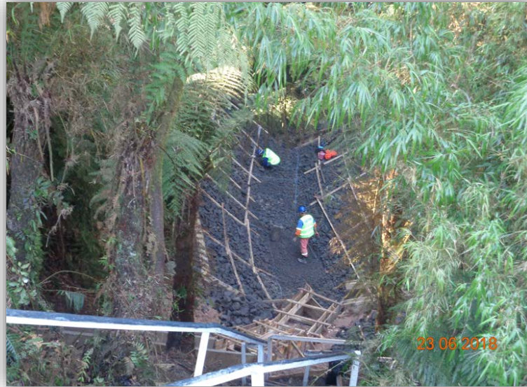
Figura 01 – Serra do Espigão – km 103,380 ao 103,430 (N/S)
