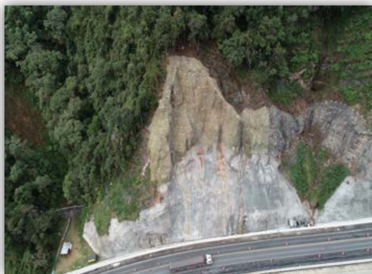
Figura 06 – Serra do Espigão – km 108,440 ao 108,770 (N) – Concluído
