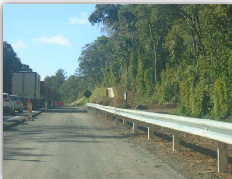
Figura 02 – Execução de Terceiras Faixas – km 012,097 ao 010,705
