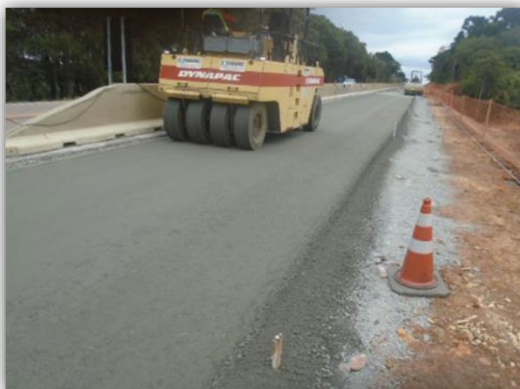
Figura 02 – Execução de Terceiras Faixas – km 014,775 ao 015,880
