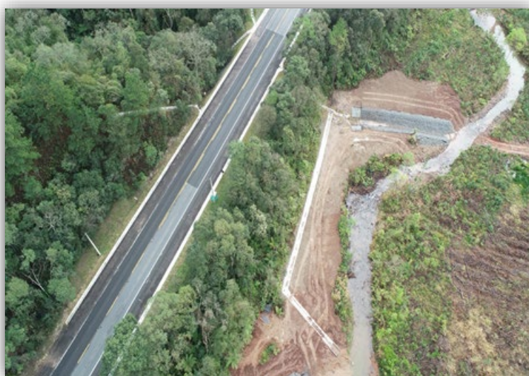
Figura 02 – Serra do Espigão – km 103,910 ao 104,030 (N/S) - Concluído
