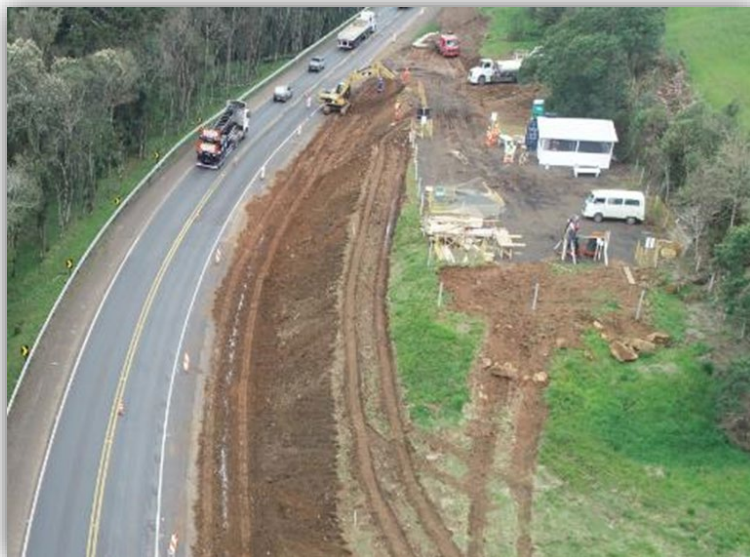
Figura 07 – Execução de Terceiras Faixas – km 156,075 ao 158,245
