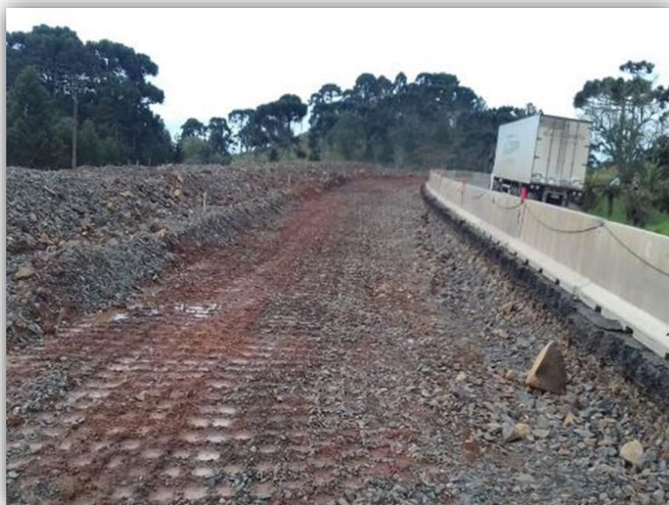
Figura 06 – Execução de Terceiras Faixas – km 127,790 ao 128,665
