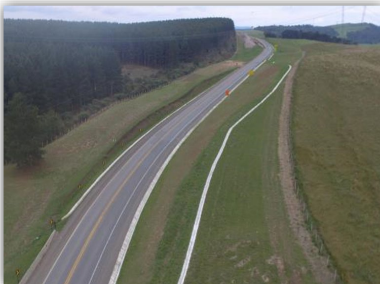
Figura 09 – Execução de Terceiras Faixas – km 212,035 ao 214,185
