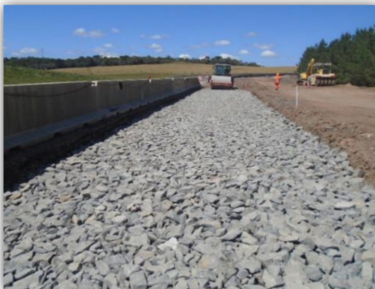
Figura 08 – Execução de Terceiras Faixas – km 211,434 ao 213,505
