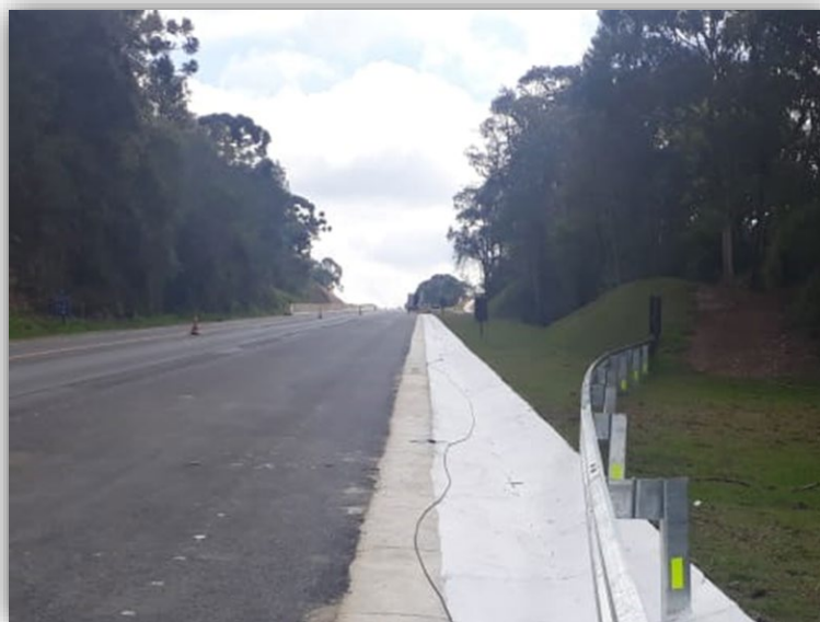
Figura 03 – Execução de Terceiras Faixas – km 015,105 ao 016,140
