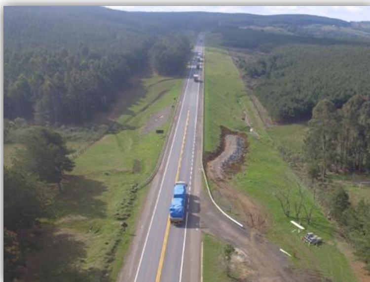
Figura 10 – Execução de Terceiras Faixas – km 248,025 ao 250,642
