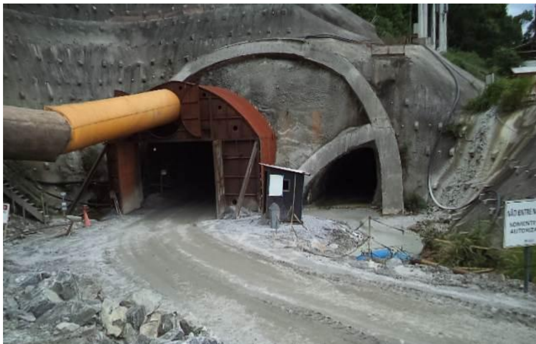
Figura 11 – Escavação do Túnel – frente desemboque - Nova Subida da Serra
