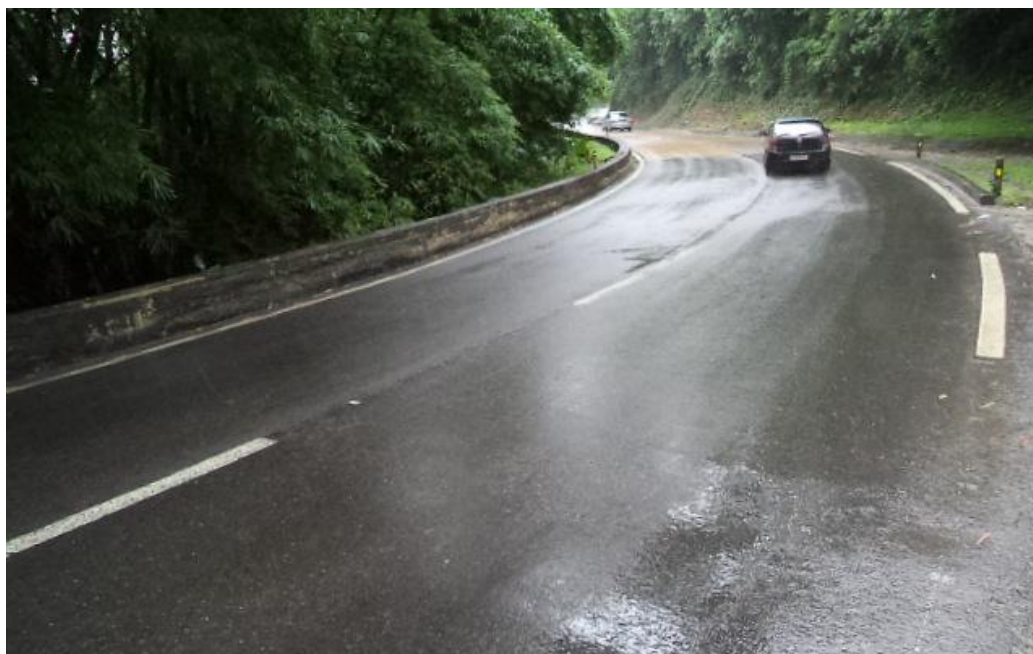
Figuras 01 – km 100 - sentido JF – Pavimento flexível sobre o pavimento rígido
