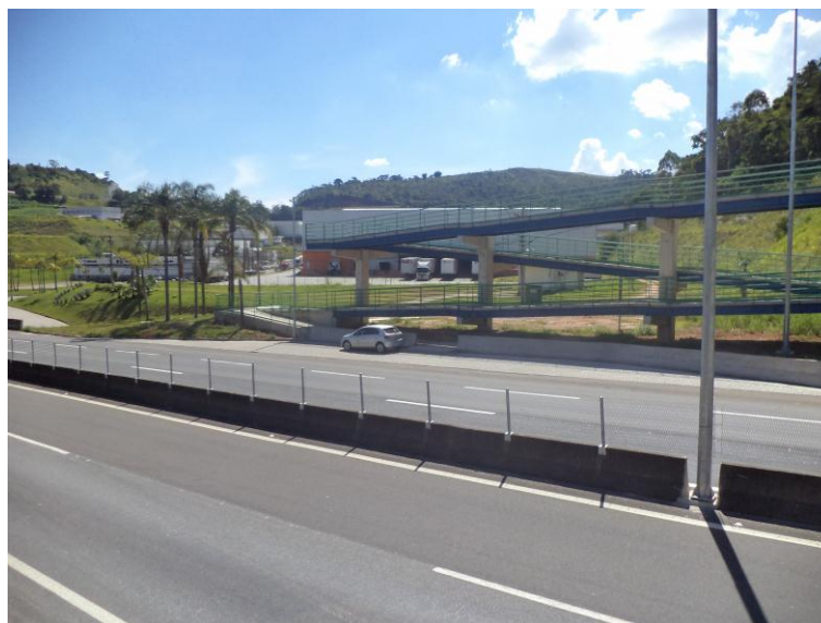
Figuras 05 e 06 – Km 801+000 – Implantação de Passarela Park Sul – Implantação de grama e guarda-corpo.
