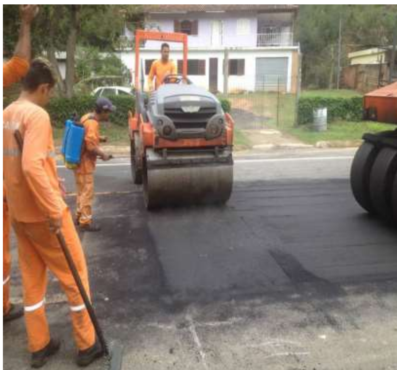
Manutenção da Rodovia – Pavimentação Betuminosa – Km 60,5 – P2 - Execução de acabamento da junta transversal
