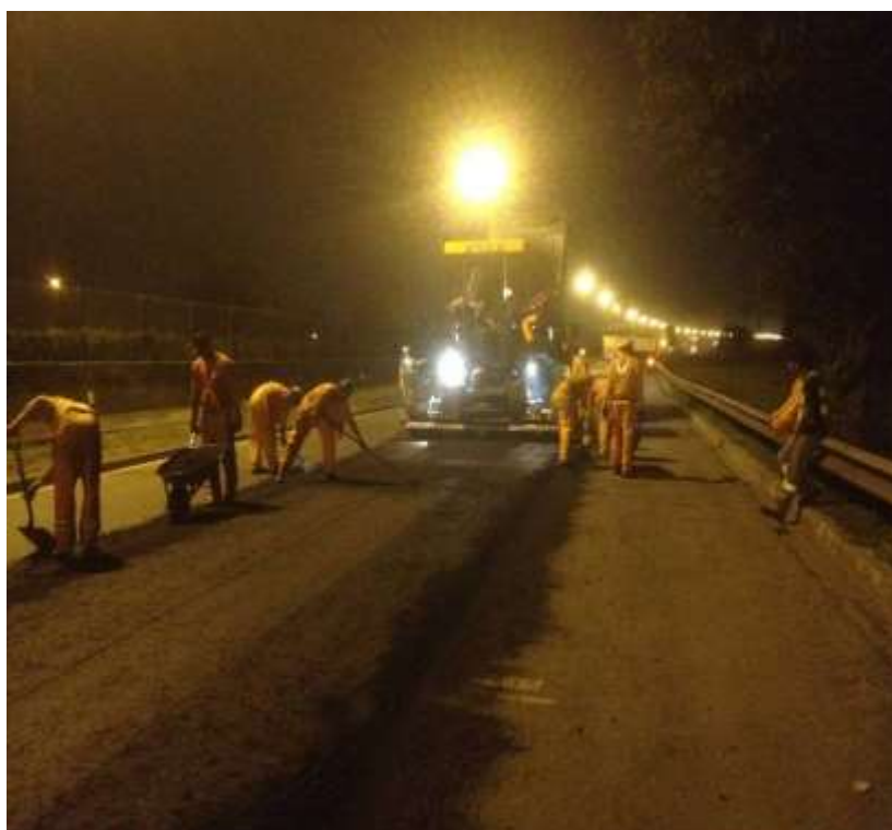
Manutenção da Rodovia – Pavimentação Betuminosa – Km 61,3 – P2 – Execução da fresagem
