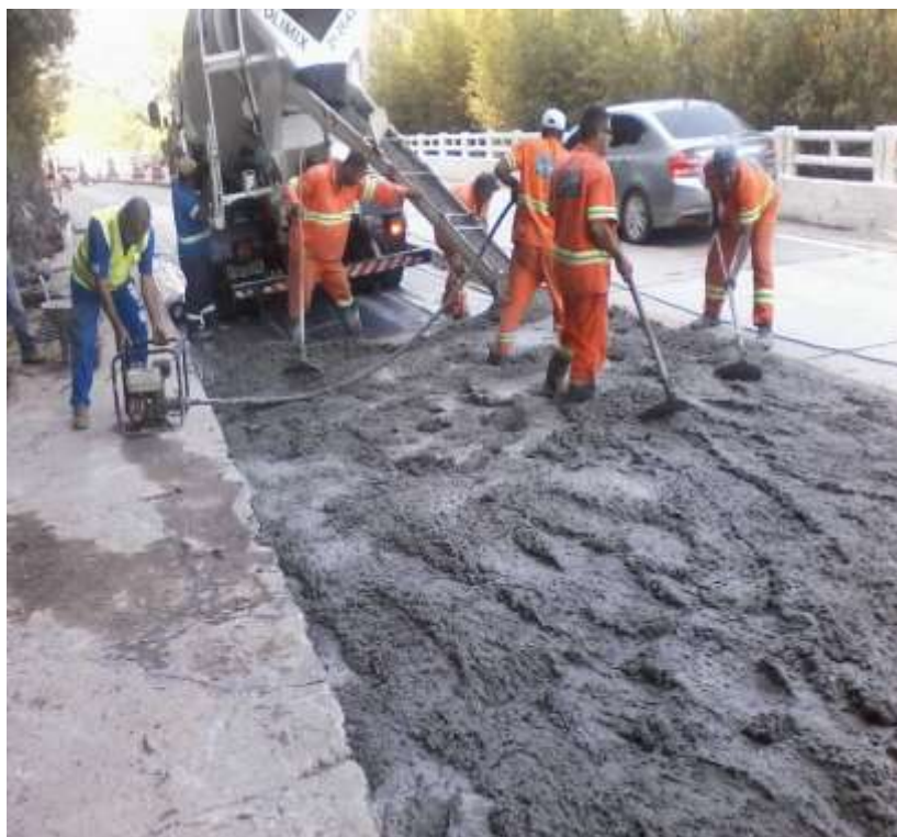
Manutenção da Rodovia - Pavimento Rígido – Km 93,5 – P2 - Execução de lançamento do concreto estrutural
