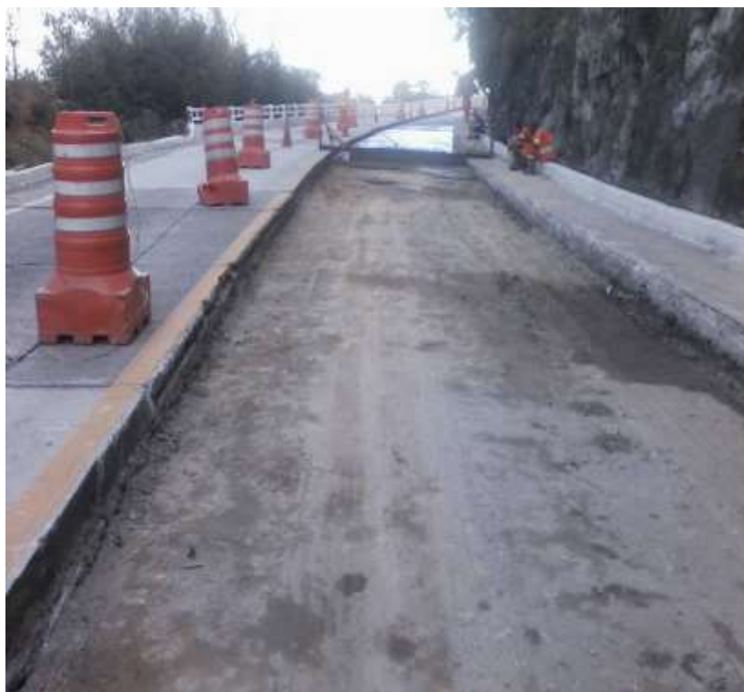
Manutenção da Rodovia - Pavimento Rígido – Km 93,5 – P2 – Execução de lançamento do concreto magro
