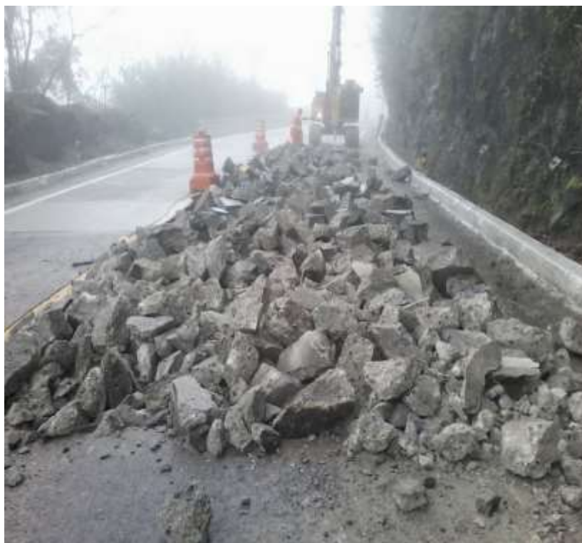
Manutenção da Rodovia - Pavimento Rígido – Km 93,5 – P2 – Execução de demolição
