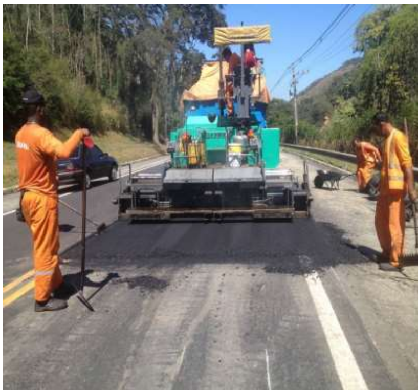
Manutenção da Rodovia – Pavimentação Betuminosa – Km 54,2 – P1 – Execução de aplicação de CBUQ
