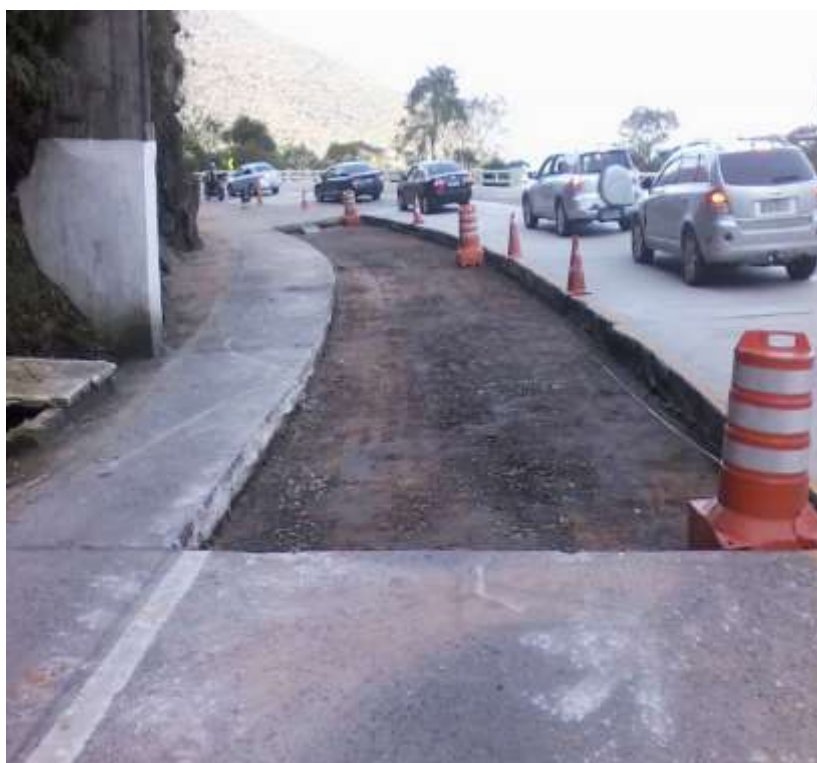
Manutenção da Rodovia - Pavimento Rígido – Km 93,5 – P2 – Execução de compactação do subleito
