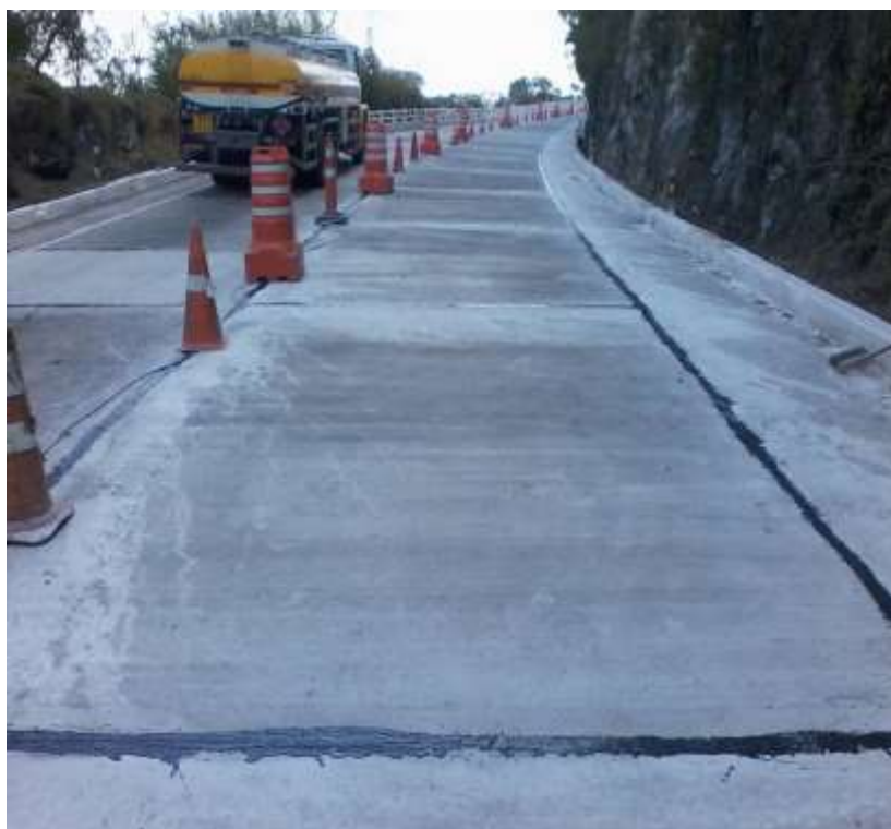
Manutenção da Rodovia - Pavimento Rígido – Km 93,5 – P2 – Execução de selagem das placas
