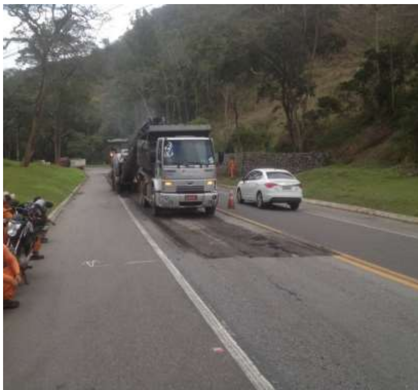
Manutenção da Rodovia – Pavimentação Betuminosa – Km 61,3 – P2 – Execução da fresagem
