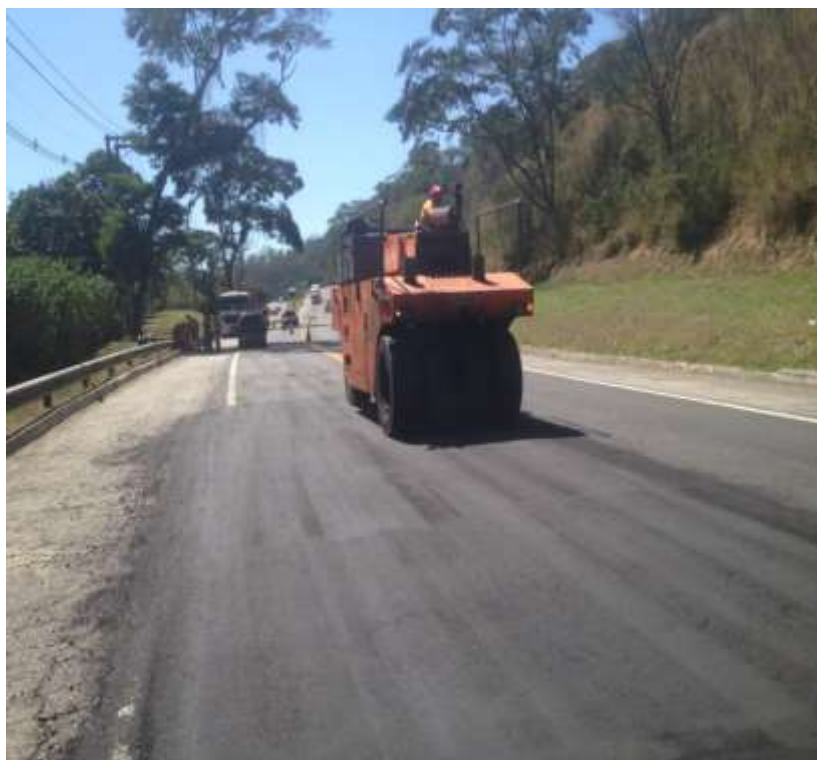
Manutenção da Rodovia – Pavimentação Betuminosa – Km 54,2 – P1 - Execução de rolagem do plano asfáltico
