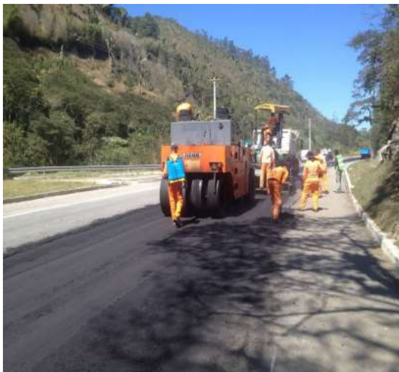
Manutenção da Rodovia – Pavimentação Betuminosa – Km 64 – P1 - Execução de aplicação e rolagem de CBUQ
