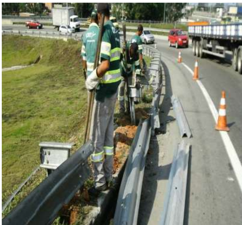
Conservação da Rodovia – Setor viário – Km 144 – P1 – Serviço de manutenção de defesa metálica
