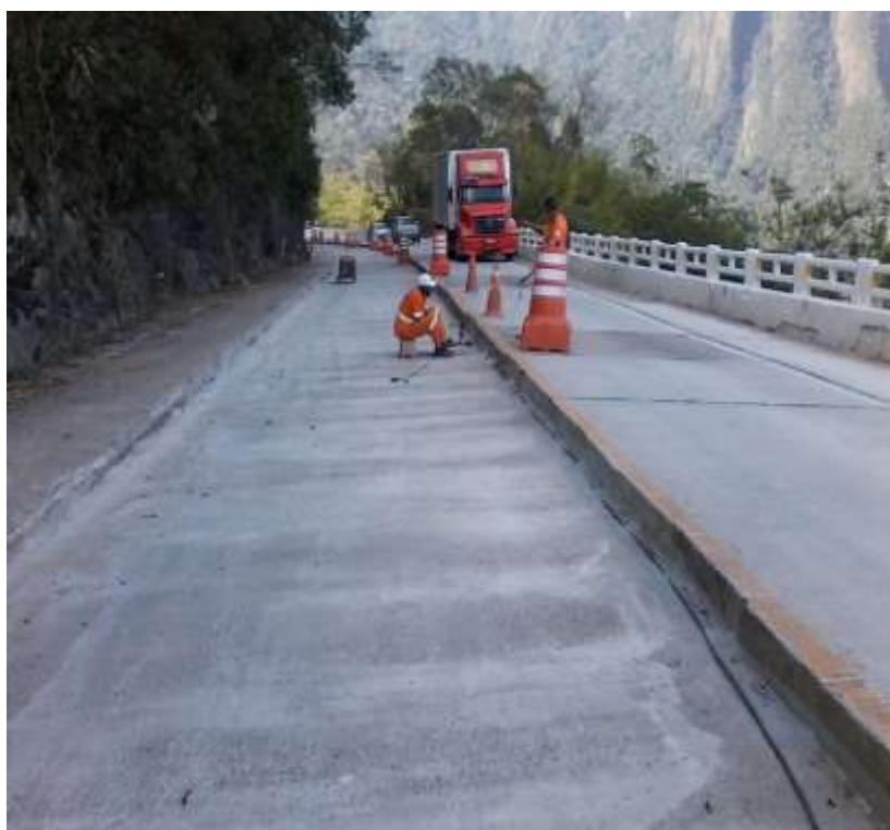
Manutenção da Rodovia - Pavimento Rígido – Km 93,5 – P2 – Execução de furação das placas
