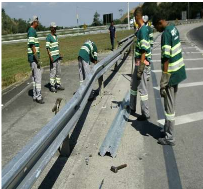
Conservação da Rodovia – Setor viário – Km 122 – P1 – Serviço de manutenção de defesa metálica
