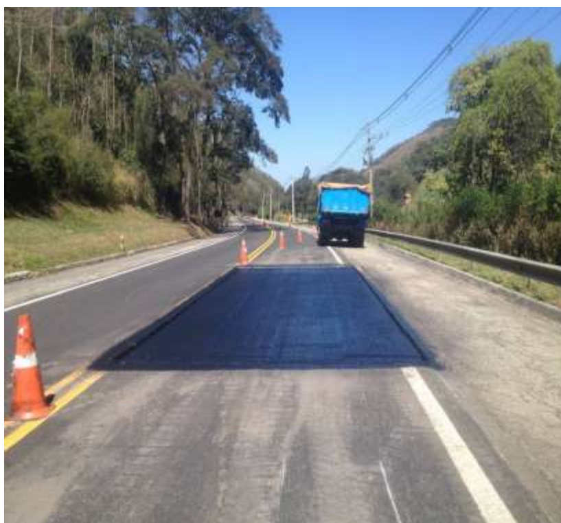
Manutenção da Rodovia – Pavimentação Betuminosa – Km 54,2 – P1 – Execução de imprimação RR-2C
