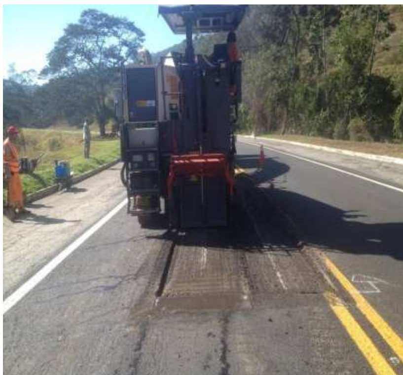
Manutenção da Rodovia – Pavimentação Betuminosa – Km 53,5 – P1 – Execução da fresagem
