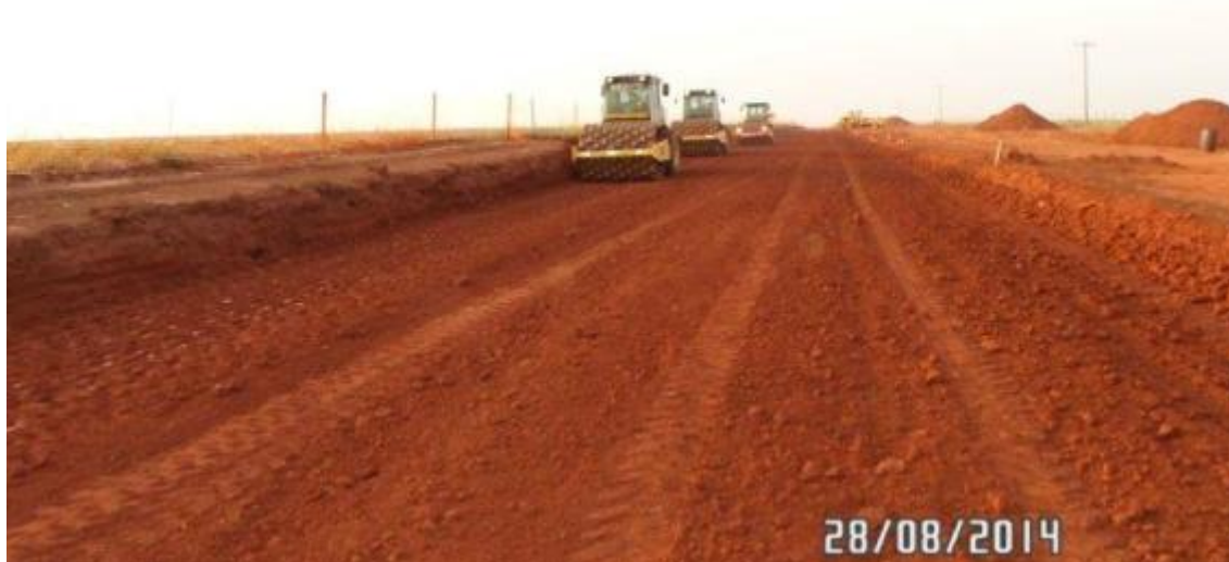
Figura 12 – Terraplenagem – Duplicação km 826+500 ao 832+600 Pista Norte – Vista Norte
