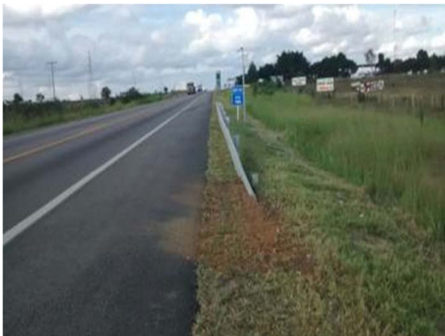
Figura 07 – Implantação de Defensas Metálicas
