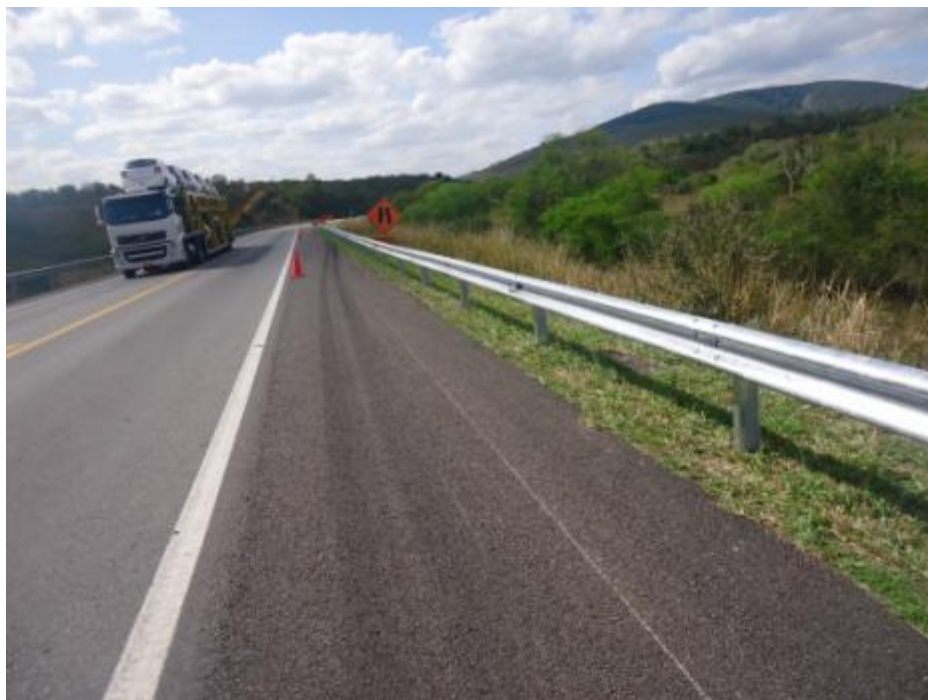
Figura 07 – Implantação de Defensas Metálicas
