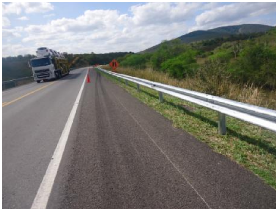
Figura 07 – Implantação de Defensas Metálicas
