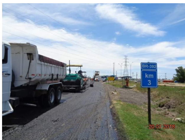
Figura 03 – Recomposição de acostamentos BR-392 km 2+410 ao 8+500
