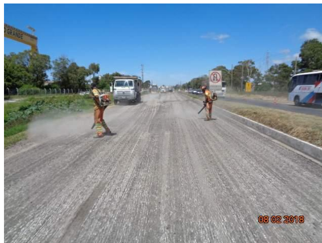
Figura 02 – Serviços de recuperação do pavimento BR-392 km 2+410 ao 8+500
