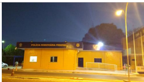
Reforma da PRF Paracatu - Concluído
