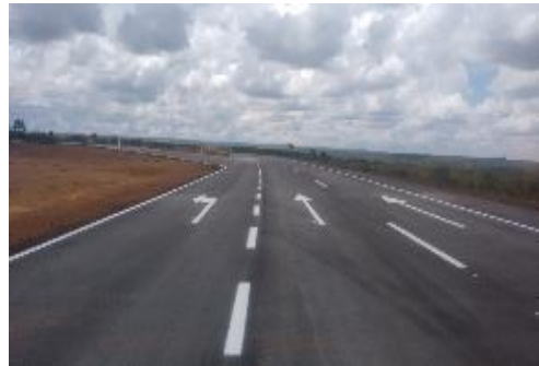
Retorno em Nível - Km 115+000/GO - Concluído
