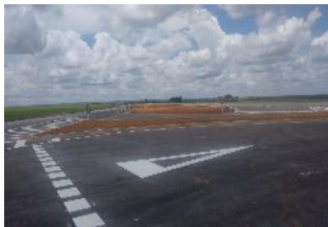
Retorno em Nível - Km 120+700/GO - Concluído
