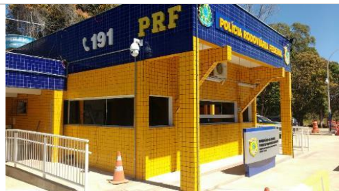
Reforma da PRF Três Marias - Concluído
