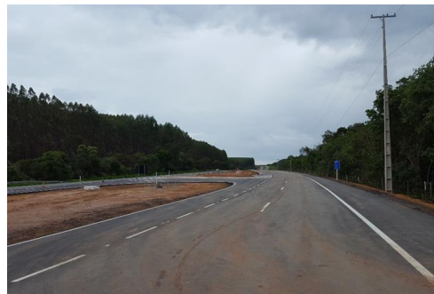
Retorno em Nível - 172+000/MG - Concluído
