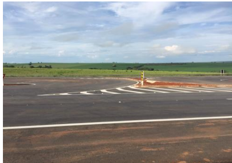
Retorno em Nível – Km 71+300/GO - Concluído
