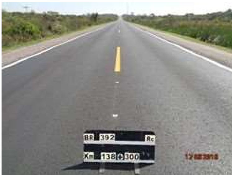
Figura 02 – Recuperação do Pavimento – BR-392/RS
