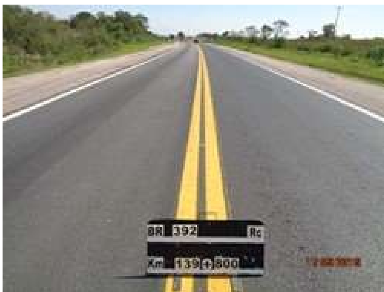
Figura 03 – Recuperação do Pavimento – BR-392/RS
