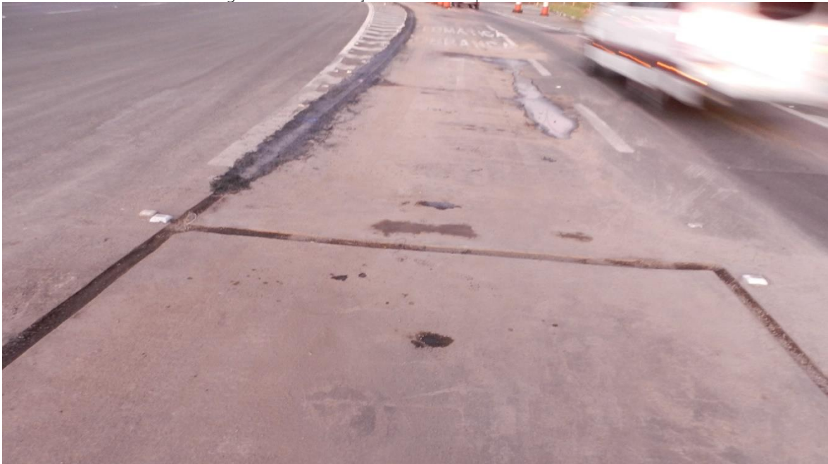
Figura 53 – Ramificação do corte no pavimento asfáltico.
