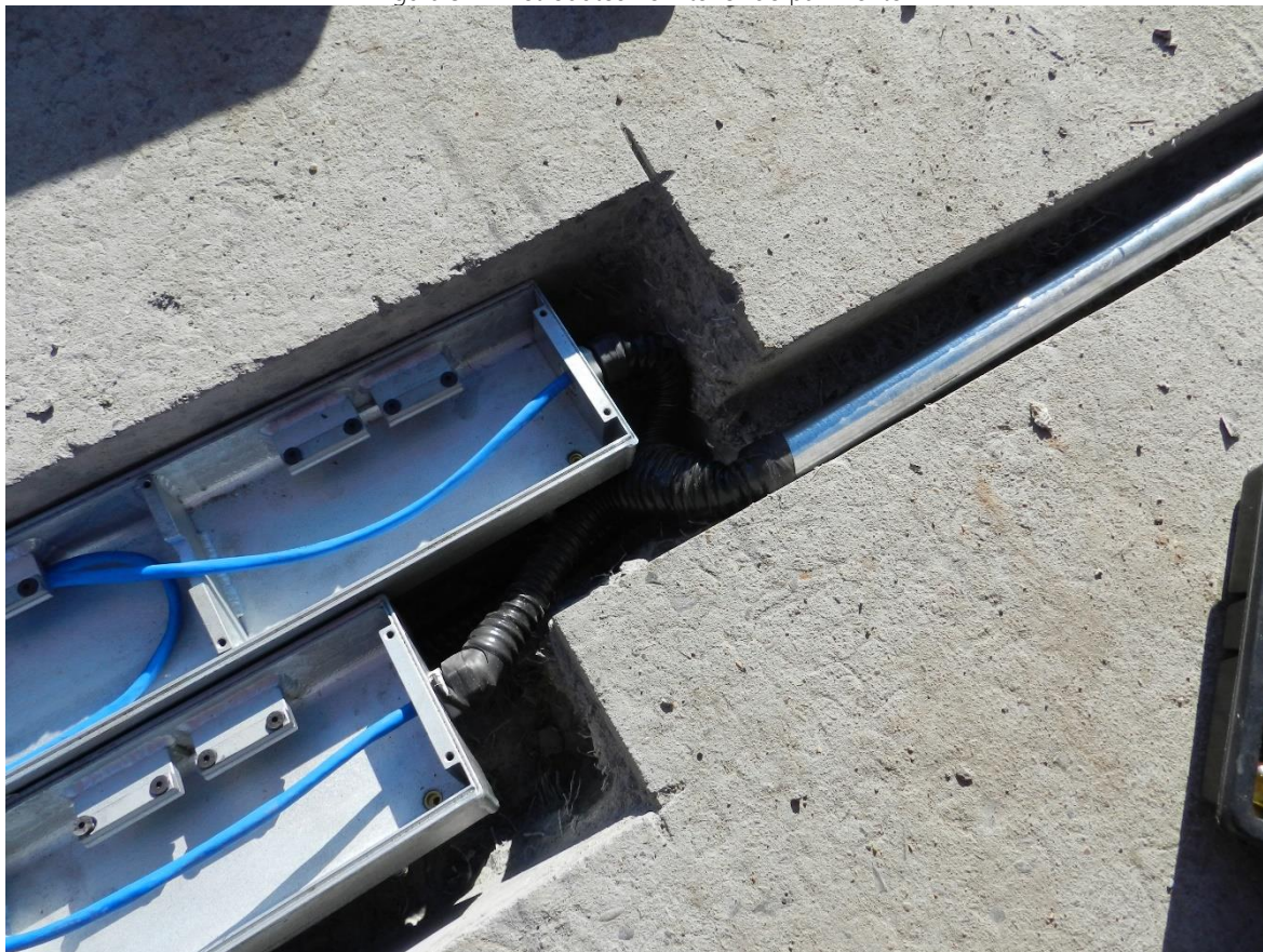
Figura 52 – Eletrodutos no interior do pavimento
