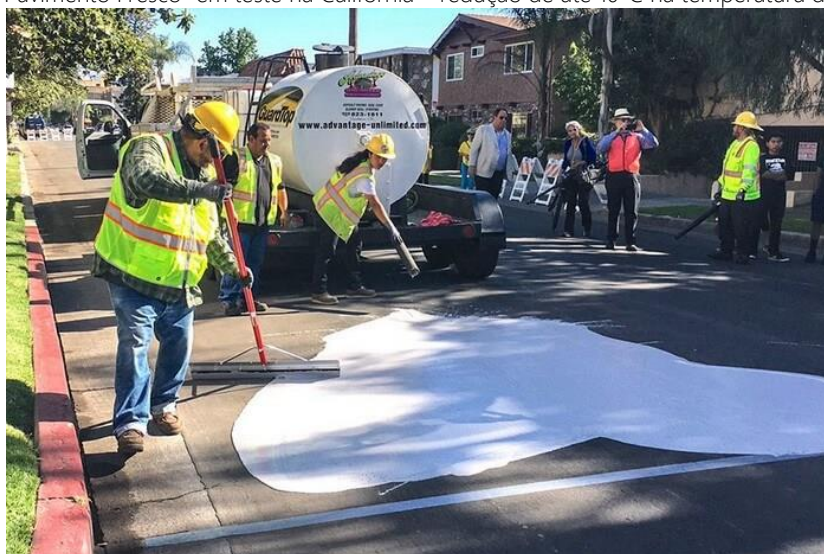
Figura 2 – “Pavimento Fresco” em teste na Califórnia – redução de até 10°C na temperatura do pavimento
