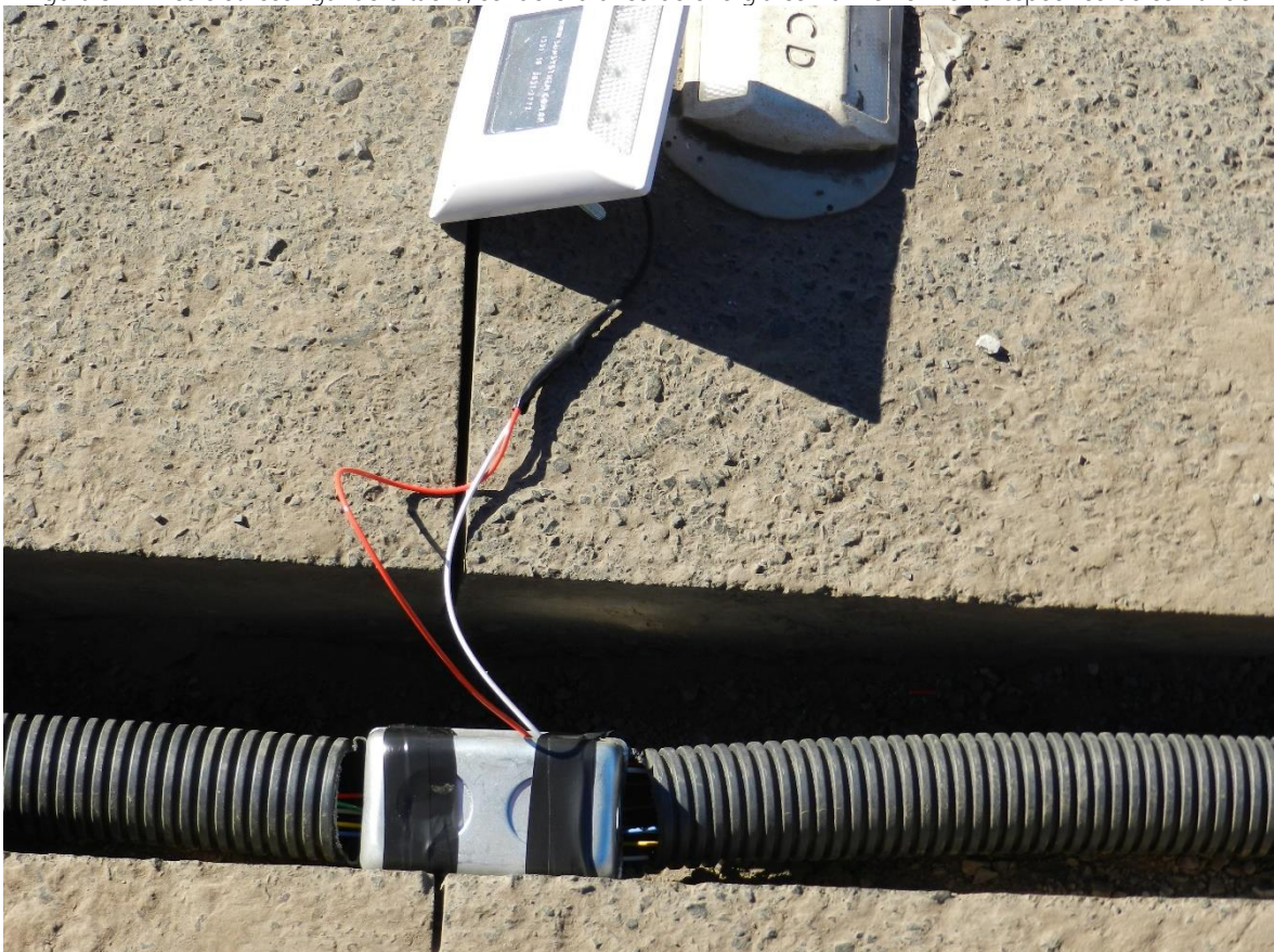
Figura 54 – Fios elétricos ligando a tacha, sendo o branco de energia comum e vermelho específico de comando
