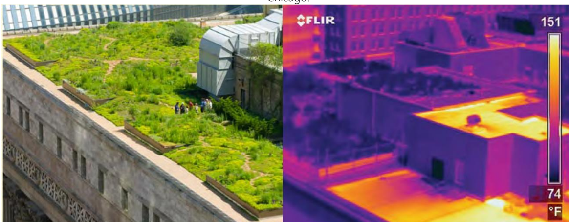
Figura 6 – Comparação da temperatura de um prédio sem telhado verde e com o Green Roof sobre a prefeitura de Chicago.
