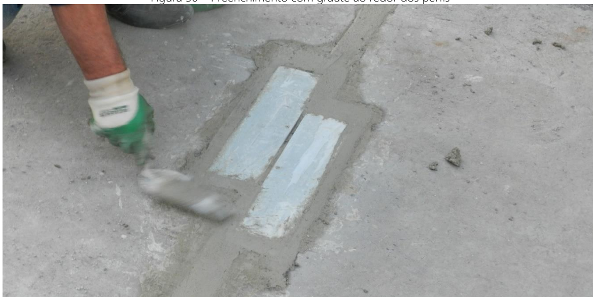
Figura 50 – Preenchimento com graute ao redor dos perfis
