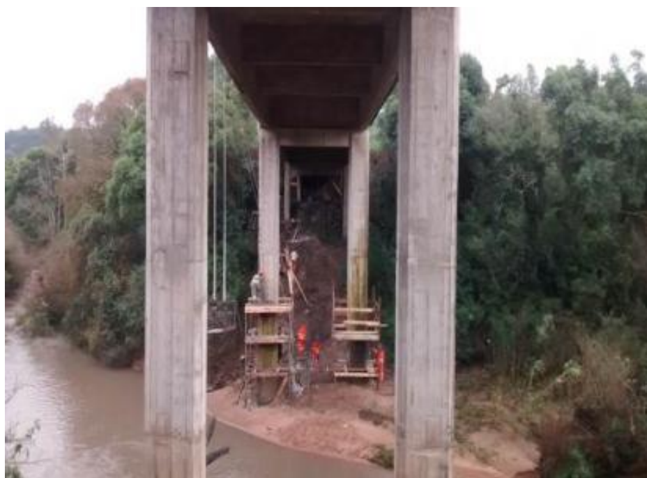
Figura 06 – Obras de Arte Especiais
