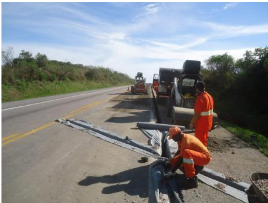
Figura 04 – Drenos de Pavimento
