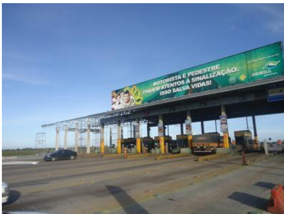
Figura 07 – Ampliação da Praça de Pedágio Capão Seco
