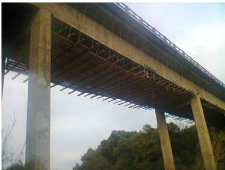
Figura 05 – Obras de Arte Especiais
