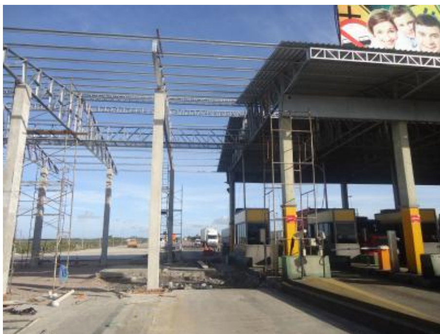
Figura 08 – Ampliação da Praça de Pedágio Capão Seco
