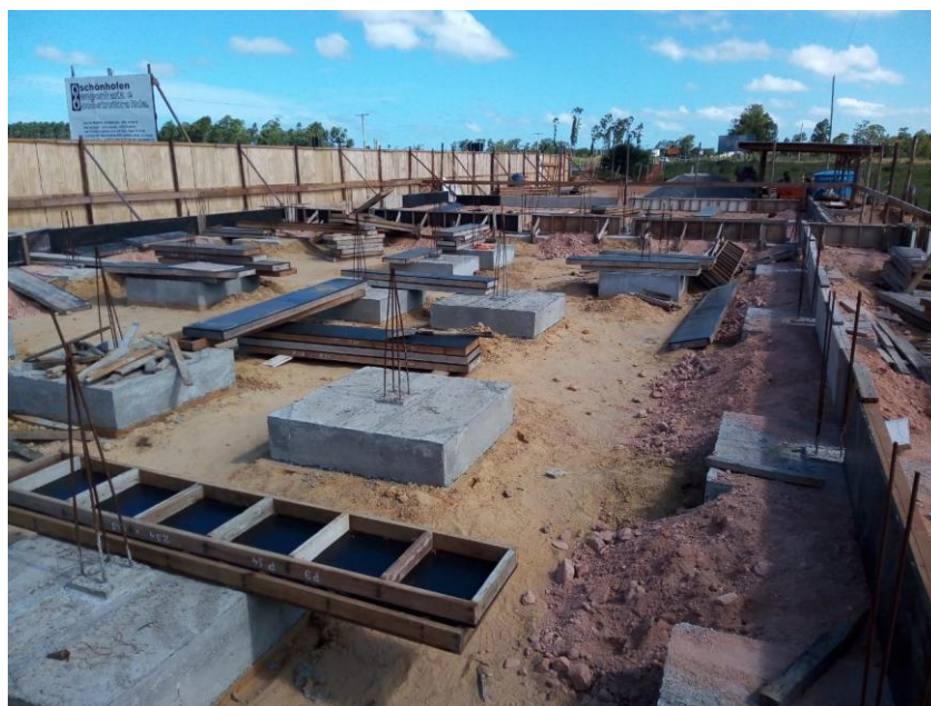
Figura 04 – Serviços de desforma das fundações – Base Operacional - BR-392/RS – Trecho: Pelotas – Rio Grande / km 033,059
