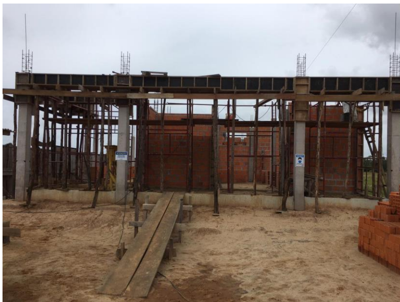
Figura 03 – Execução da alvenaria – Base Operacional - BR-392/RS – Trecho: Pelotas – Rio Grande / km 033,059
