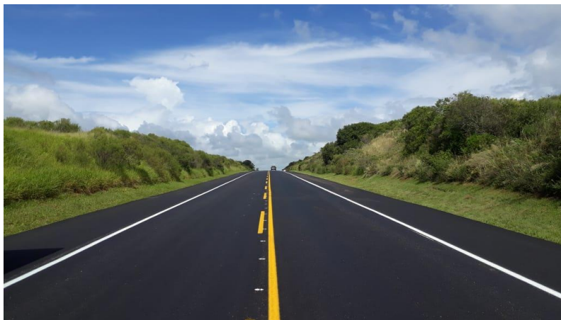
Figura 02 – Serviços de Pavimentação e Sinalização Horizontal BR-116/RS – Trecho: Pelotas – Jaguarão / km 627,000
