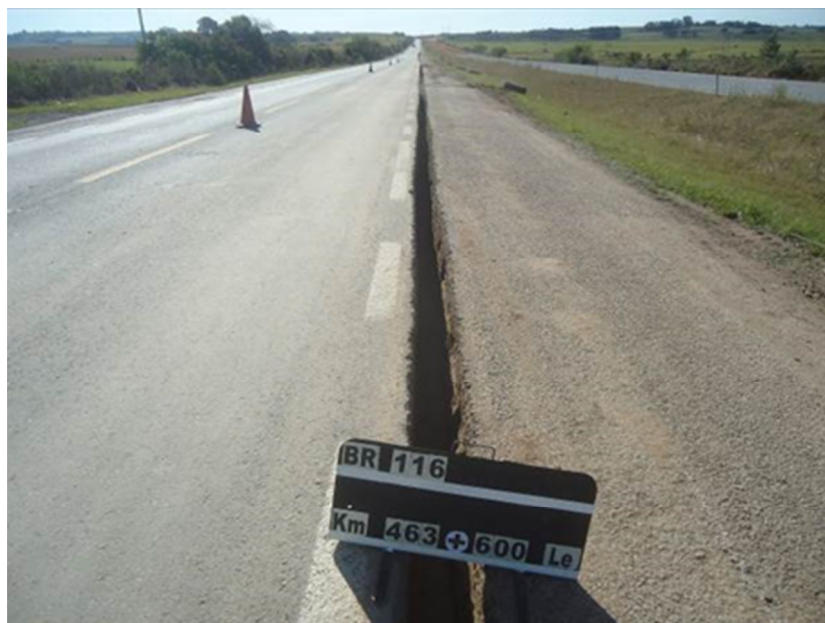
Figura 04 – Implantação drenos de pavimento – BR-116/RS
