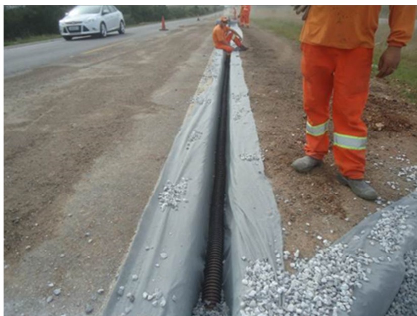
Figura 05 – Implantação drenos de pavimento – BR-116/RS
