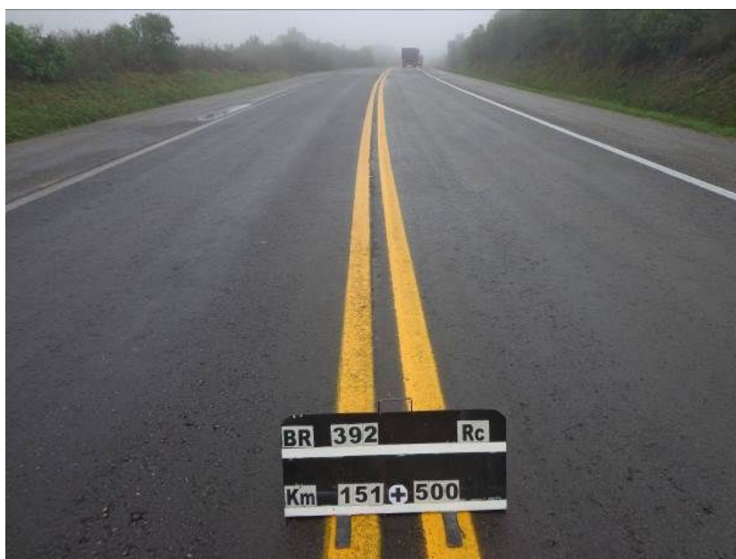
Figura 03 – Manutenção do Pavimento – BR-392/RS
