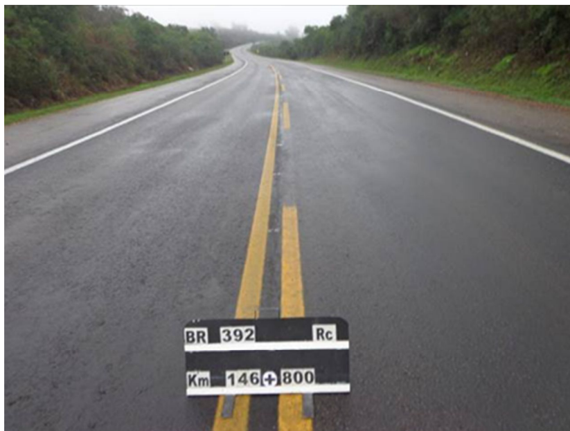
Figura 02 – Manutenção do Pavimento – BR-392/RS
