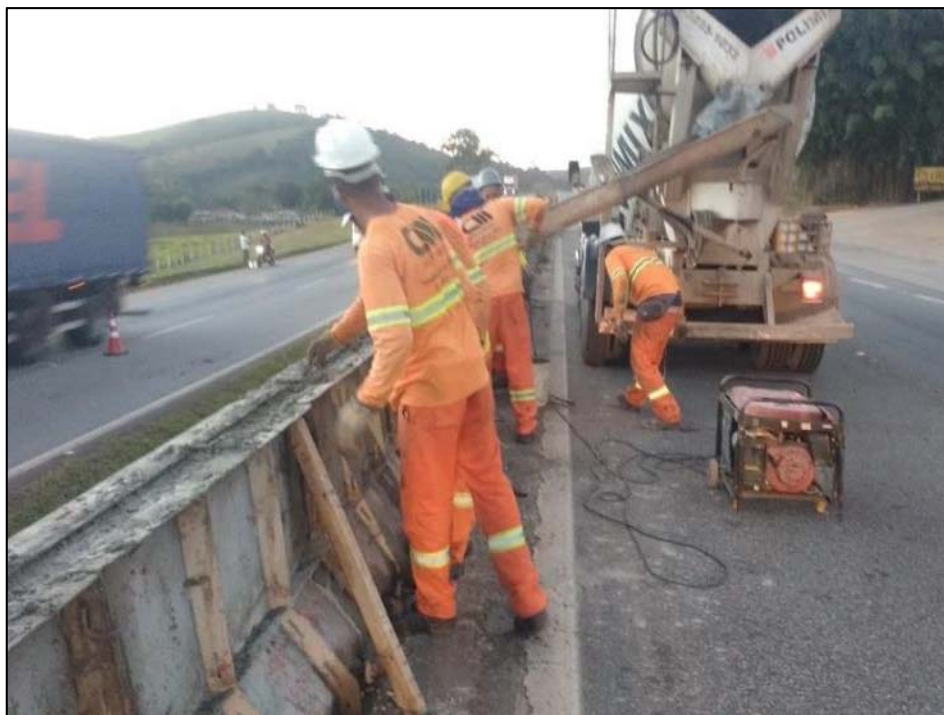
Figura 03 – Concretagem de barreiras
