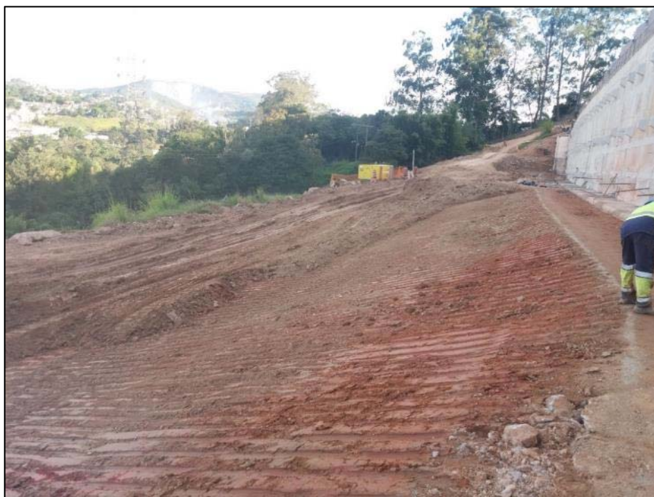
Figura 02 – Execução de Terraplenagem.
