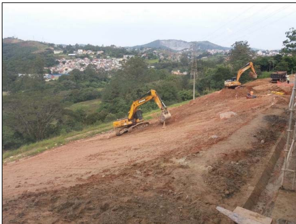
Figura 04 – Execução de Terraplenagem.
