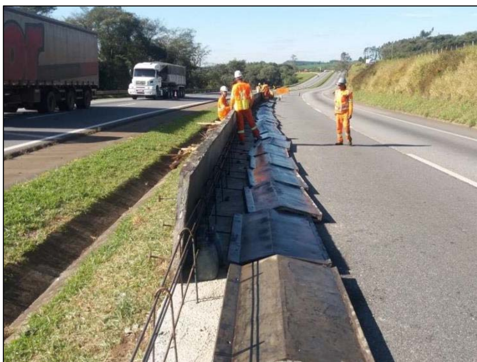
Figura 02 – Montagem de formas para concretagem
