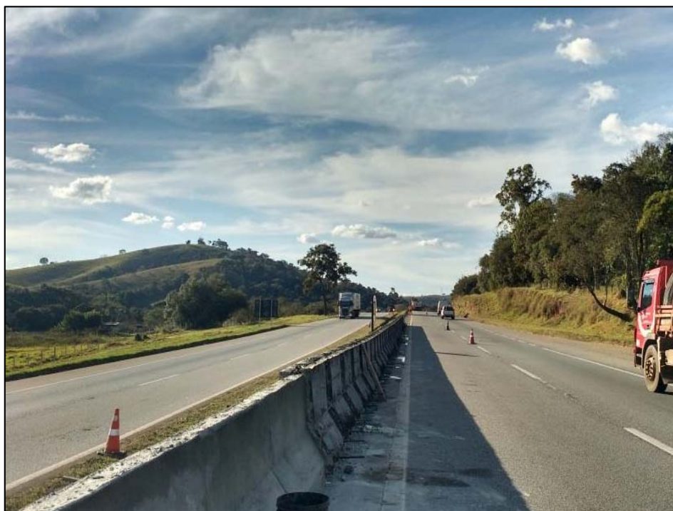
Figura 04 – Concretagem de barreiras
