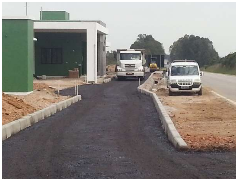
Figura 04 – Construção Bases Operacionais BR-116 km 607+000 LE
