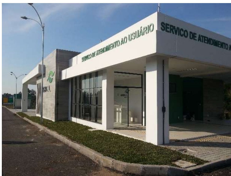
Figura 02 – Construção Bases Operacionais BR-116 km 492+000 LE
