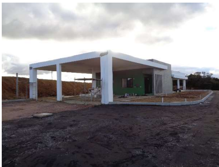
Figura 05 – Construção Bases Operacionais BR-116 km 125+700 LE
