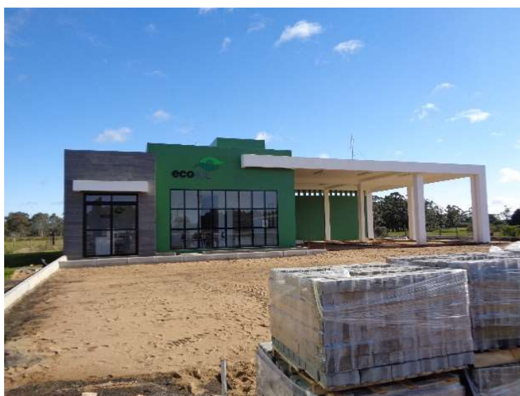
Figura 03 – Construção Bases Operacionais BR-116 km 524+000 LD
