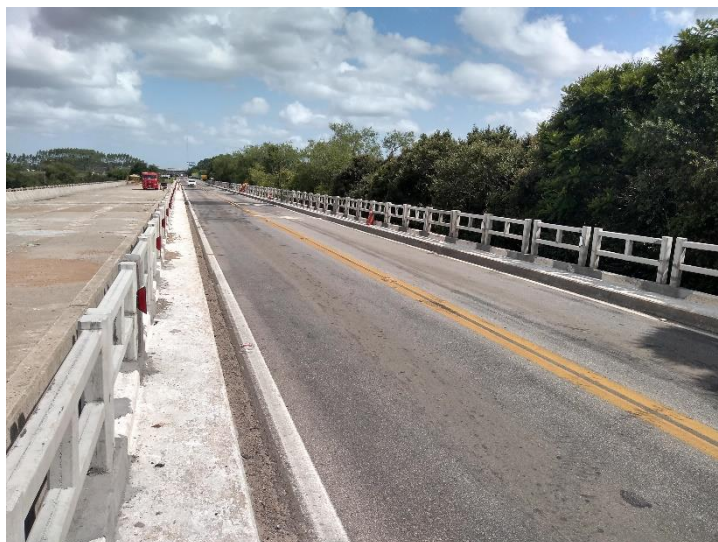
Figura 02 – Serviços de recuperação de OAE Evaristo BR-116/RS – Trecho Camaquã – Pelotas / km 492+569
