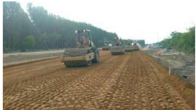
*Retorno em Nível - 172+000/MG: Compactação da base do pavimento*
