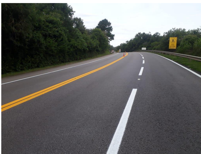
Figura 03 – Serviços de Sinalização Horizontal BR-116/RS – Trecho: Pelotas – Santana da Boa Vista / km 083+000
