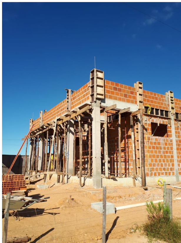
Figura 04 – Conclusão da alvenaria de vedação – Base Operacional - BR-392/RS – Trecho: Pelotas – Rio Grande / km 033,059
