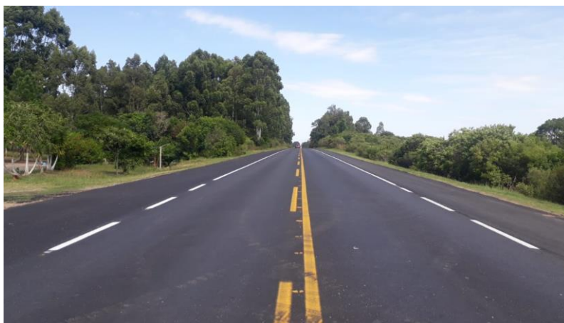
Figura 02 – Serviços de Pavimentação BR-116/RS – Trecho: Pelotas – Jaguarão / km 635,000
